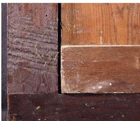
Fig. 16. Detalle del ensamble a horquilla que caracteriza el sistema de montaje del marco.
