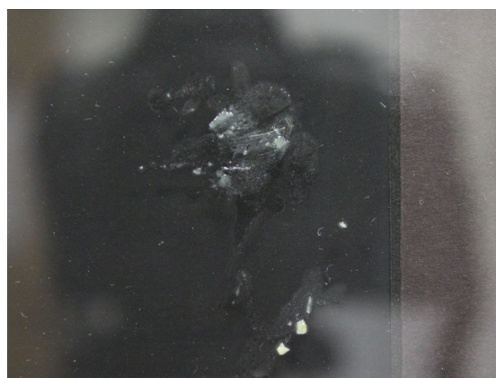
Figura 5: Residuo pegajoso en el cristal de la obra, en la parte inferior derecha.
