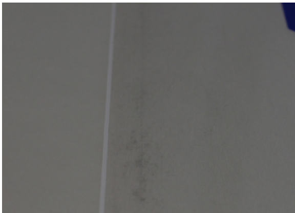
Figura 4: Suciedad en los bordes de la obra.
