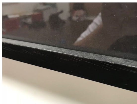
Figura 5: Acumulación de polvo en el marco de la obra.
