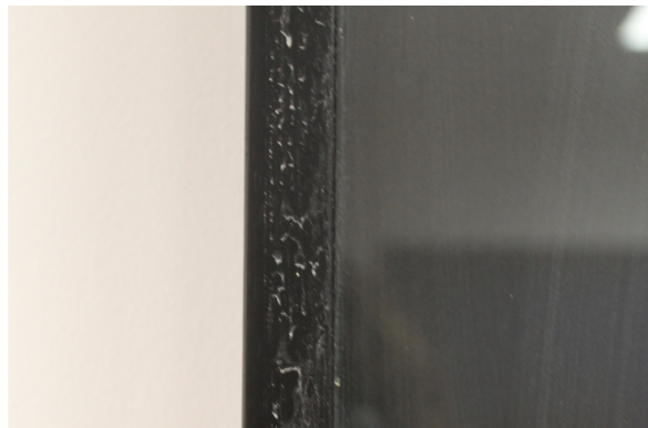
Figura 5: Suciedad del marco a causa de una limpieza desadecuada.
