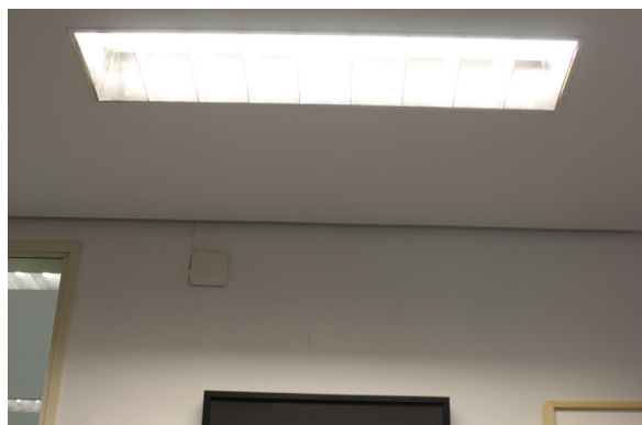
Figura 6: Foco que ilumina directamente la obra.
