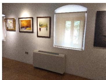
15. Obra sobre sistema de calefacción.
