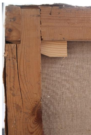
13.. Rotura del bastidor.
