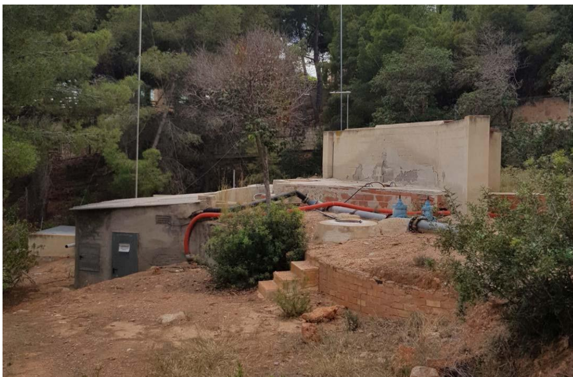
Figura 14. Fotografía de las instalaciones exteriores de los depósitos Gemelos.
