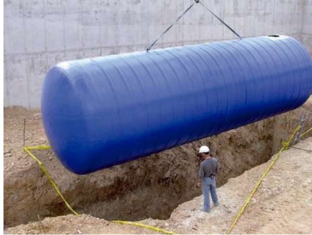
FIGURA 8: DEPÓSITO SUBTERRÁNEO DE LA MARCA MIRAPLAS
