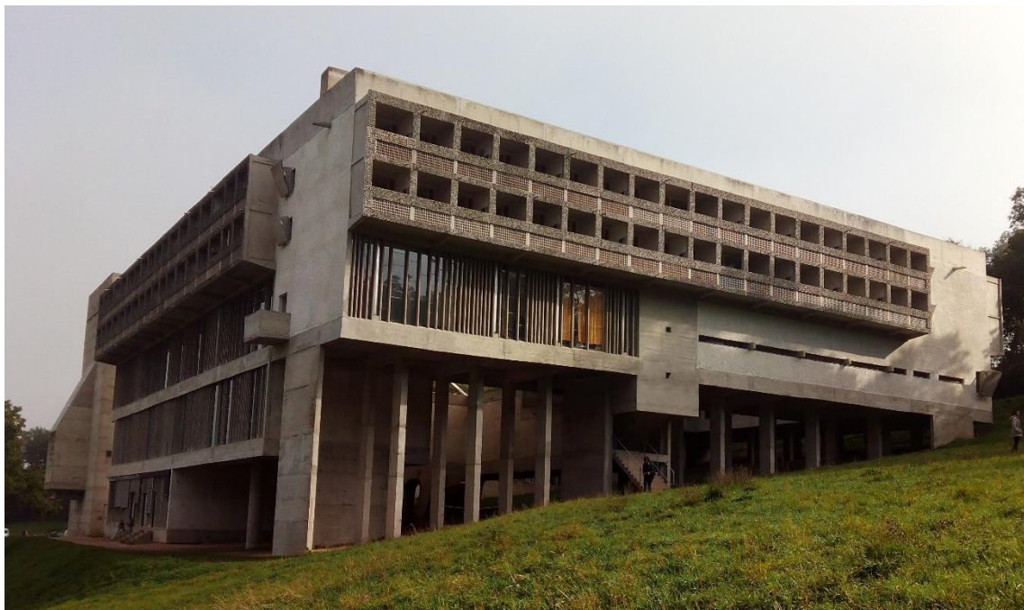
Imagen 144: Vista de las fachadas sur y oeste
