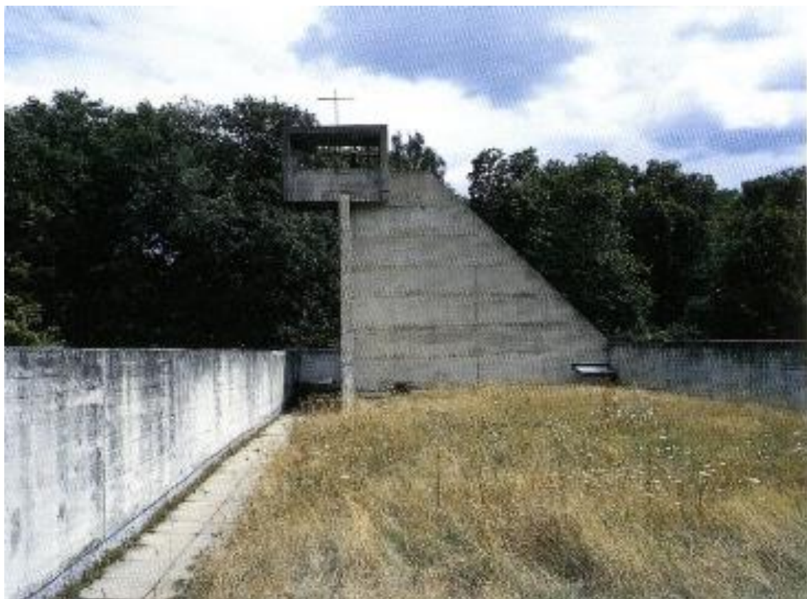
Imagen 105: Vista del campanario desde la cubierta de la iglesia
