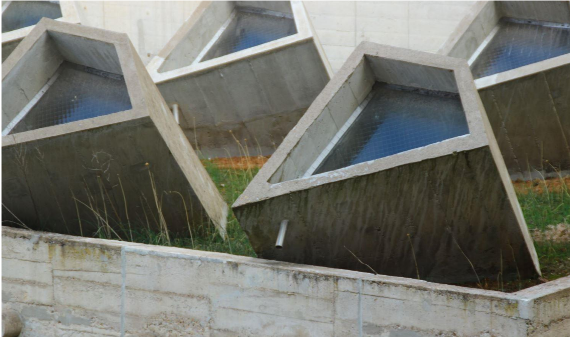
Imagen 85: Detalle de los lucernarios de la sacristía
