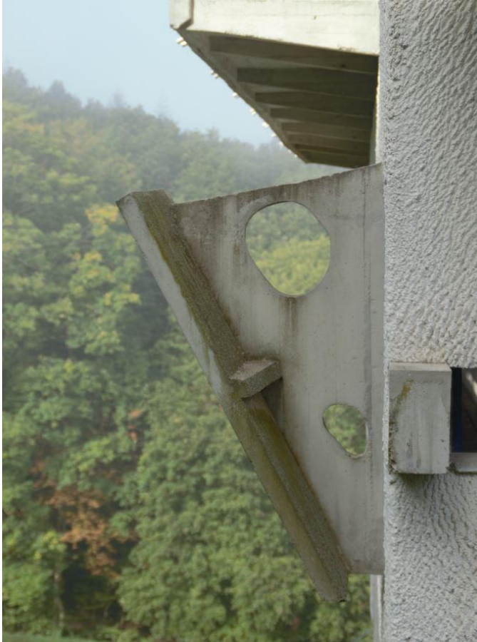
Imagen 142: Detalle de los deflectores de luz
