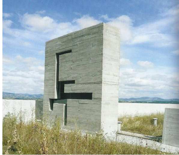
Imagen 110: Perspectiva de la caja de escalera que llega hasta la cubierta
