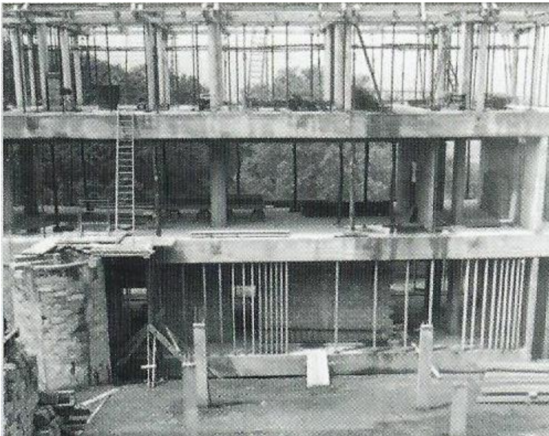
Imagen 77: Construcción del ala oeste
