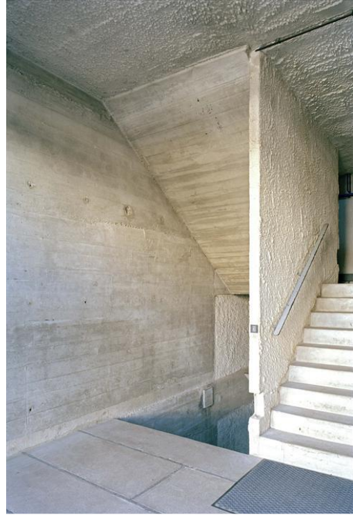
Imagen 118: Vista de las escaleras principales del edificio conventual
