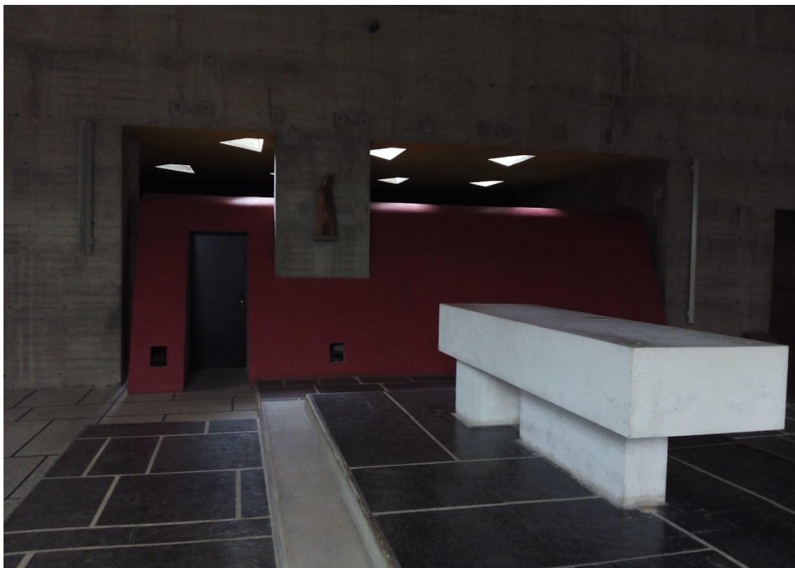
Imagen 63: Sacristía vista desde el interior de la iglesia
