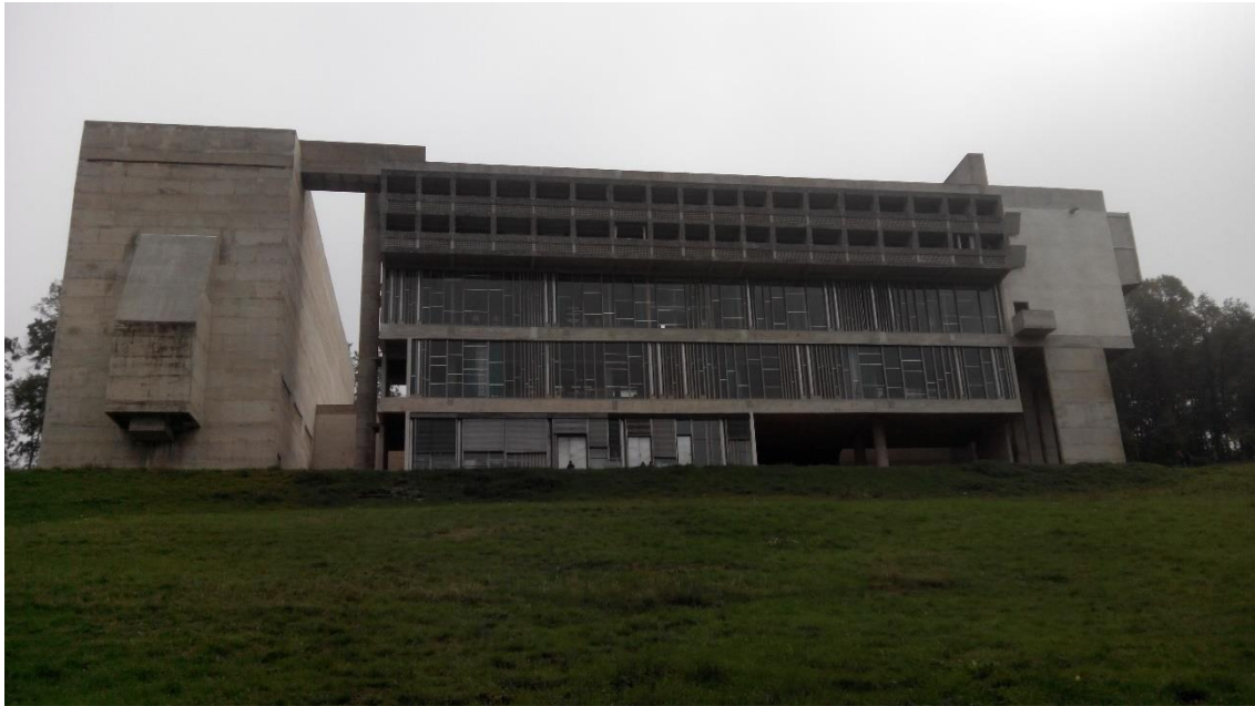
Imagen 47: Vista exterior alzado oeste
