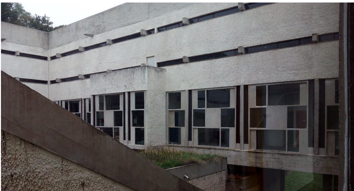
Imagen 48: Vista del patio interior
