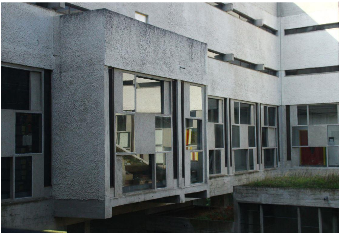
Imagen 156: Vista de los paños de vidrio
