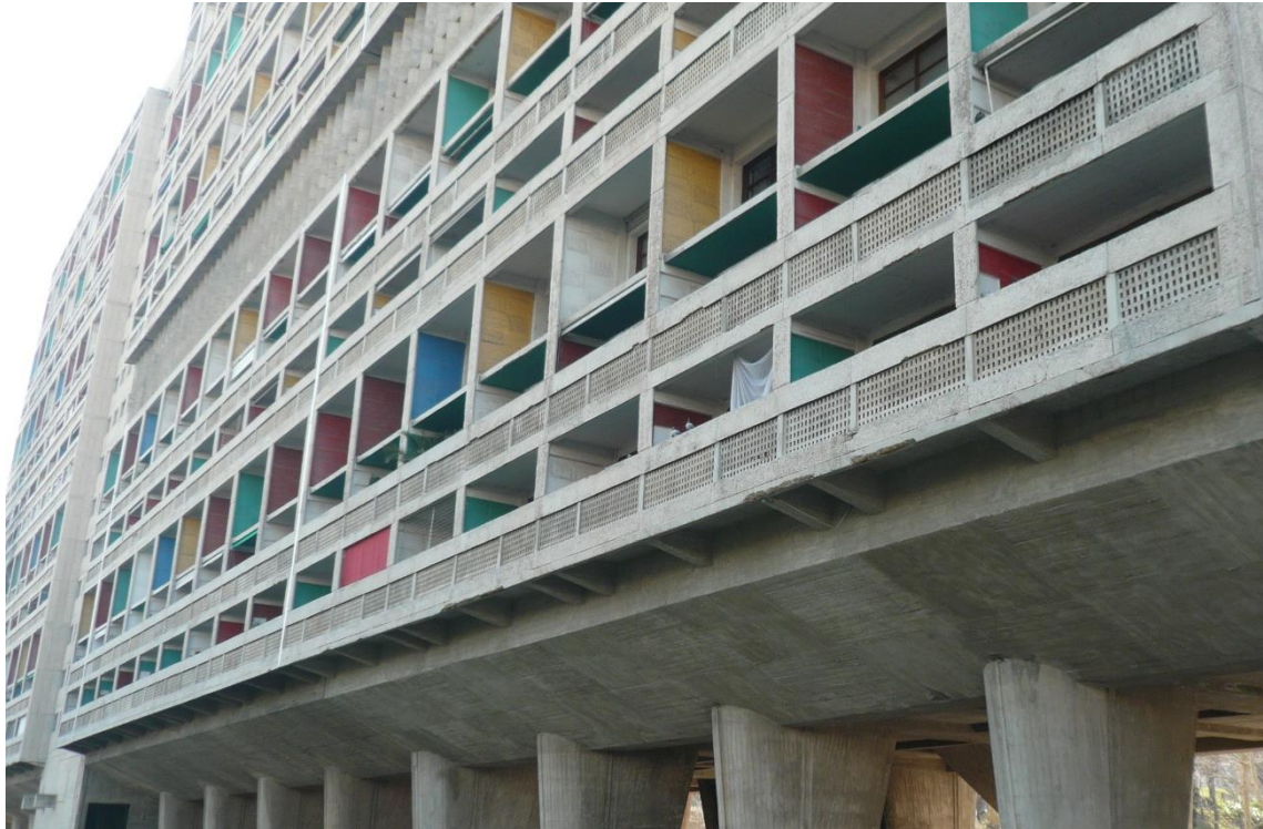
Imagen 166: Unité d'habitation de Nantes
