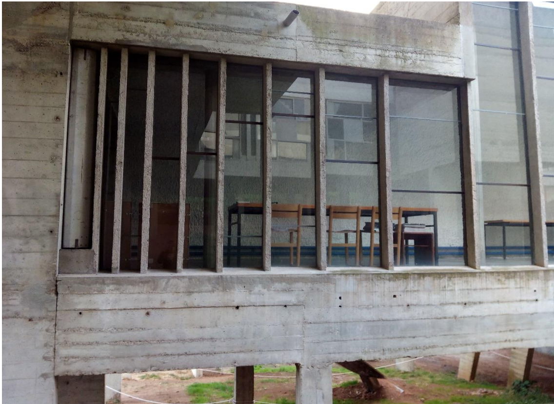
Imagen 78: Paneles ondulatorios del atrio desde el exterior
