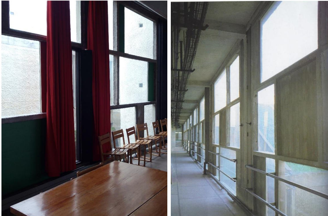
Imagen 93: Detalle de los paneles de vidrio con aireadores
