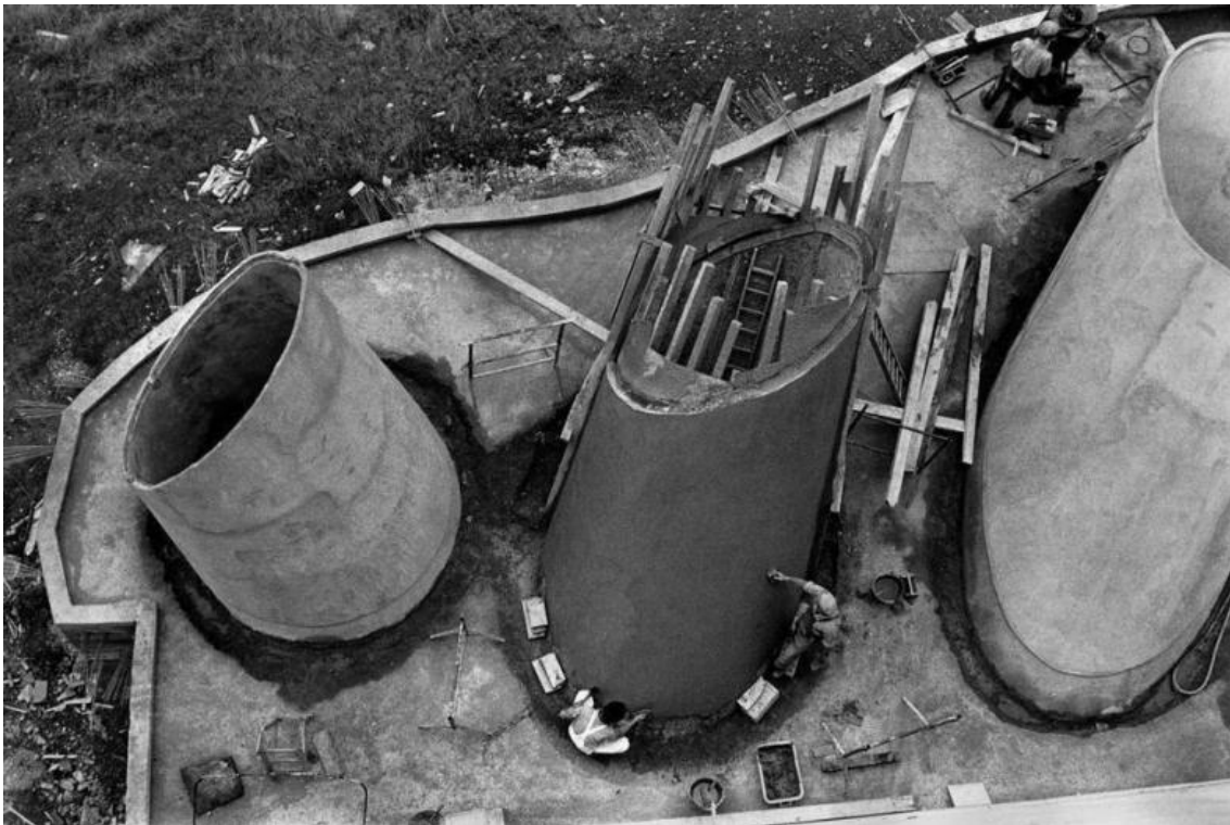
Imagen 137: Vista de los encofrados de los lucernarios
