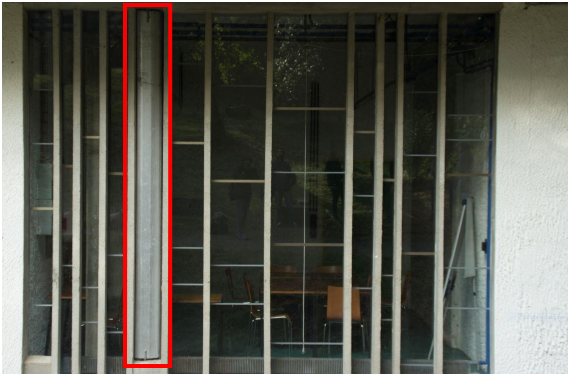
Imagen 92: Detalle de los paneles ondulatorios con aireador
