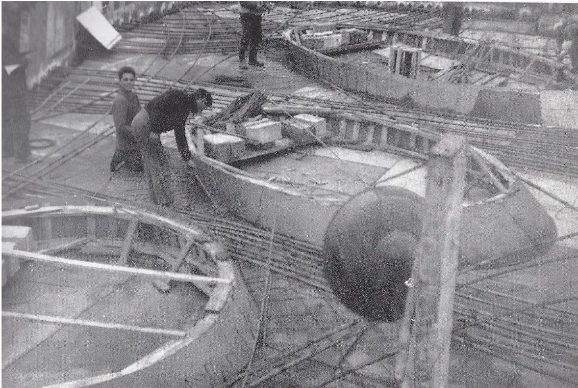
Imagen 136: Vista de los encofrados de los lucernarios
