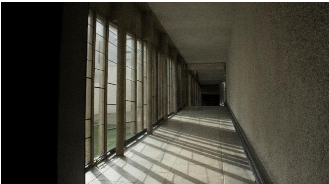
Imagen 49: Vista interior del pasillo más largo
