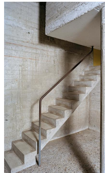
Imagen 116: Escalera de la sacristía
