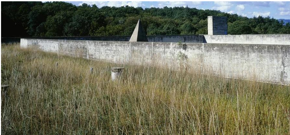
Imagen 94: Cubierta del ala este
