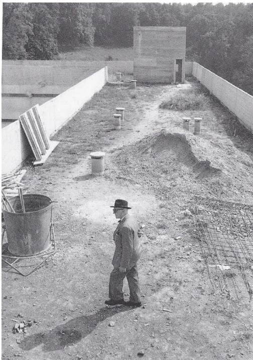
Imagen 108: Vista de la cubierta del ala oeste
