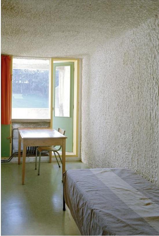
Imagen 126: Vista interior de una celda con los acabados
