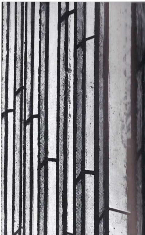
Imagen 79: Detalle de los paneles ondulatorios
