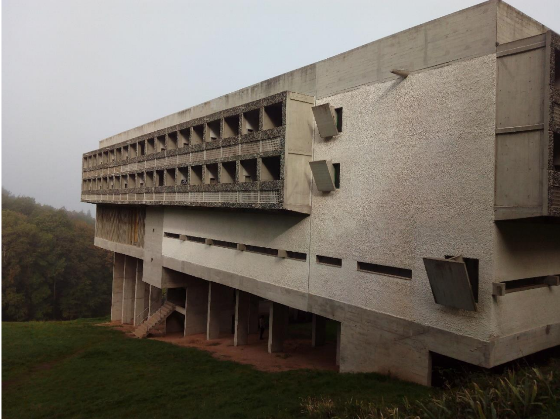
Imagen 45: Vista exterior alzado sur
