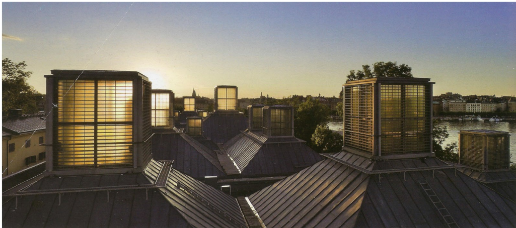
Fig.246 - Vista de las linternas de la cubierta
