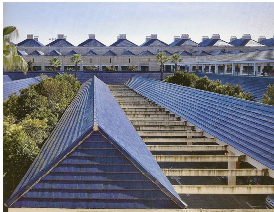
Fig.182 - Vista de las cubiertas
