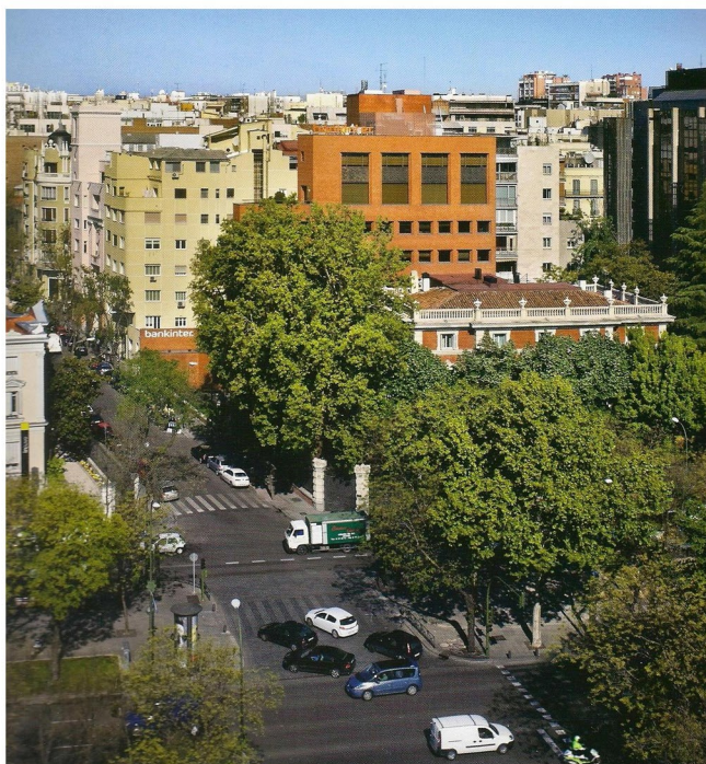
Fig.172 - Vista aérea del edificio
