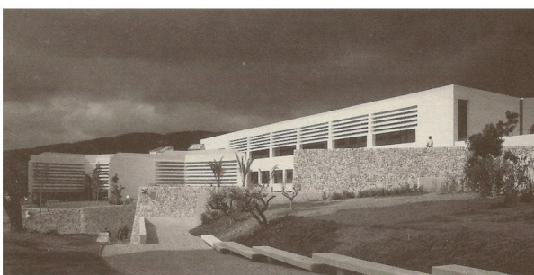
Fig.236 - Vista exterior de la fachada de celosías
