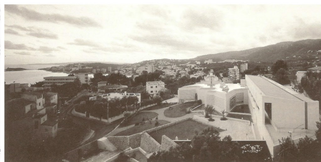
Fig.235 - Vista aérea del emplazamiento
