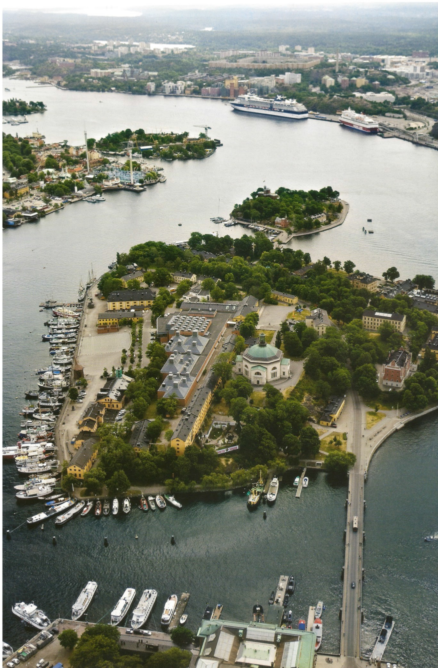
Fig.238 - Vista aérea del edificio
