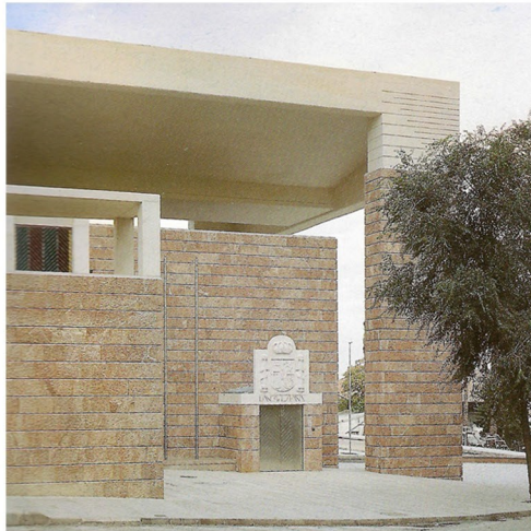
Fig.192 - Detalle de los pilares de la entrada
