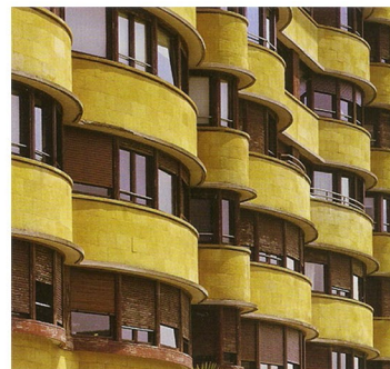
Fig.157 - Detalle de las "ondulaciones" de la fachada
