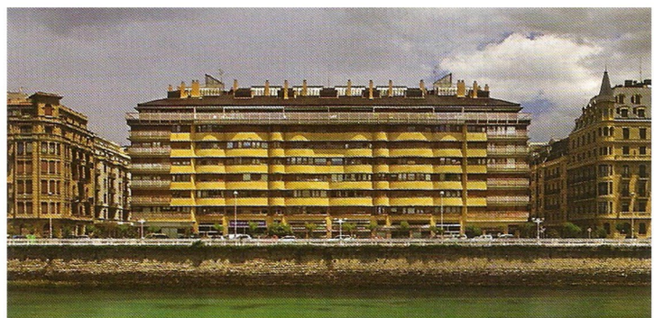
Fig.155 - Vista exterior del edificio desde la otra parte del Río Urumea
