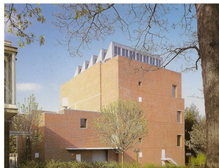
Fig.197 - Fachada del edificio
