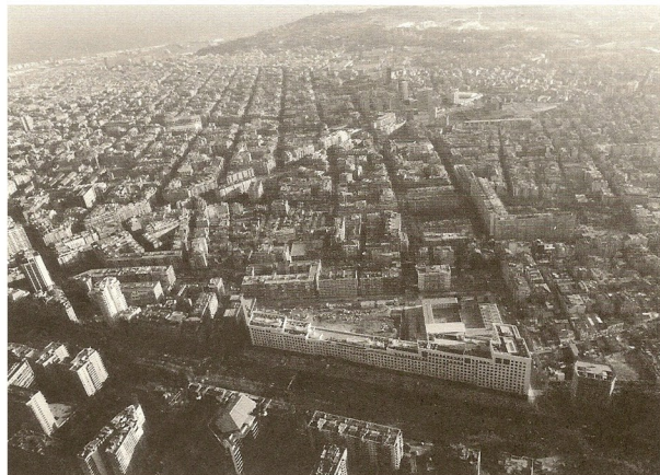
Fig.162 - Vista aérea de l'Illa de Barcelona en construcción, con la ciudad de fondo
