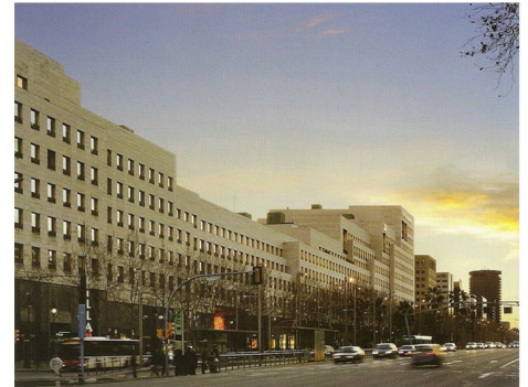
Fig.164 - Vista exterior de la fachada desde la Diagonal
