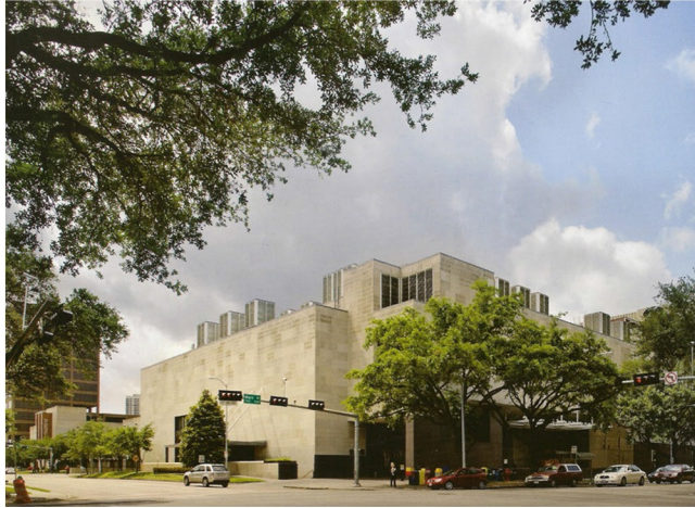
Fig.207 - Vista exterior del edificio
