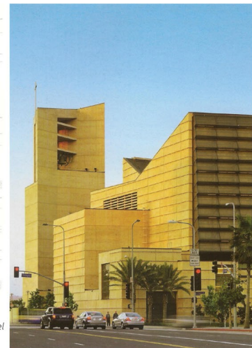
Fig.248 - Vista exterior del edificio
