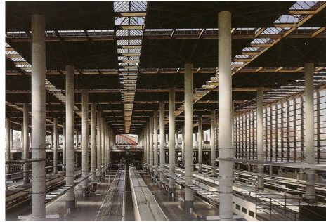
Fig.178 - Interior ampliación andén
