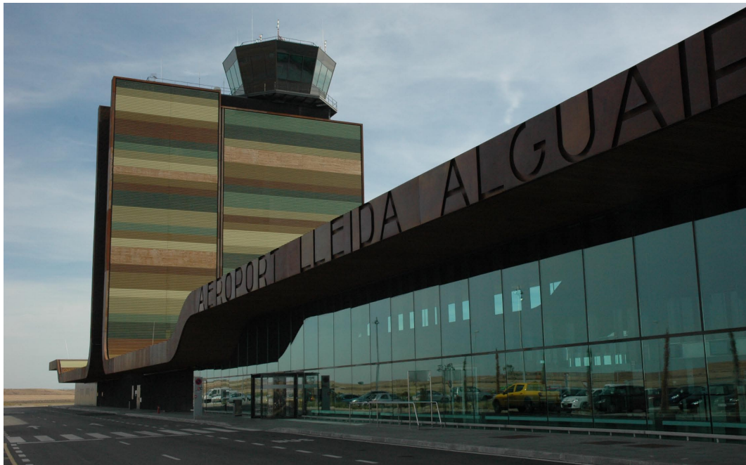
B720 Fermín Vázquez Arquitectos, Aeropuerto de Lleida , 2010, (fotografía I.C.),
