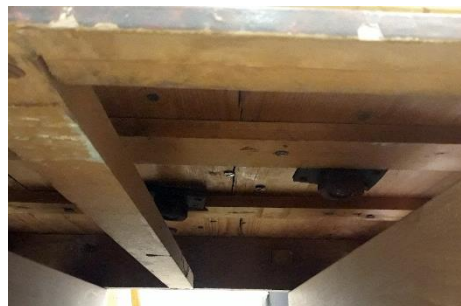
Figura 15. Detalle del sistema de sujeción del conjunto de Santiago Matamoros-caballo a la peana.
