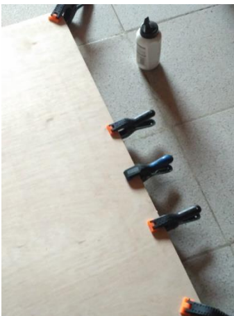
Fig. 18. Adhesión del contrachapado al bastidor
