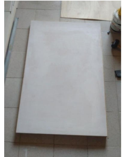
Fig. 21. Imprimación del soporte por capas respetando el secado después de cada aplicación
