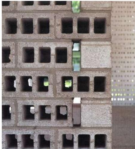
Fig.17. Detalle de esquina bloque de hormigón
