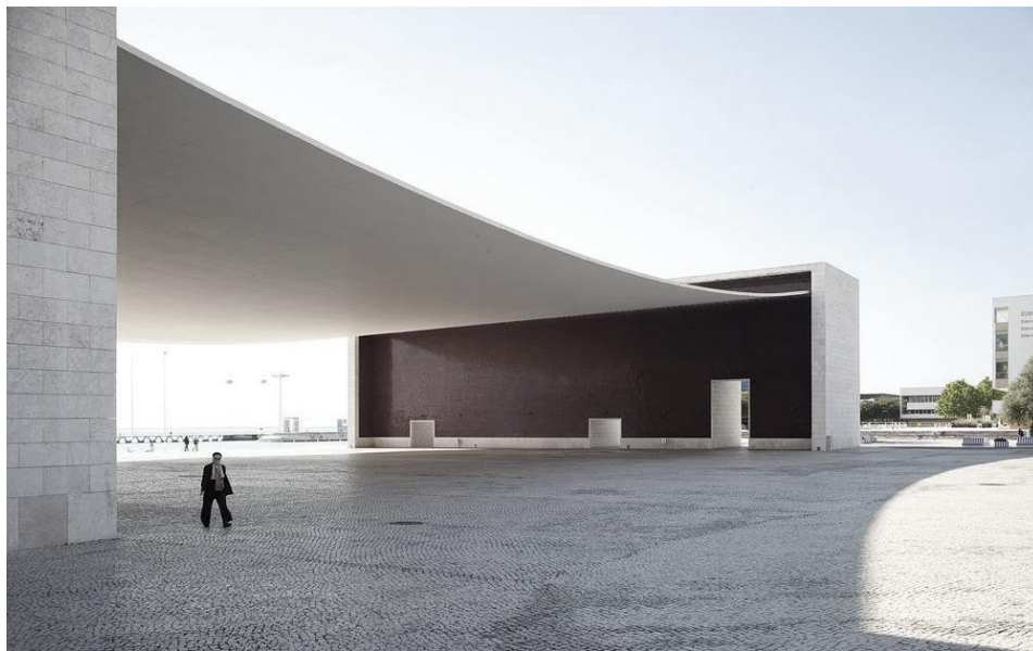
Imagen 3.10 Detalle materialidad interior de los pórticos
