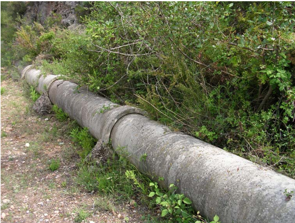
FOTOGRAFÍA Nº33: “Aparición del Canal Alt en forma de canalización tubular”.
