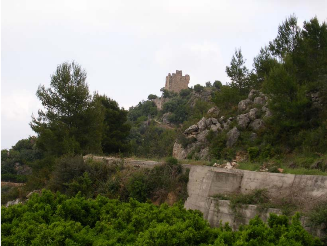
FOTOGRAFÍA Nº27: “Zonas peligrosas por posibles caídas”.
