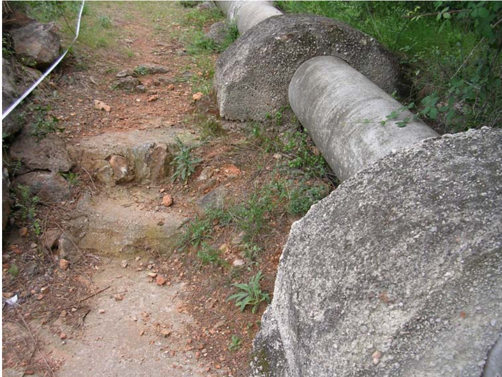
FOTOGRAFÍA Nº36: “Existencia de escalones para salvar la pendiente en mal estado”.
