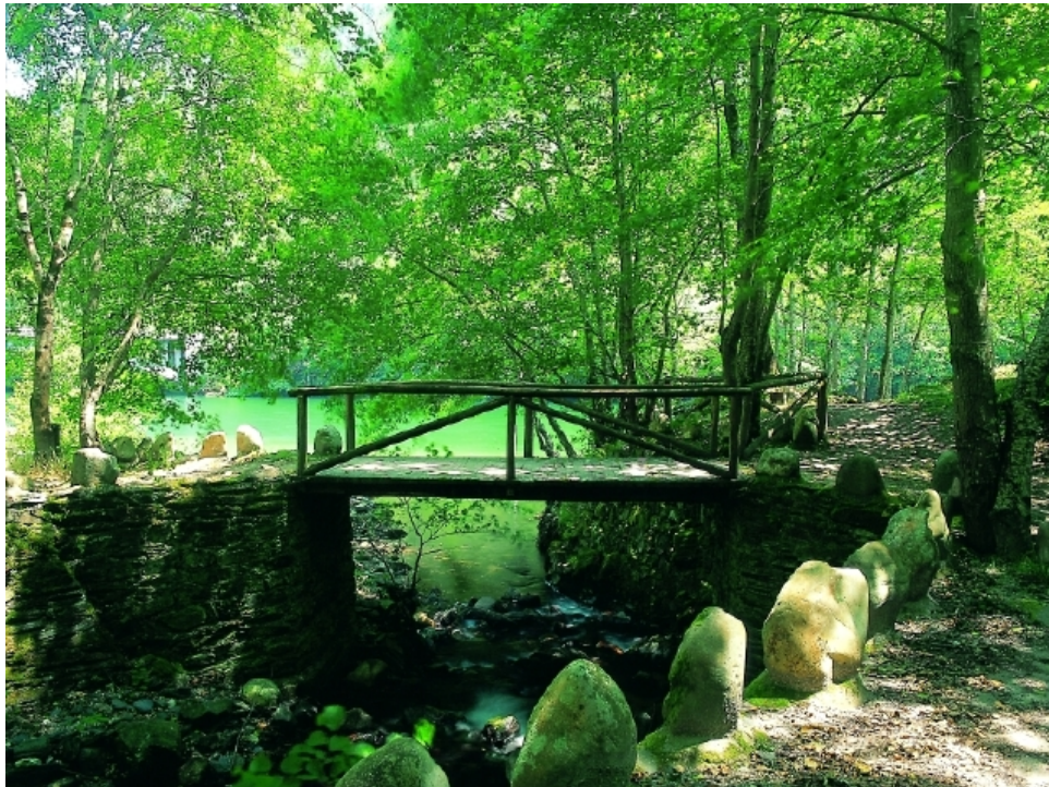
FOTOGRAFÍA N°75: “Tipo de pasarela de madera”.
