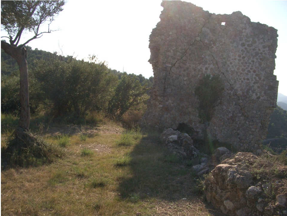
FOTOGRAFÍA N°73: “Restos de la Torre de la zona F”.
