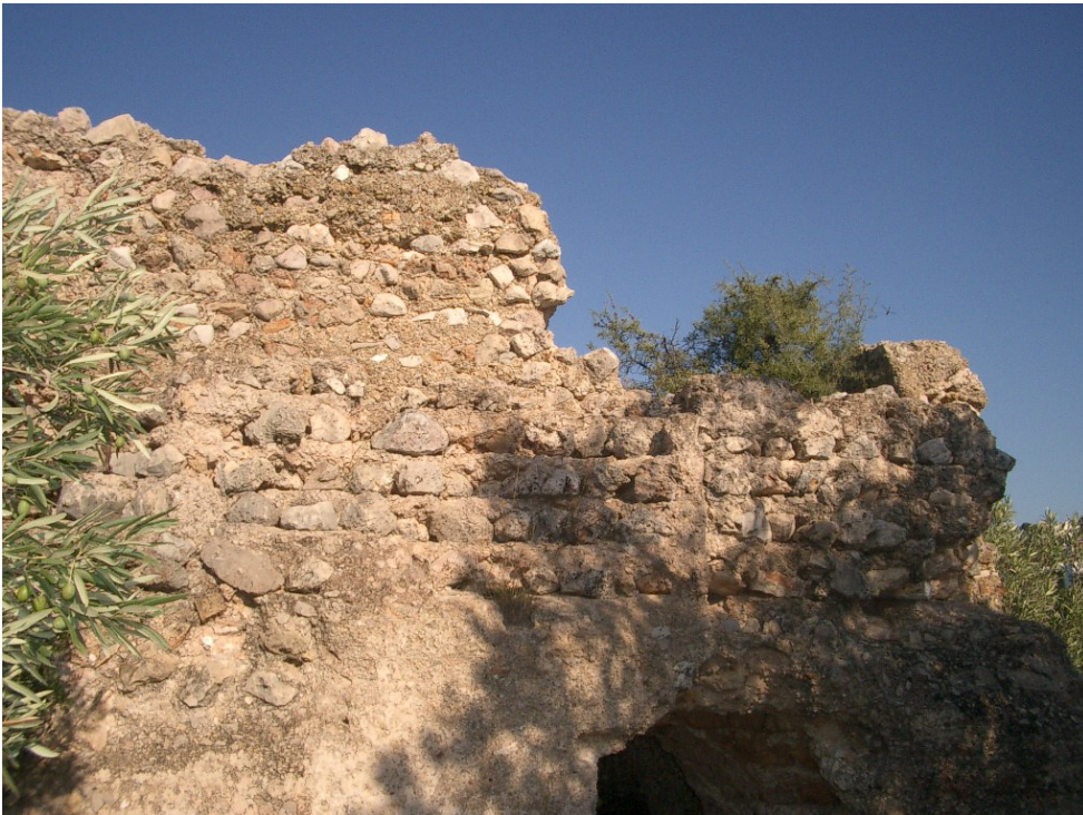
FOTOGRAFÍA N°74: “Detalle de la Torre de la zona F”.
