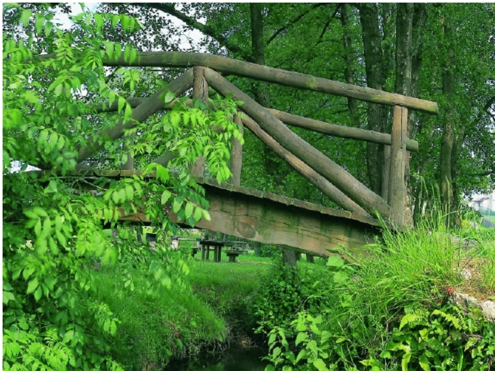
FOTOGRAFÍA N°76: “Tipo de puente de madera”.
