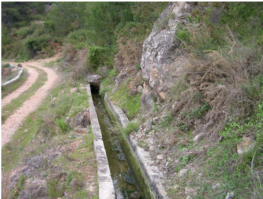
FOTOGRAFÍA Nº44: “Paso del segundo tramo del camino al tercero”.
