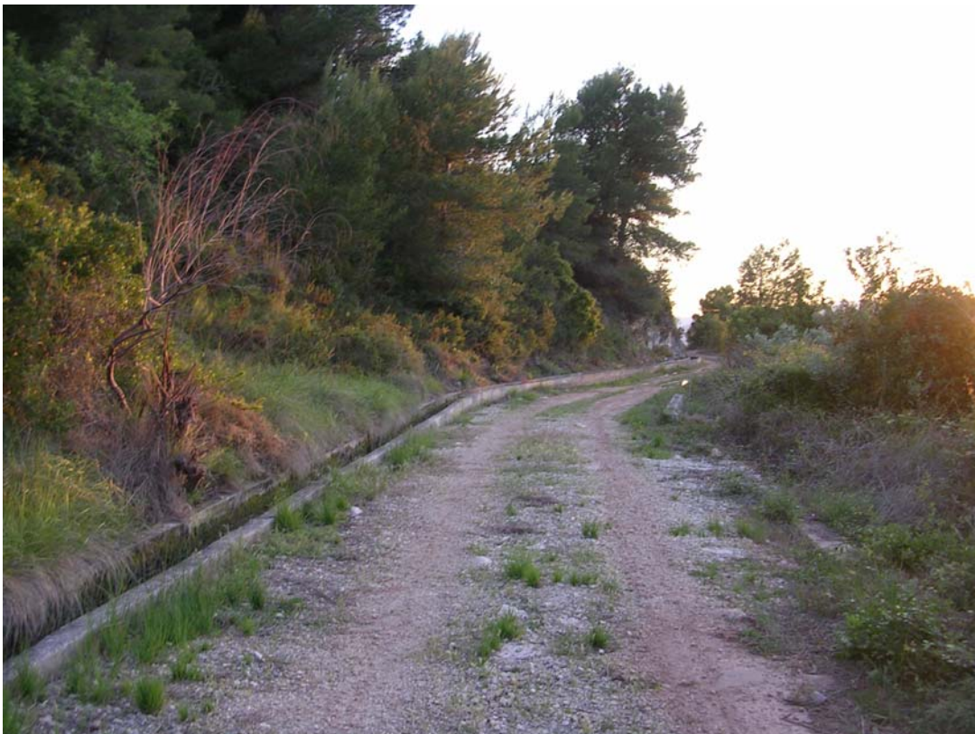
FOTOGRAFÍA Nº30: “Tramo ancho con vegetación en mal estado a ambos lados”.
