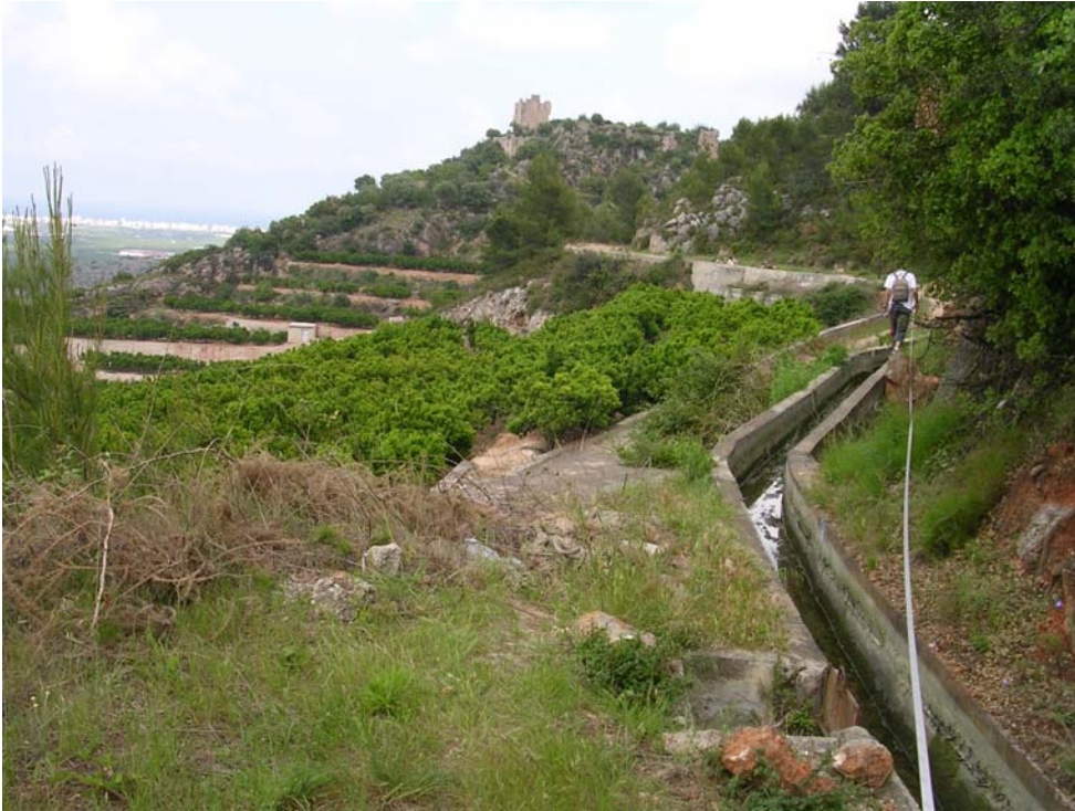
FOTOGRAFÍA Nº43: “Zona de paso peligrosas”.
