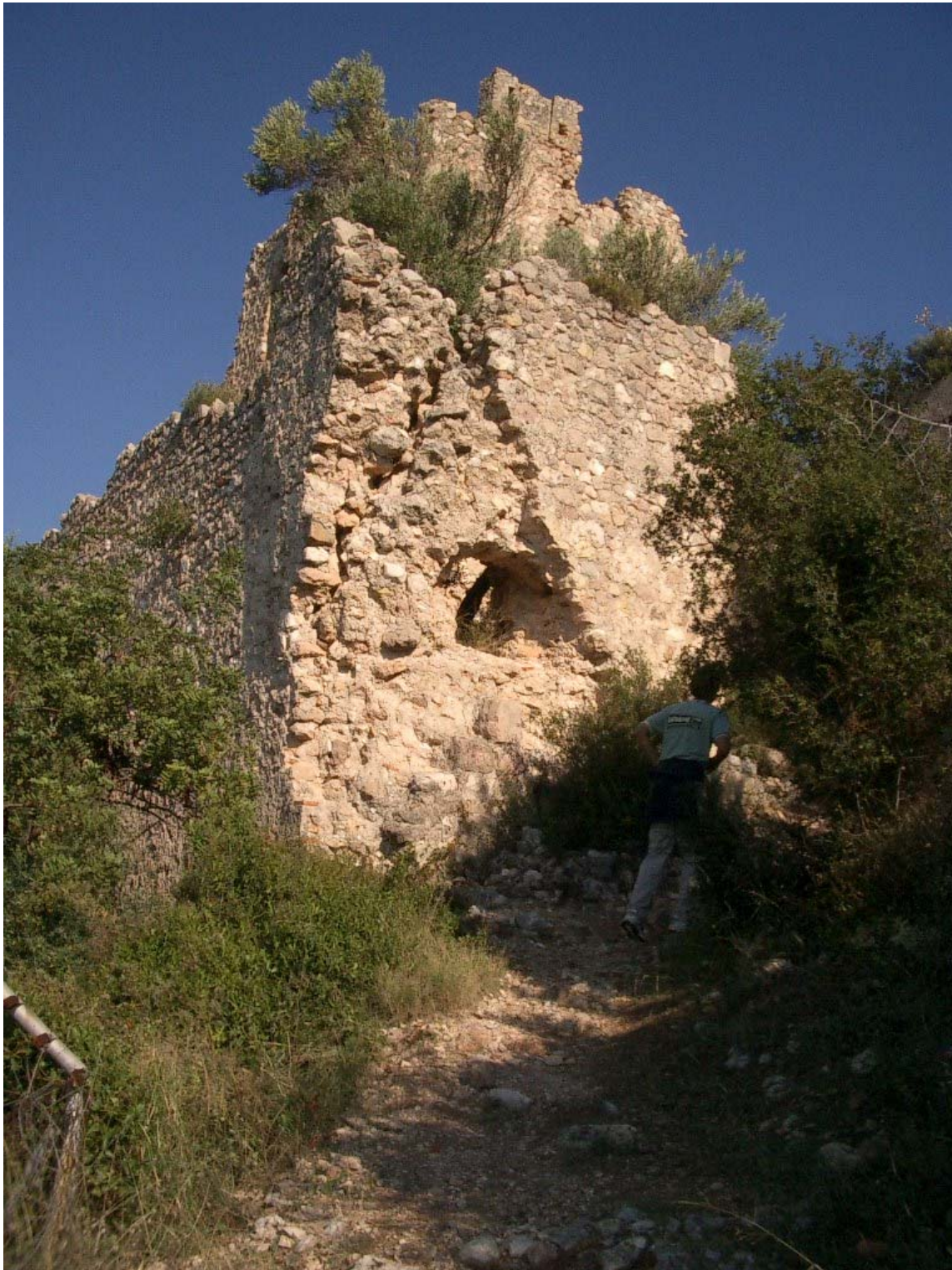
FOTOGRAFÍA Nº49: “Acceso al Castell del Rebollet”.
