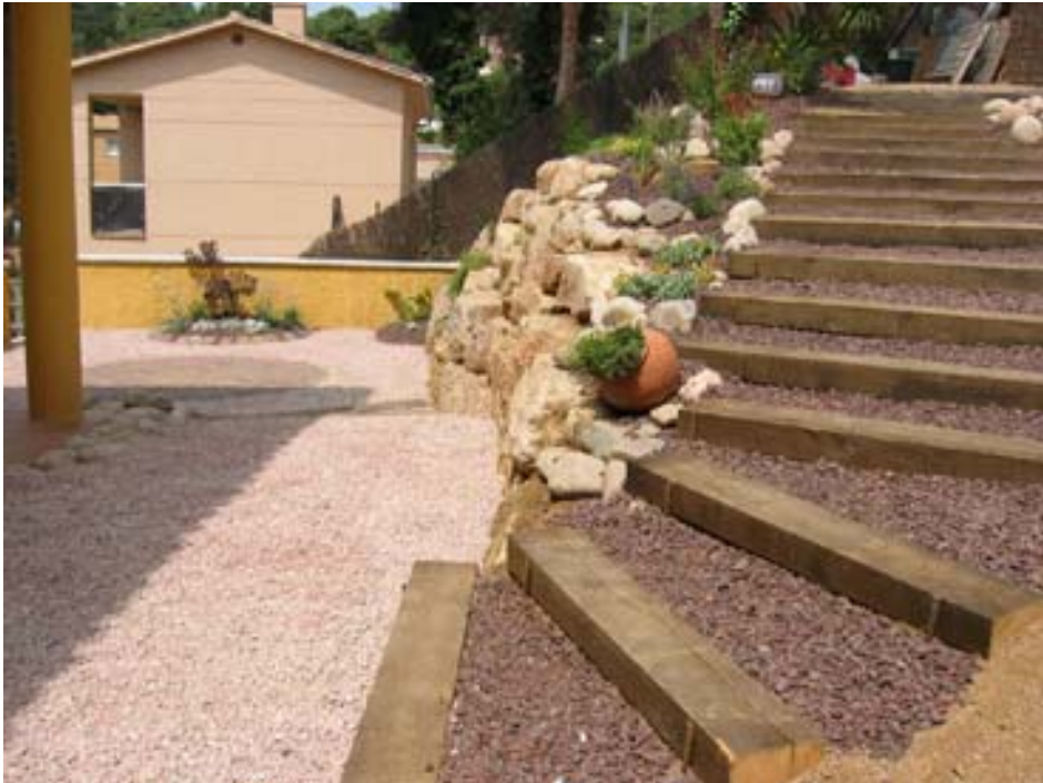
FOTOGRAFÍA N°81: “Tipo de escalones de madera. Traviesas”.
