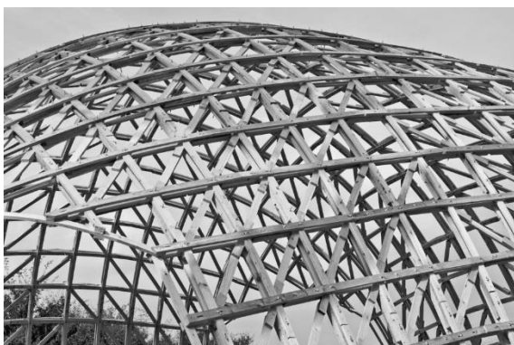
Fig.7: Primera estructura Gridshell, Vladimir Shújov, 1896
