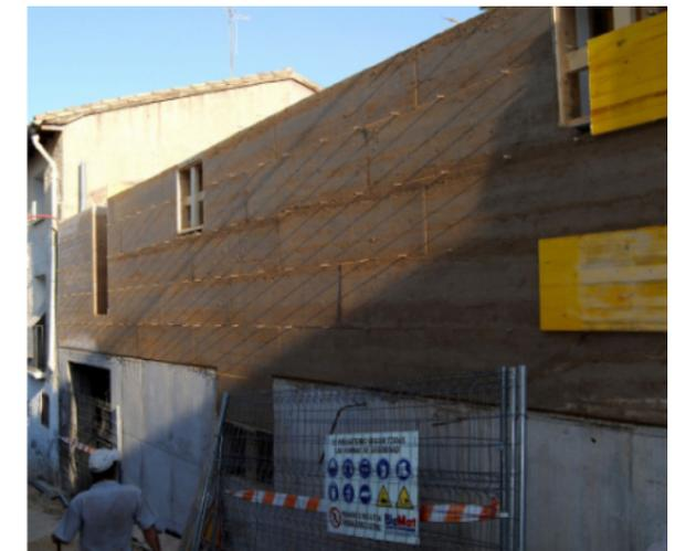
Imagen 5.11.5. Muros de tierra sin revestir.
