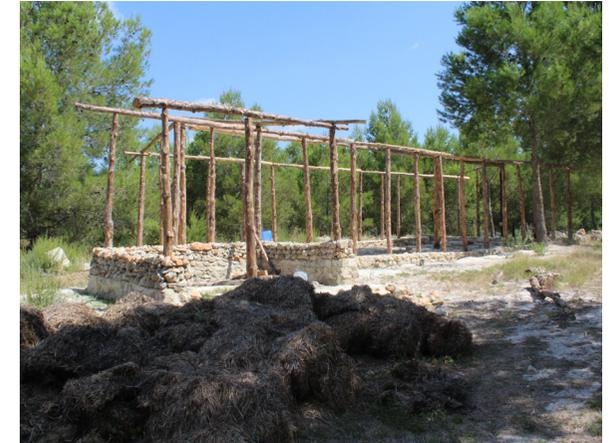
Imagen 6.1.13. Estructura edificio multiusos
