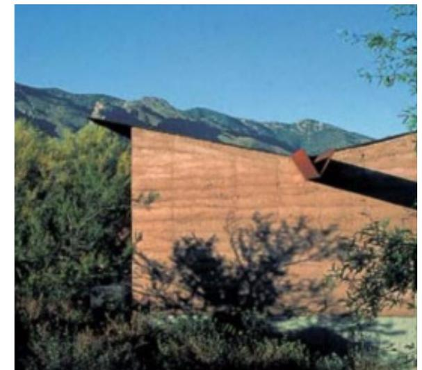
Imagen 4.4. Palmer-Rose House. Muro de tierra con canal de evacuación que lo protege del agua de la lluvia.
