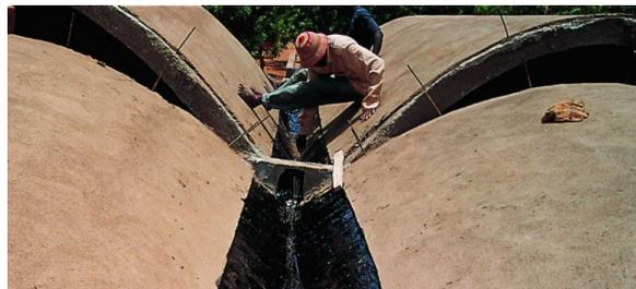
Imagen 5.4.7. Impermeabilización cubiertas.
