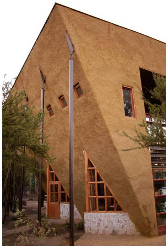
Imagen 5.6.3. Muros inclinados gracias a la quincha metálica.
