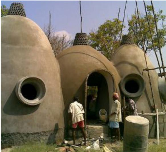
Imagen 5.1.1. Revestimiento de mortero de tierra.
