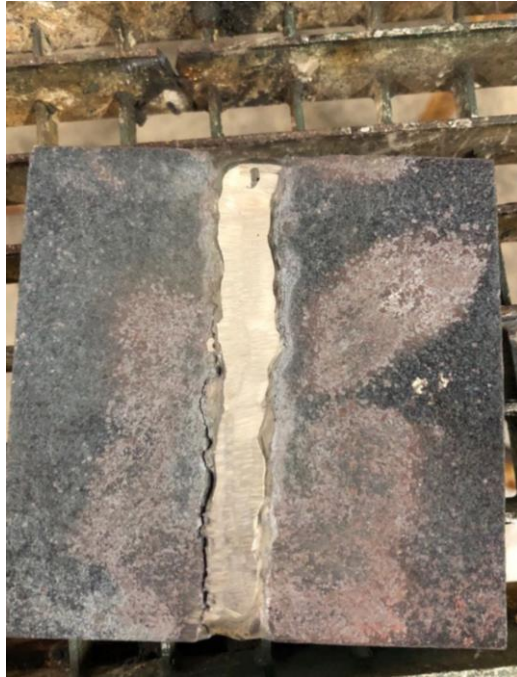
Ilustración 27. Cordón de soldadura terminado con precocido
