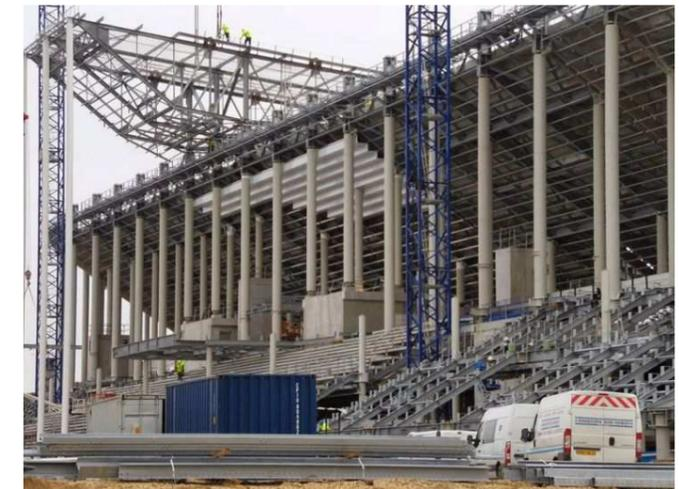
Fig.143. – Construcción de las vigas de la cubierta.
