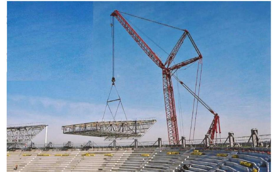
Fig.66. – Elevación de la pieza por la grúa Liebherr 1600/2.
