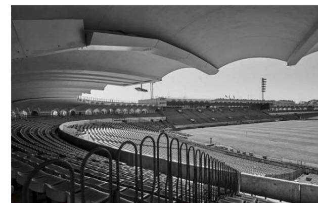
Fig.31. – Voladizo de la cubierta del Estadio Chaban-Delmas.
