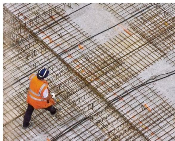
Fig.55. – Construcción de la baldosa de hormigón armado.
