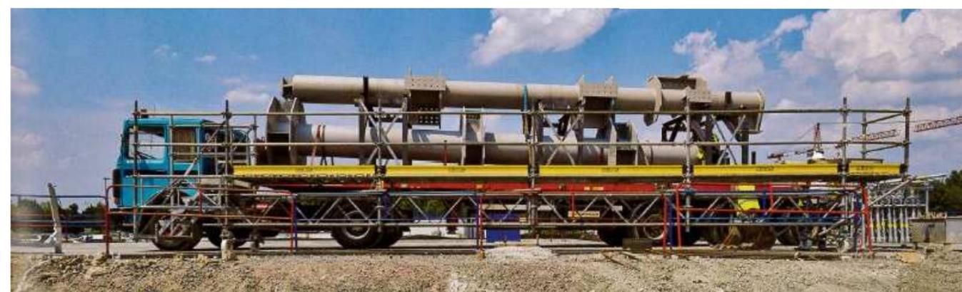
Fig.62. – Transporte de los pilares desde las fábricas a obra.
