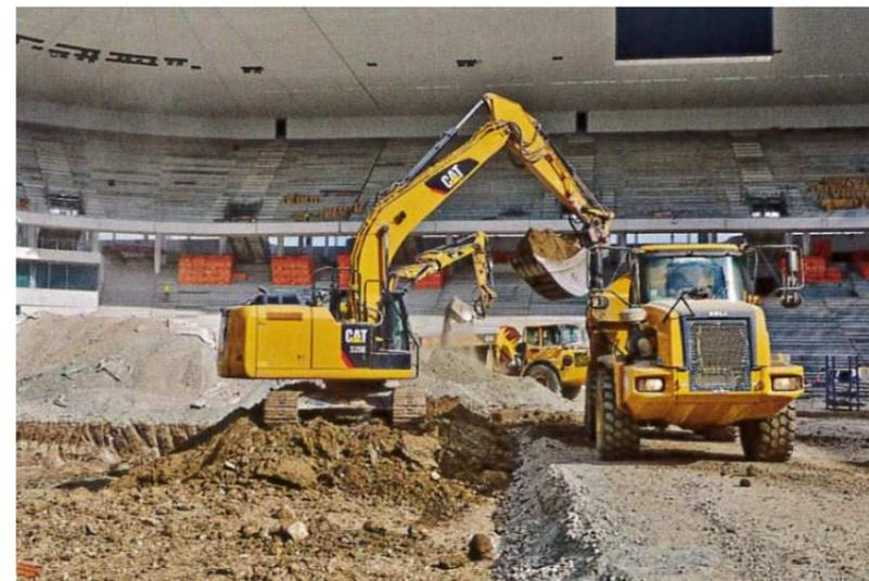
Fig.68. – Excavación del terreno para tener la altura deseada.
