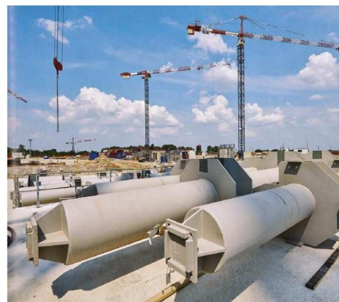
Fig.63. – Pilares metálicos a la espera de ser colocados.
