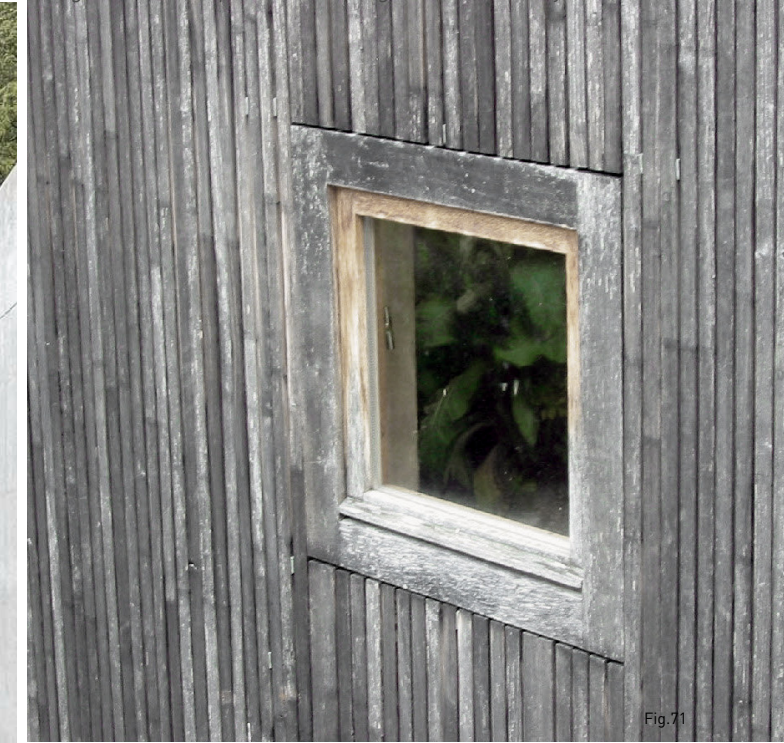
El Atelier Peter Zumthor. Construida en Haldenstein Graubünden, Suiza entre 1985-1986 Fotografía 1: © Ralph Feiner / Fotografía 2: © Carney, Dan 2004
