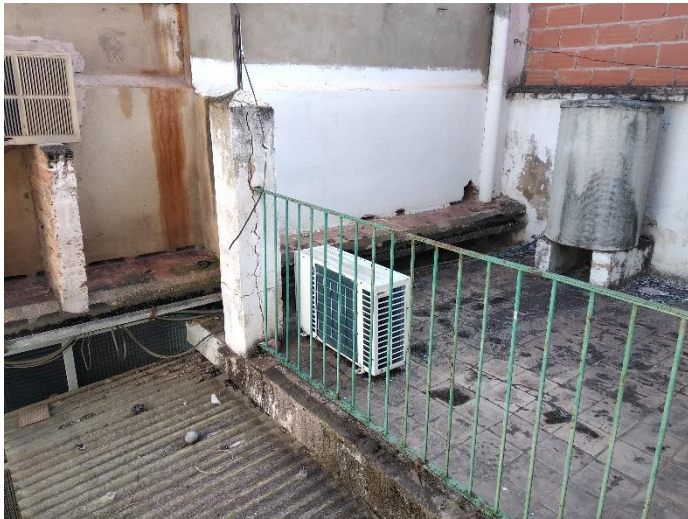
Fotografía 14 - Terraza en planta primera
