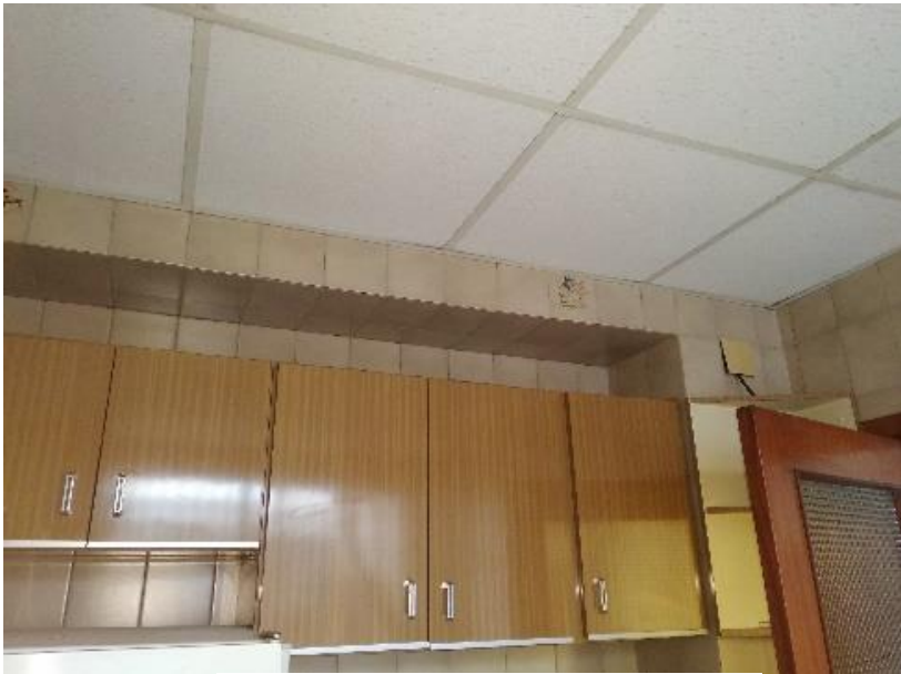
Ilustración 18- Falso techo cocina. Propia
