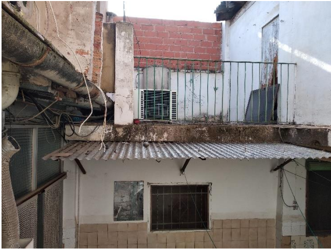
Fotografía 15 - Terraza en planta primera
