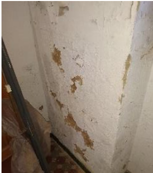
Ilustración 24-Muro fachada (interior). Propia
