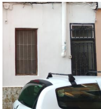
Ilustración 23- Bajante en fachada. Propia
