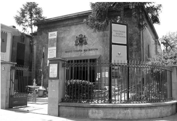
Img 18 Fotografía actual del exterior edificio museo
