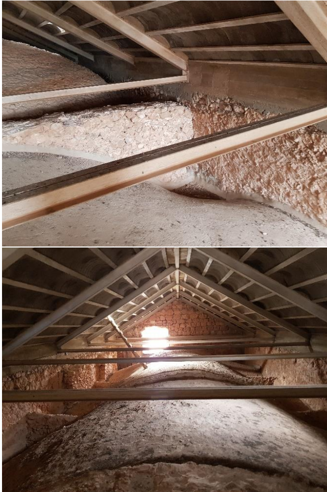
Figura 15. Fotografías del sistema de cubierta.
