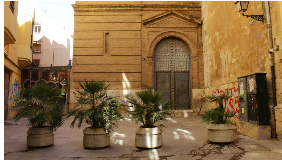
Figura 27. Puerta noroeste de la Iglesia de la Companyia.
