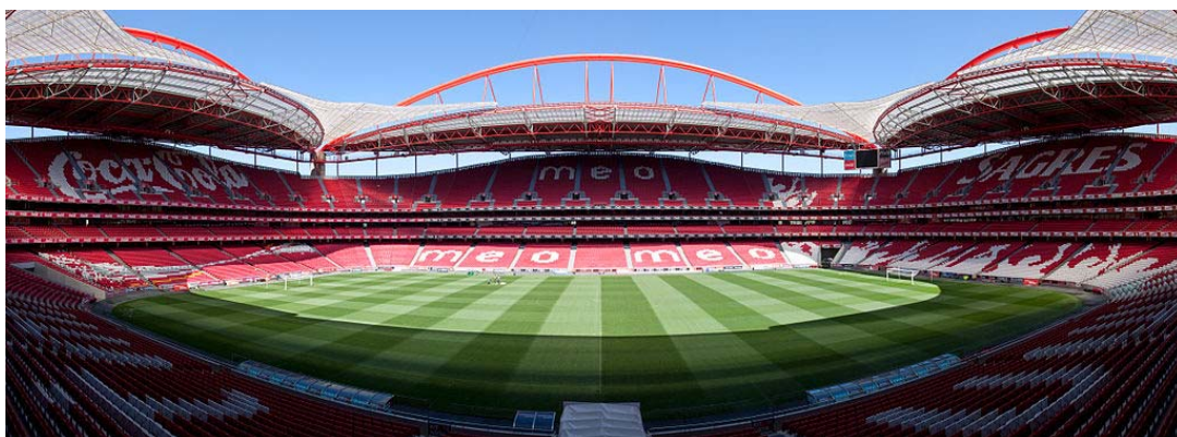
Fig. 17 Vista interior del estadio
