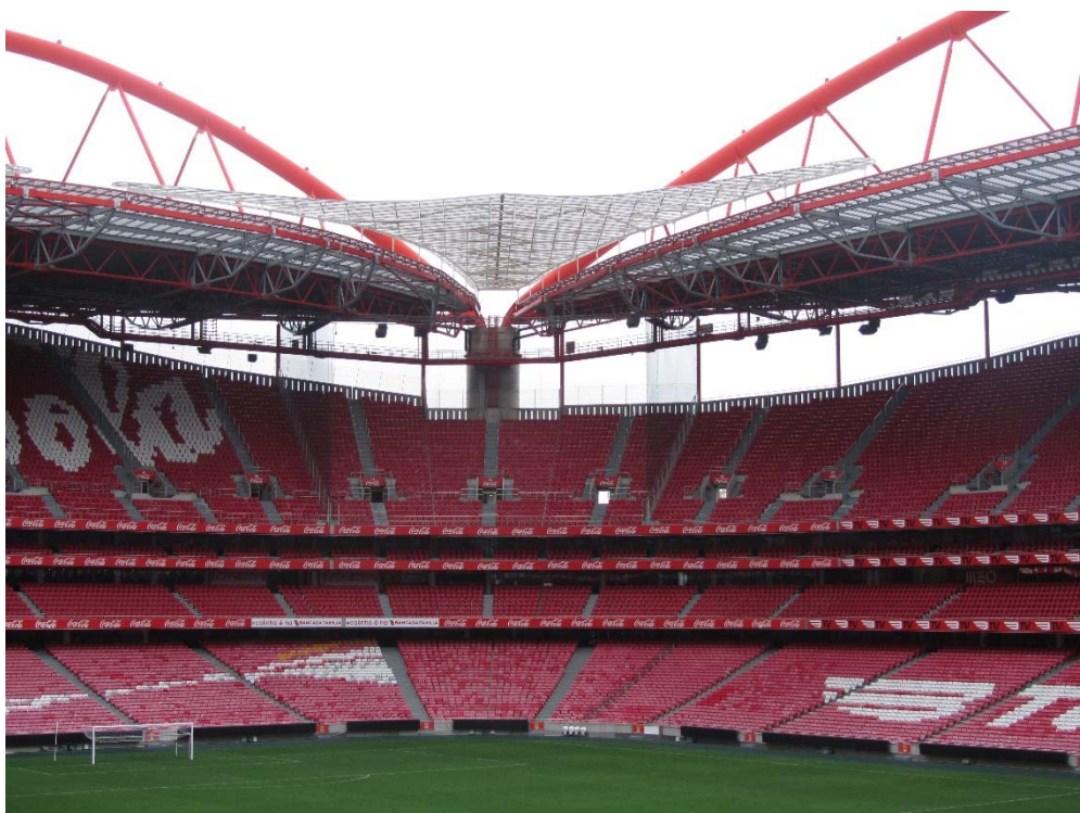
Fig. 64 Cubierta en la esquina del estadio
