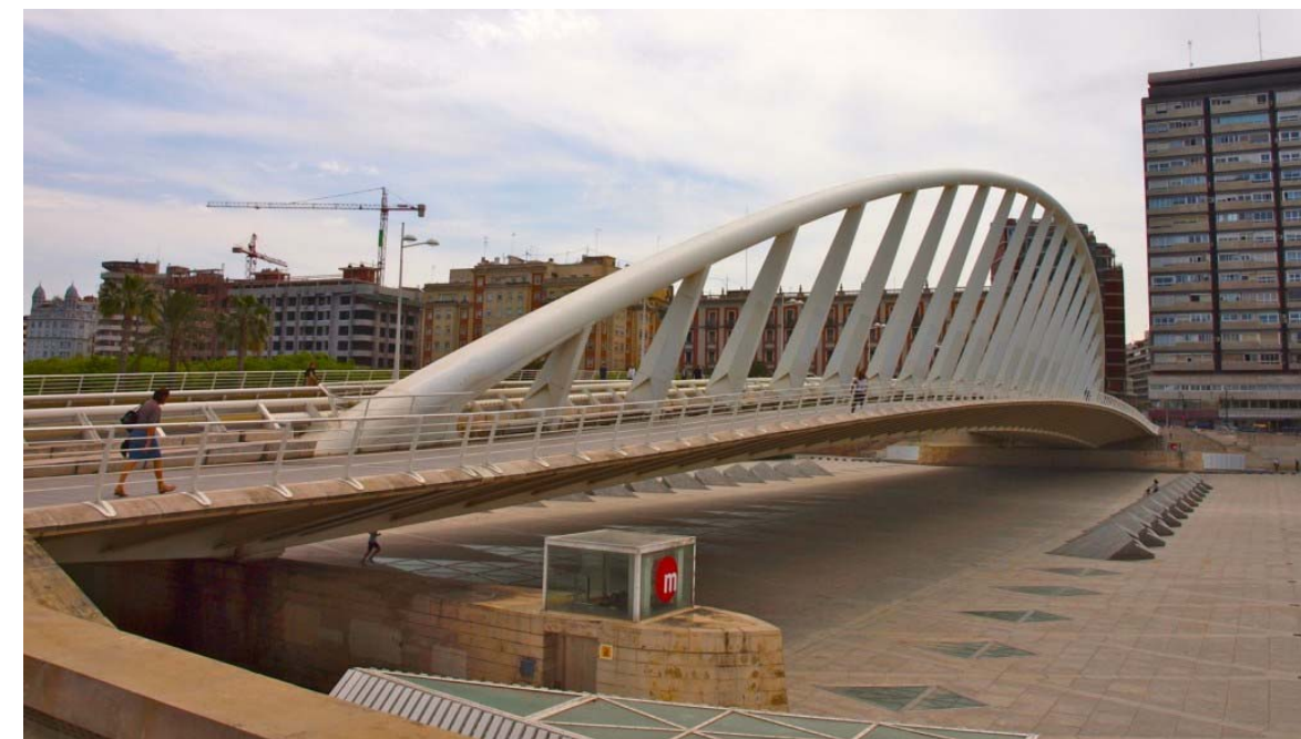
Fig. 23 Puente de la Alameda
