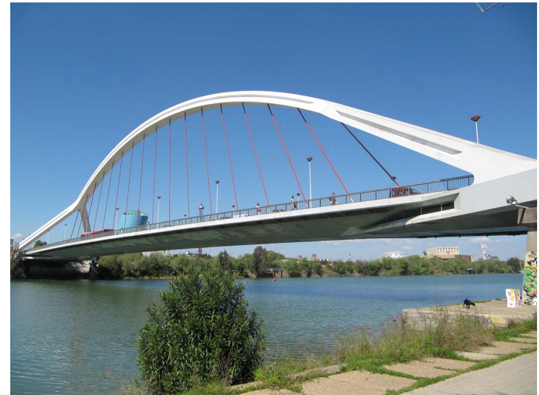
Fig. 26 Vista inferior Puente de la Barqueta
