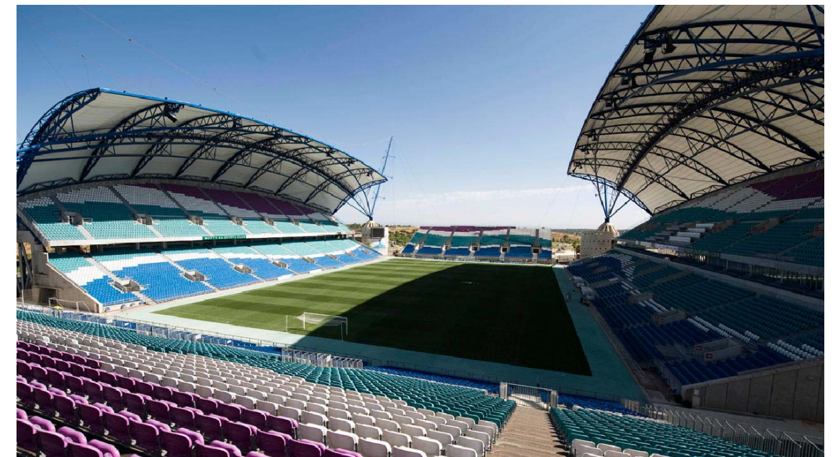
Fig. 30 Vista interior Estadio Algarve
