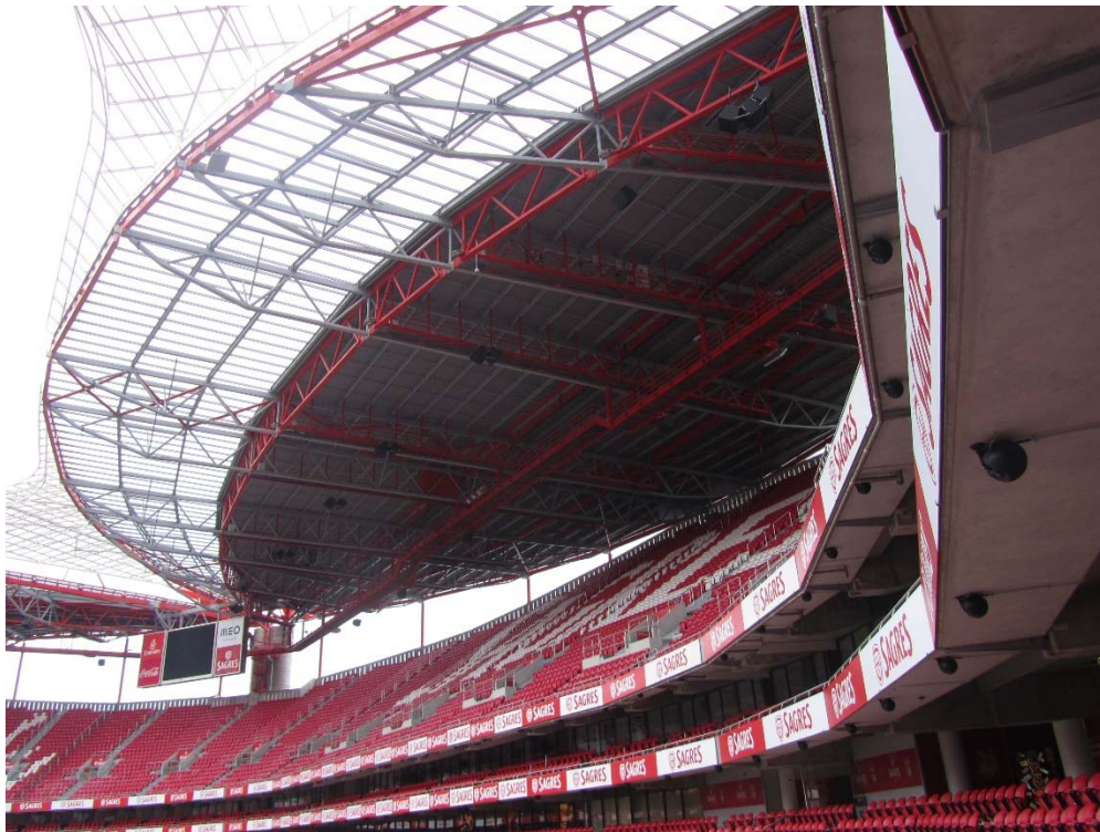
Fig. 63 Estructura inferior de la cubierta
