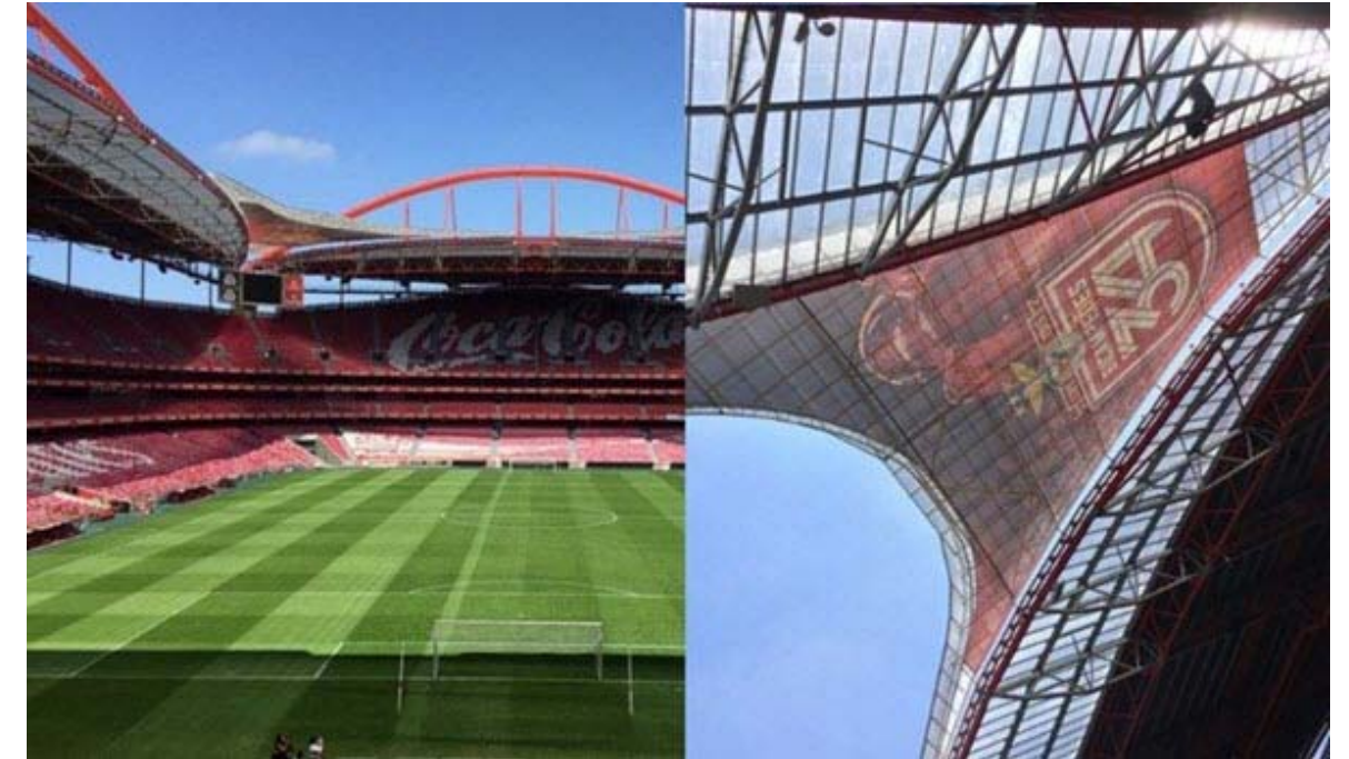
Fig. 61 Cubierta de Policarbonato translucido
