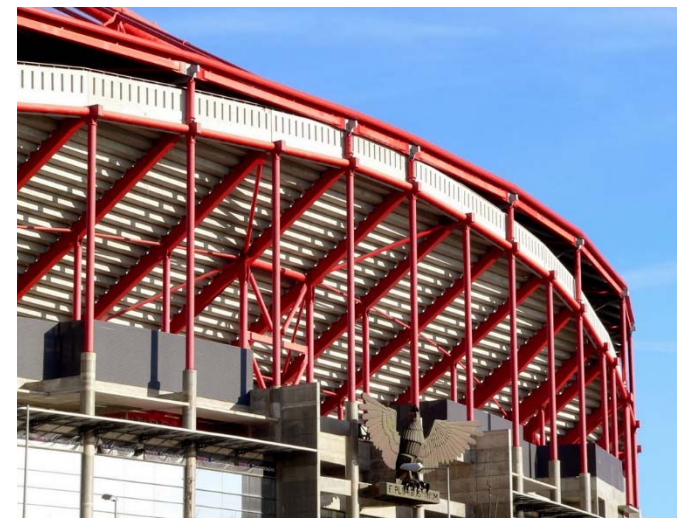
Fig. 45 Vista exterior de la repetición de los pilares
