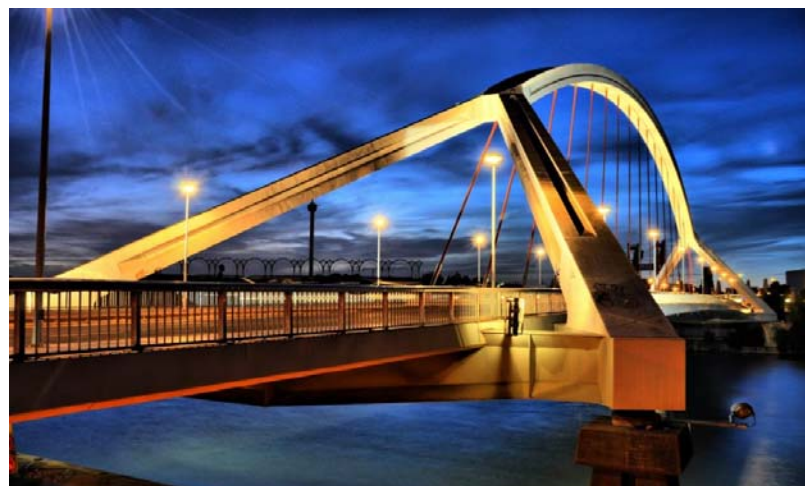
Fig. 24 Puente de la Barqueta
