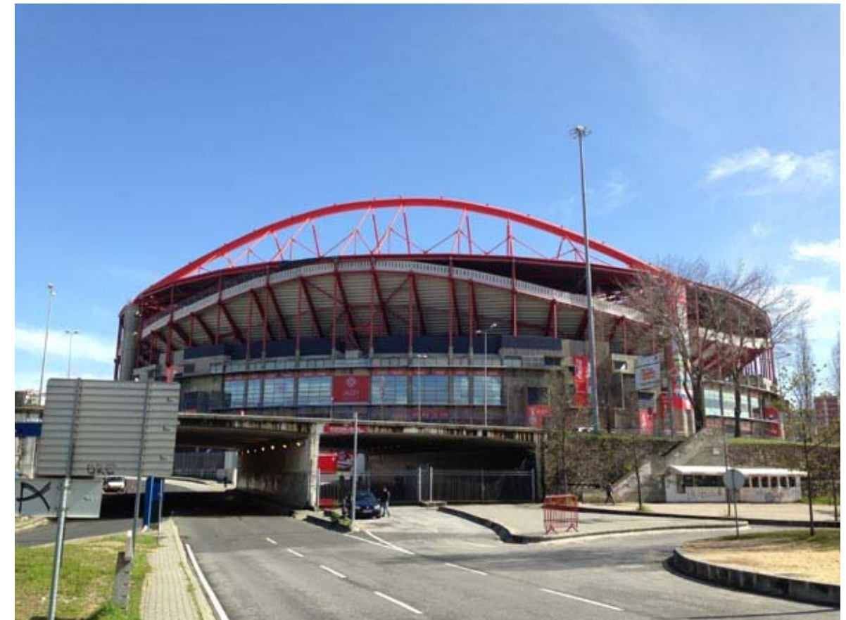
Fig. 50 Túnel de conexión entre centro comercial y estadio
