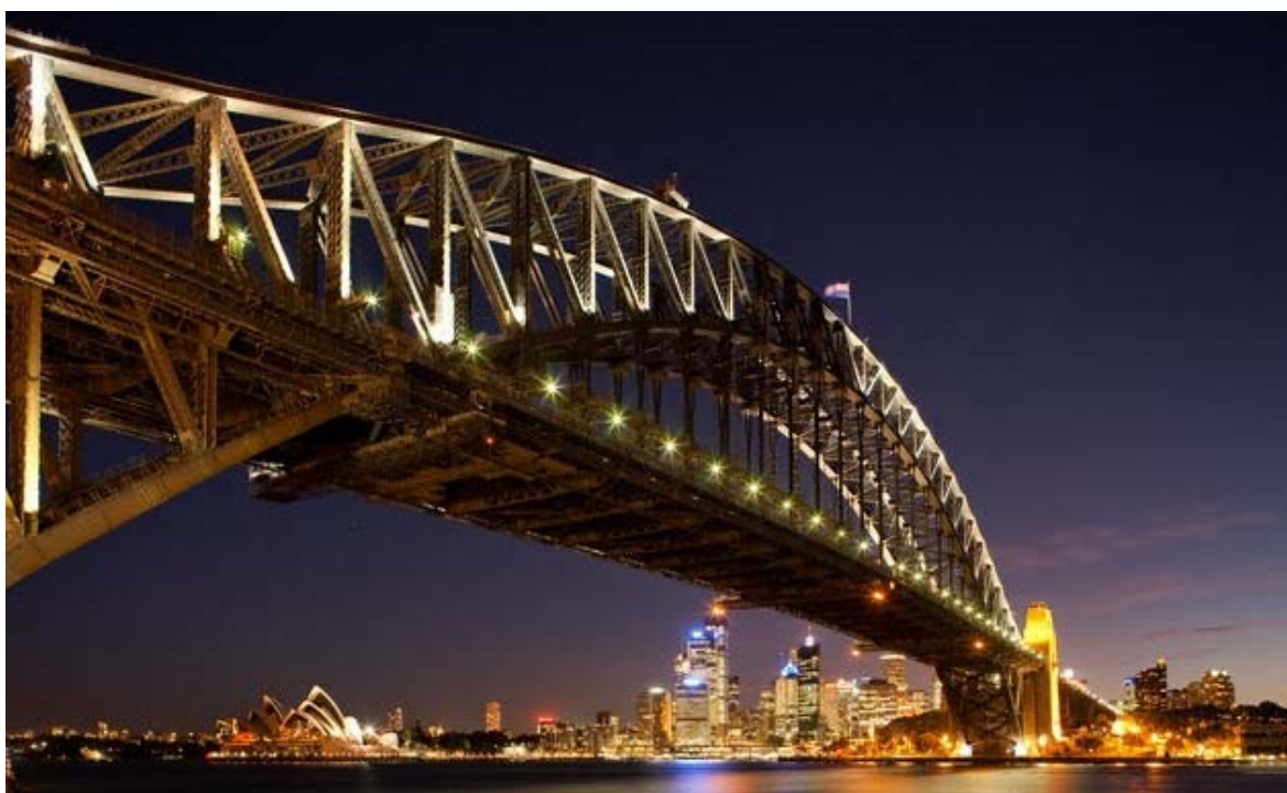
Fig. 22 Vista inferior Puente de la Bahía de Sidney
