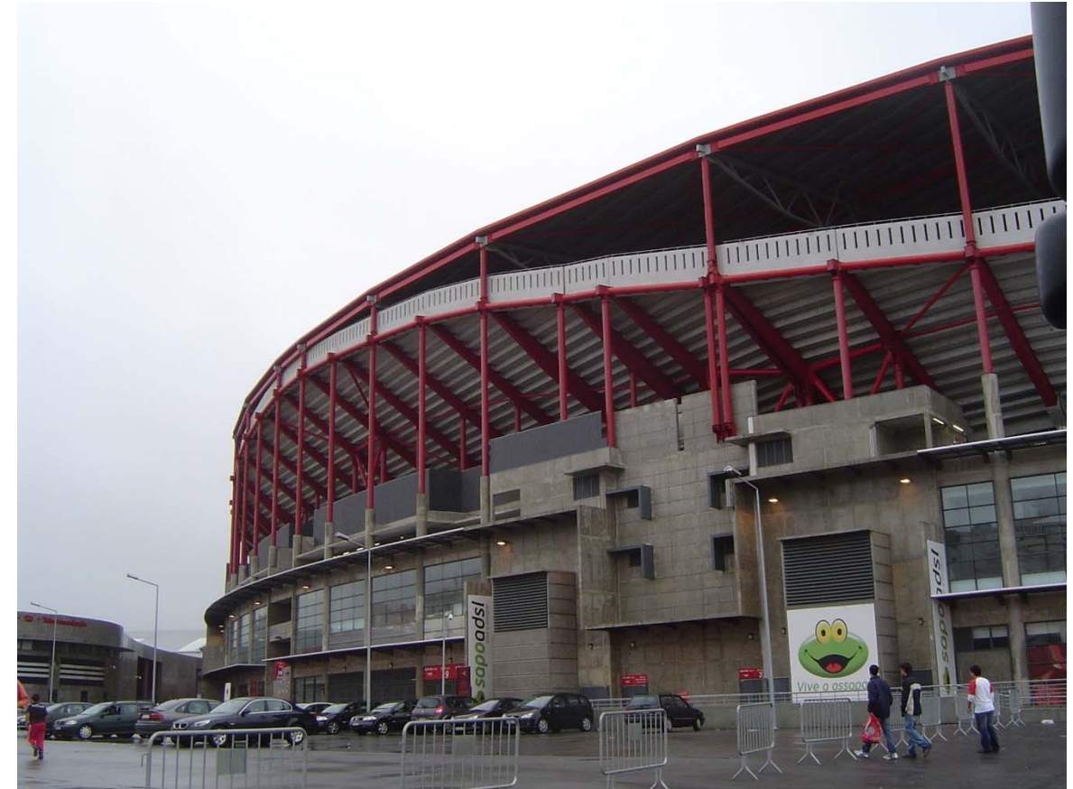
Fig. 47 Vista general de los pilares exteriores
