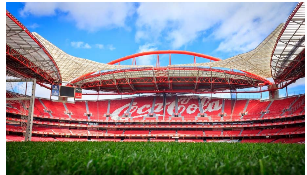
Fig. 37 Vista interior de la cubierta
