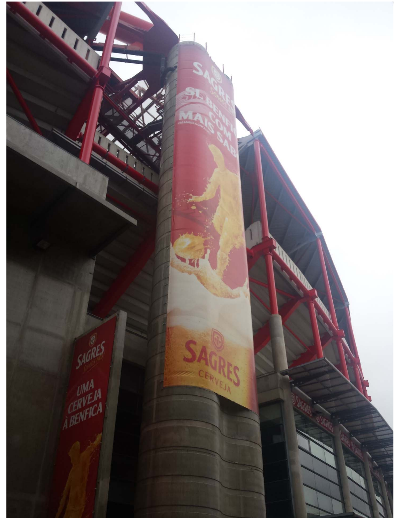
Fig. 65 Pilares donde apoyan los arcos
