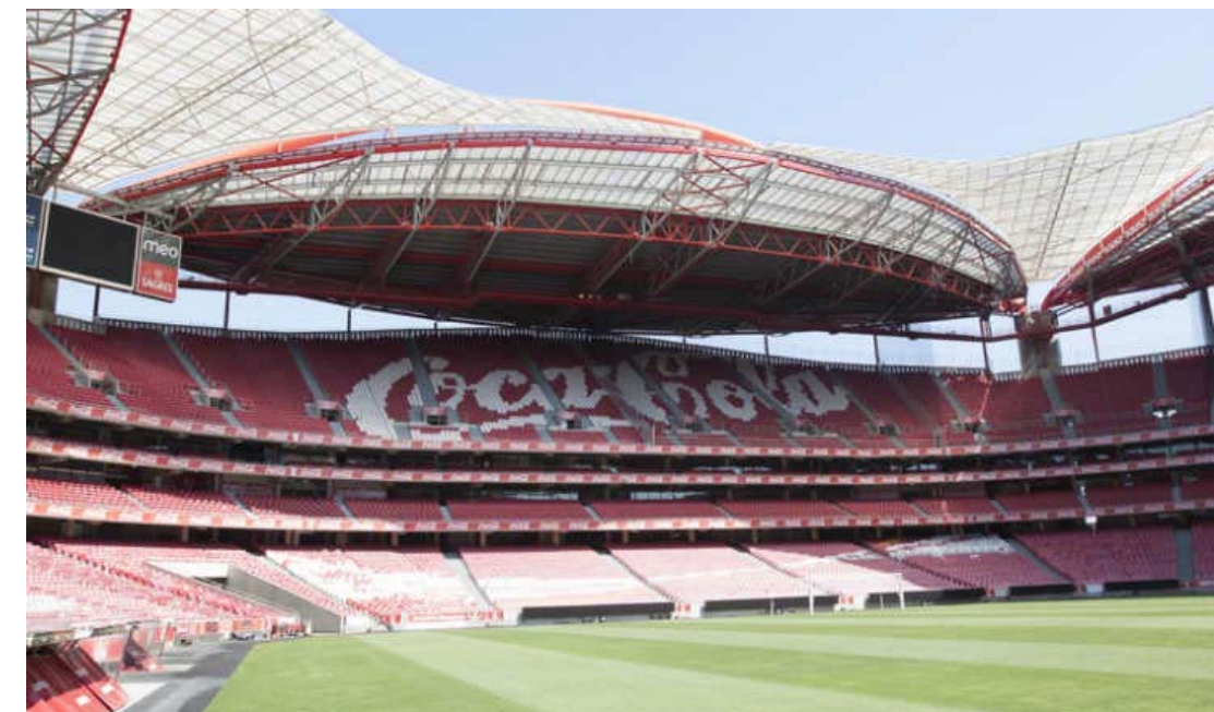
Fig. 60 Estructura inferior de la cubierta
