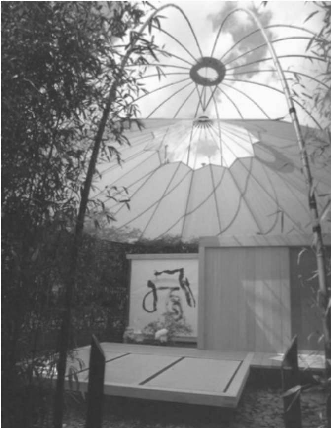
Figura 84. Vista de la estructura con el Tokonama en su interior.
