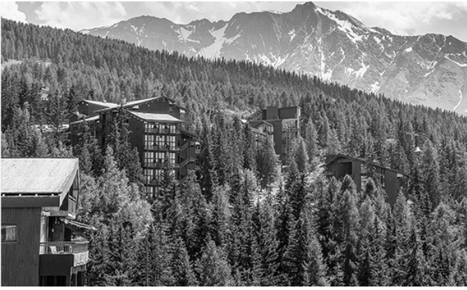
Figura 75. Vista exterior de Arc 1800 donde se pueden apreciar las barandillas metálicas.
