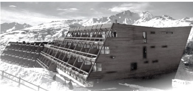
Figura 67. Fotografía actual de la residencia Trois Arcs .
