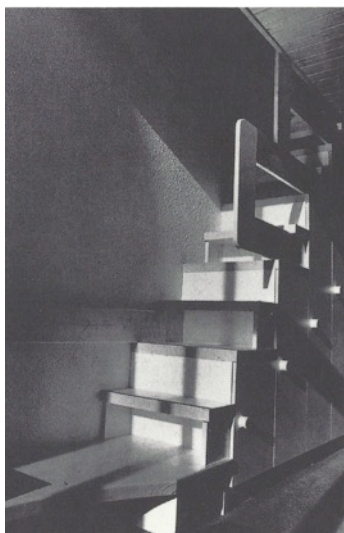
Figura 79. Escalera-almacenamiento en el interior de uno de los apartamentos de Les Mirantins .
