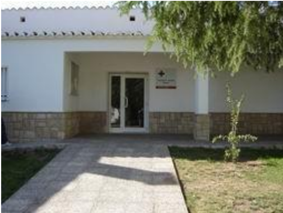
Ilustración 5: EXTERIOR DEL CONSULTORIO LOCAL DE MARINES
