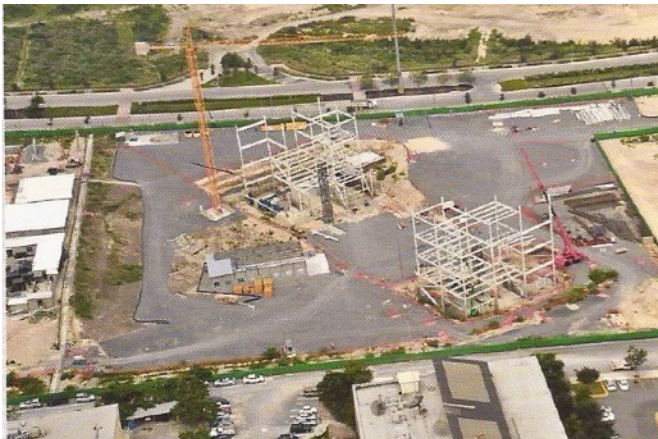
Montaje de la estructura de acero en los extremos del edificio. Desde la planta baja hasta la azotea y la posterior construcción del hormigón en los marcos hasta el nivel 02.
