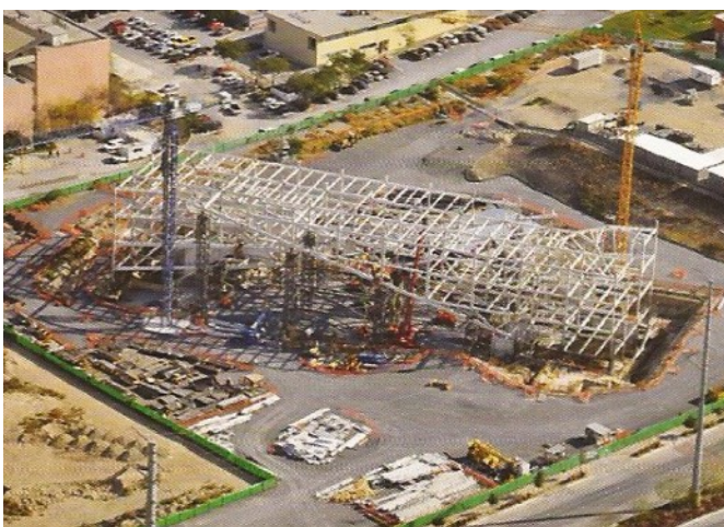
Se unen ambos extremos con la estructura de acero, con la ayuda de los apuntalamientos. Posteriormente se inicia la construcción del hormigón en los extremos
