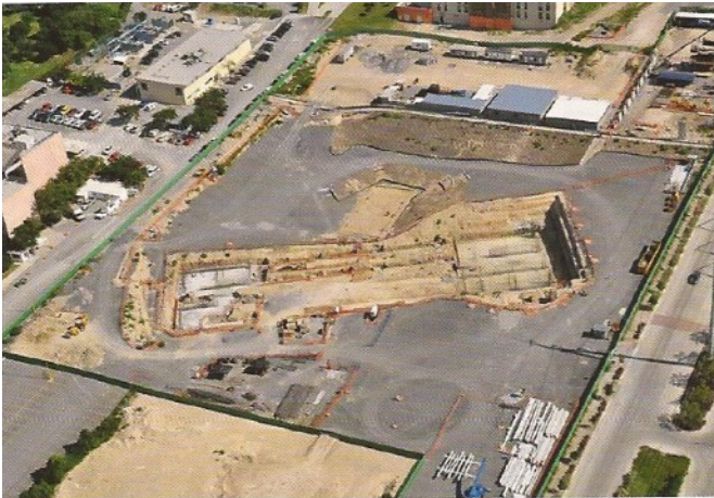
Movimientos de tierras y cimentación
