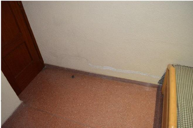
**Figura 12.- Solado de terrazo con rodapié y carpintería interior de madera aglomerada. 2018, fuente propia.**
