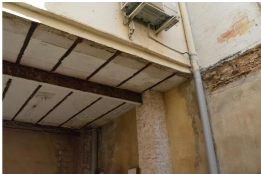
**Figura 3.- Viguetas a base de perfiles metálicos sobre vigas de madera y entrevigado de bardos cerámicos. 2018, fuente propia.**
