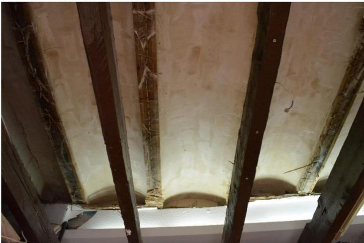
Figura 1.- Viguetas de madera y revoltón de ladrillo. 2018, fuente propia.
