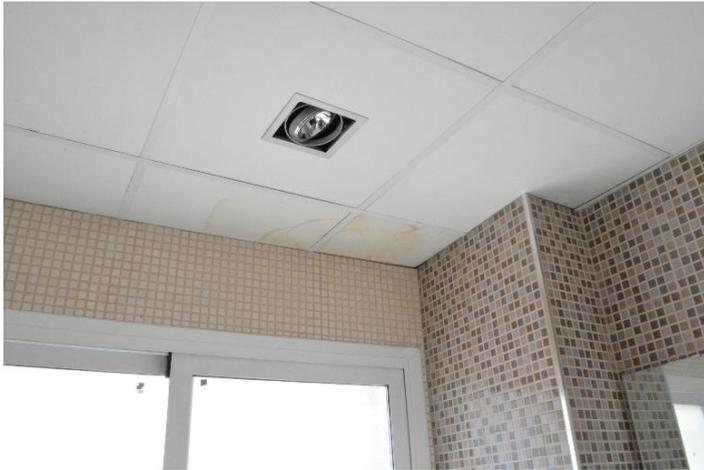
**Figura 13.- Falso techo en zona húmeda y alicatado. 2018, fuente propia.**
