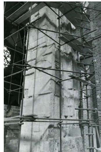
Imagen 2.4.31_Reparación pilar
