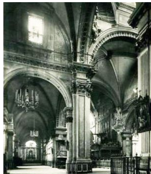
Imagen 2.4.26_Vista transepto hacia pies. Nave epístola
