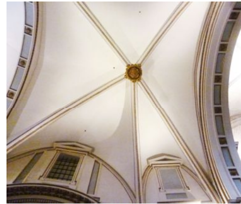
Imagen 2.4.17_Bóveda de crucería revestida
