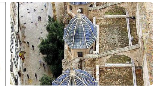
Imagen 1.2.3_Canalización aguas pluviales
