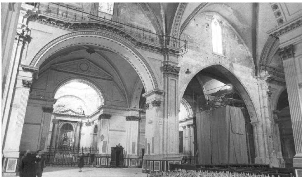
Imagen 3.2.2_Alzado nave central. En el tercer tramo sin los órganos se aprecia la estructura gótica. 1940
