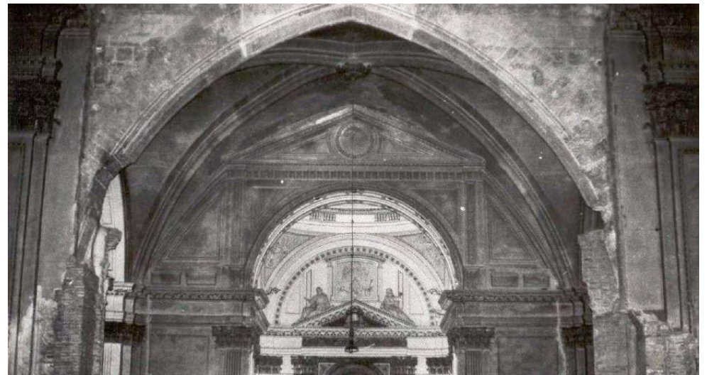
Imagen 3.2.21_Alzado capilla nave lateral antes repristinación
