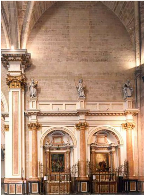
Imagen 3.2.16_Interior muro lateral nave central
