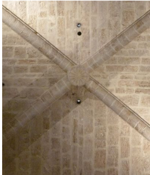
Imagen 3.2.8_Detalle bóveda y nervios desnudos
