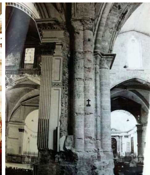
Imagen 3.2.6_Desmontaje revestimiento pilar nave central
