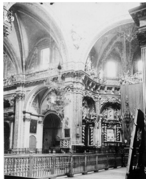
Imagen 2.4.28_Vista transepto y presbiterio. Se observa la cúpula barroca.
