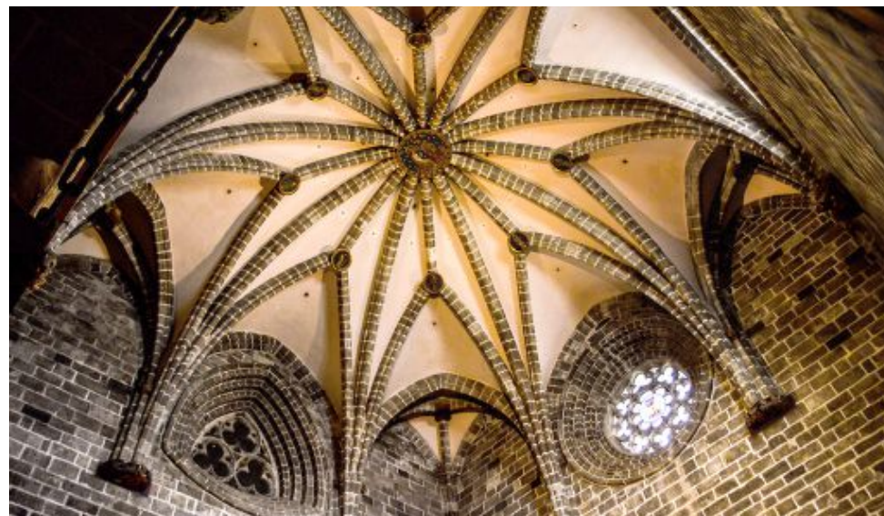
Imagen 1.2.14_Bóveda aula capítular
