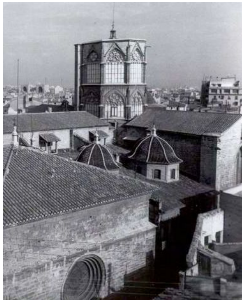
Imagen 2.4.10_Cubiertas nave lateral y central. Estado s. XVIII
