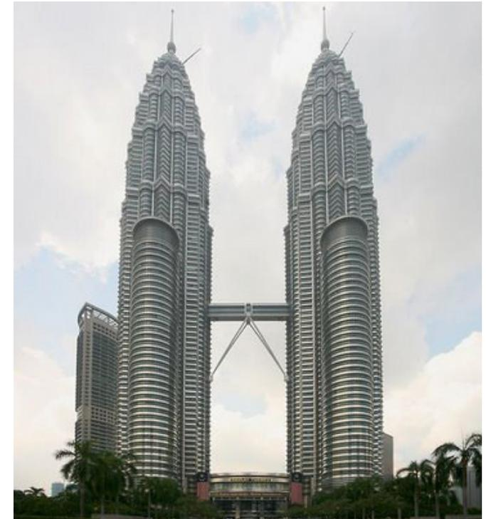
FIGURA 24. El proyecto para las Torres Petronas en Kuala Lumpur (Indonesia), uno de los edificios más altos del mundo. La tecnología antisísmica principal que utilizan se denomina "Mat Slab", que consiste en un inmenso sótano altamente reforzado que funciona como un gran basamento que sustituye las características mecánicas del subsuelo, y que al mismo tiempo provoca que el momento estabilizador del conjunto sea muy superior al momento de volteo que puede experimentar el mismo.
