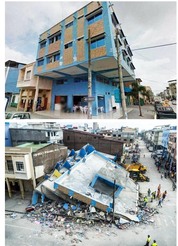
FIGURA 22. Edificio colapsado debido al cambio de rigidez y masa entre pisos consecutivos
