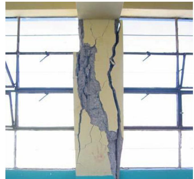
FIGURA 28. Falla típica columna corta
