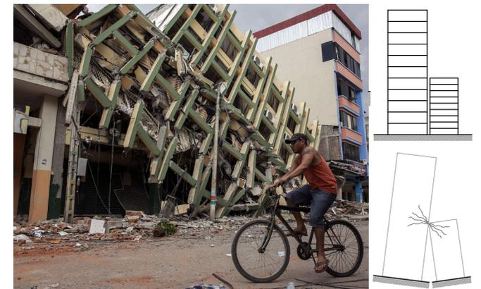
FIGURA 29. Riesgo de colisión de estructura al efecto de golpeteo entre estructuras adyacentes, ejemplo en una fotografía en Portoviejo Ecuador
