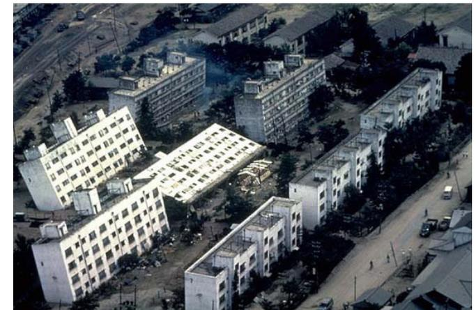
FIGURA 19. Edificios colapsados en respuesta al movimiento sísmico en donde su planta longitudinal influye
