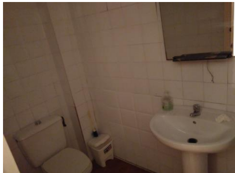
Figura 46. Revestimiento baños mujeres planta baja. 2018. Fuente: Propia.
