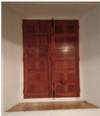
Figura 54. Carpintería cerrada desde interior. 2018. Fuente: Propia.
