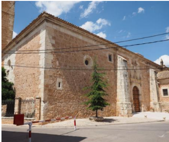
Figura 8. Puerta principal Iglesia San Andrés Apóstol. 2018. Fuente: Propia.
