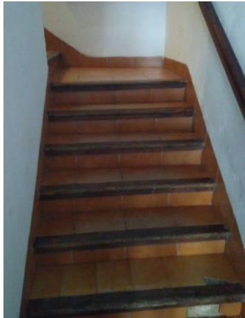
Figura 36. Primer tramo escalera. 2018. Fuente: Propia.
