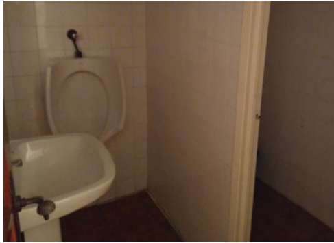
Figura 47. Revestimiento baños hombres planta baja. 2018. Fuente: Propia.
