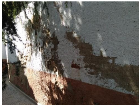
Figura 60. Pared patio. 2018. Fuente: Propia.
