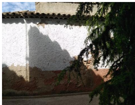
Figura 61. Pared patio. 2018. Fuente: Propia.
