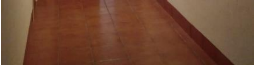
Figura 35. Suelo del edificio. 2018. Fuente: Propia.
