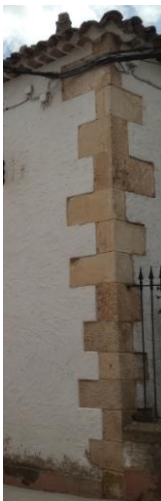
Figura 24. Esquina derecha fachada. 2018. Fuente: Propia
