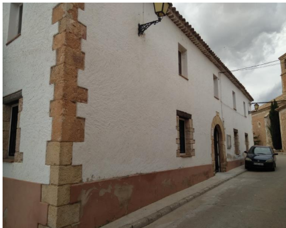
Figura 41. Fachada principal. 2018. Fuente: Propia.
