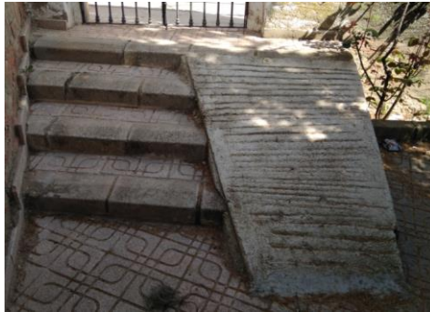
Figura 39. Escalones y rampa entrada al patio. 2018. Fuente: Propia.
