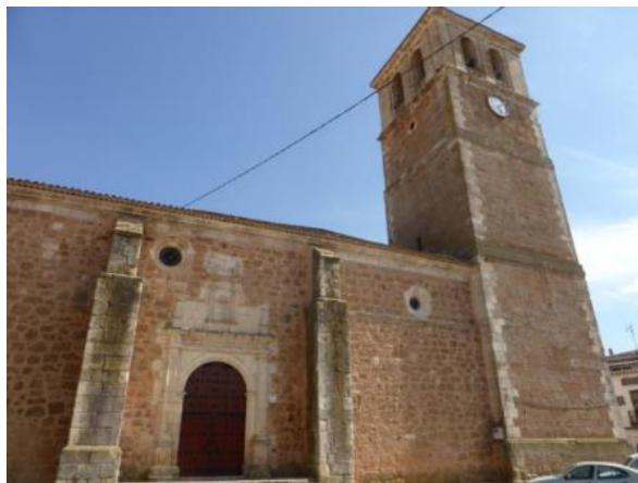
Figura 9. Puerta fachada posterior Iglesia San Andrés Apóstol. 2018. Fuente: Propia.
