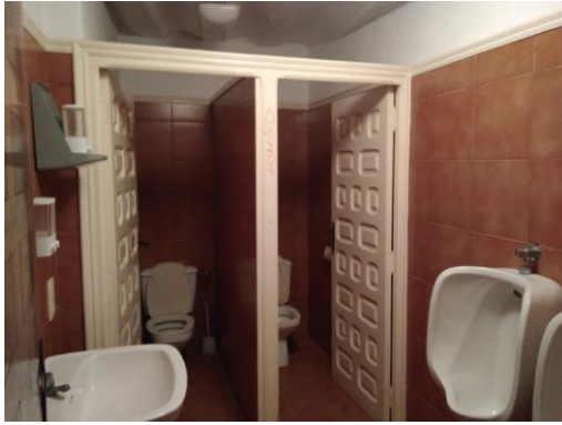
Figura 48. Revestimiento baños hombres planta primera. 2018. Fuente: Propia.
