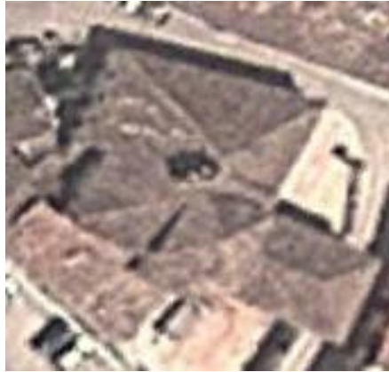
Figura 33. Cubierta edificio. 2018. Fuente: Google Earth Pro.
