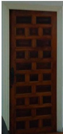
Figura 56. Puerta de una hoja. 2018. Fuente: Propia
