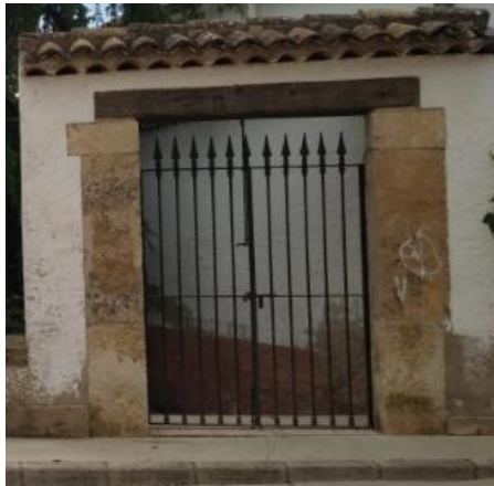
Figura 51. Puerta de entrada al patio desde exterior. 2018. Fuente: Propia.
