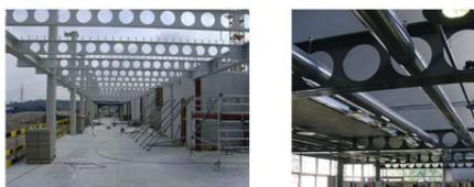
3. Forjados: los forjados se realizarán mediante losas de hormigón armado in-situ conectándose con la estructura mediante conectores metálicos soldados a las vigas, de esta forma la viga y la losa trabajan de forma conjunta, creándose una viga en T que proporciona una mayor inercia al sistema.
