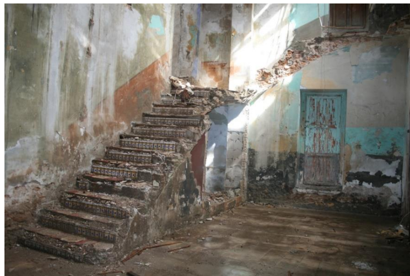
Fig. 40. Escalera de la zona del vestíbulo | Ayuntamiento de Carlet. 2011
