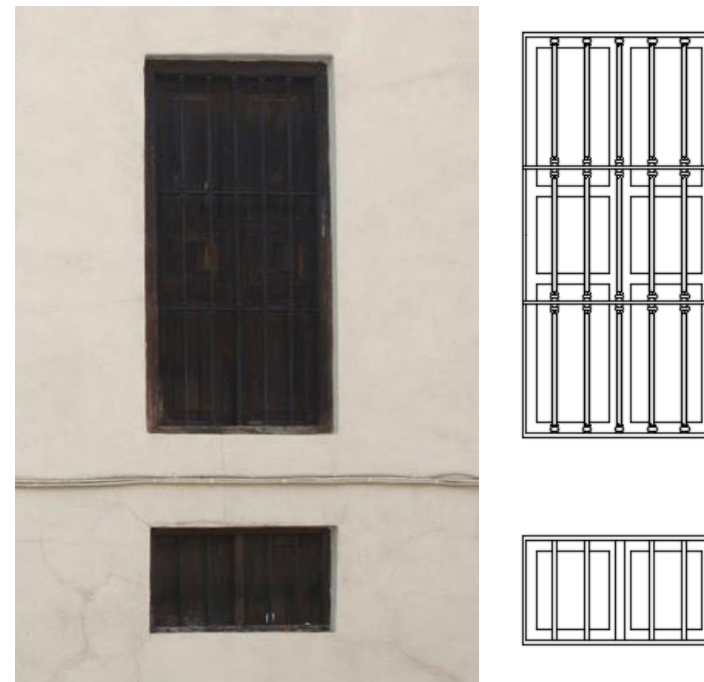
Fig. 45. Fotografía y detalles de las carpinterías y rejería | Imagen propia. 2018
