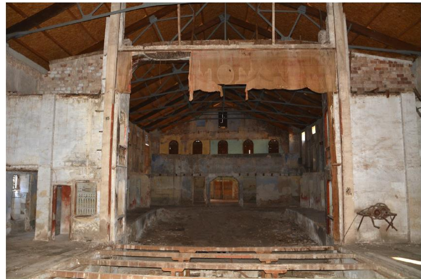
Fig. 19. Interior del teatro tras la reforma | Ayuntamiento de Carlet. 2012
