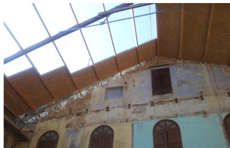
Fig. 31. Reparación de la cubierta | Ayuntamiento de Carlet. 2012
