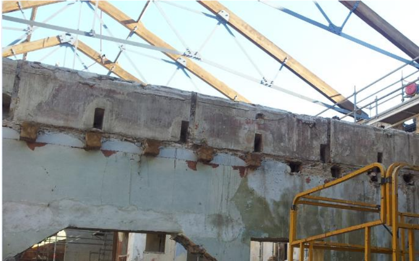
Fig. 33. Antigua localización de los forjados de revoltón | Ayuntamiento de Carlet. 2012
