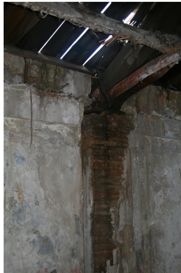
Fig. 25. Pilar de ladrillo | Ayuntamiento de Carlet. 2011
