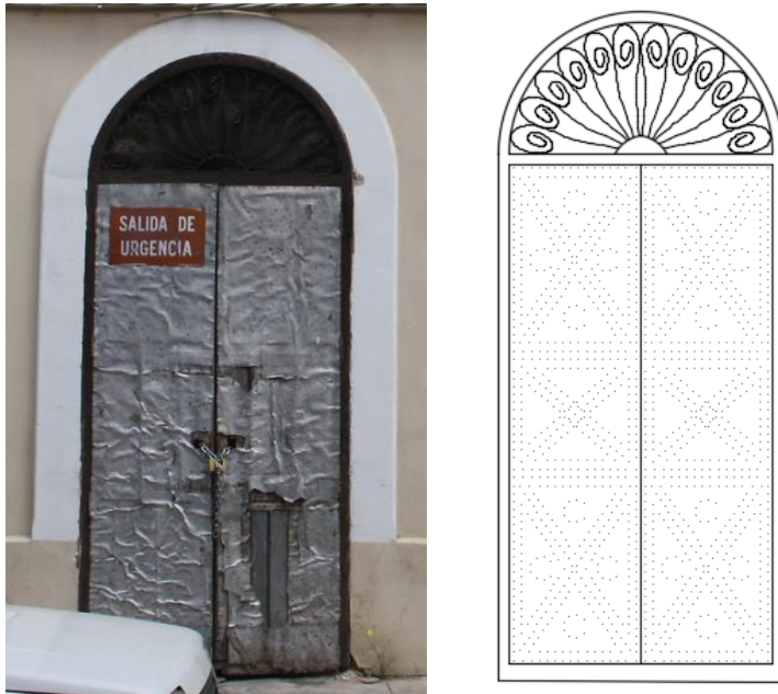
Fig. 46. Fotografía y detalle de las carpinterías y rejería | Imagen propia. 2018
