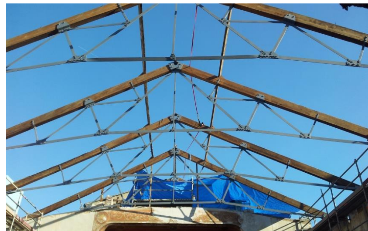
Fig. 30. Reparación de la cubierta | Ayuntamiento de Carlet. 2012
