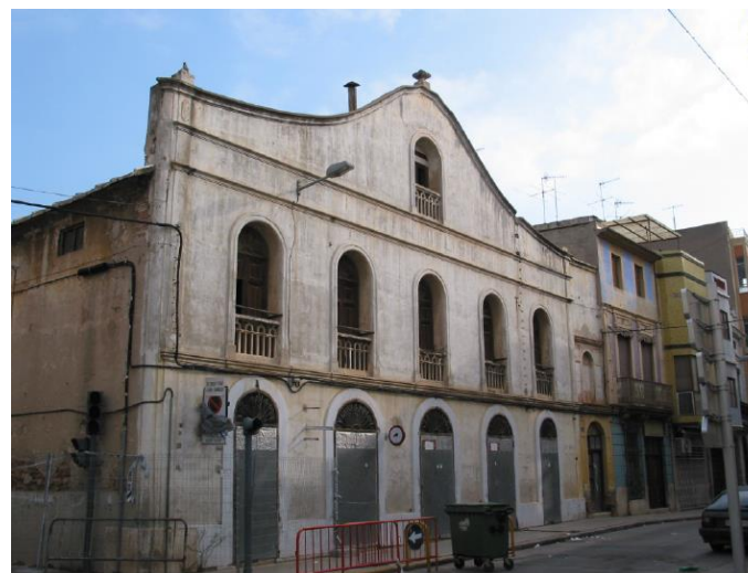
Fig. 16. Exterior del teatro antes de la rehabilitación de 2012 | Ayuntamiento de Carlet. 2011
