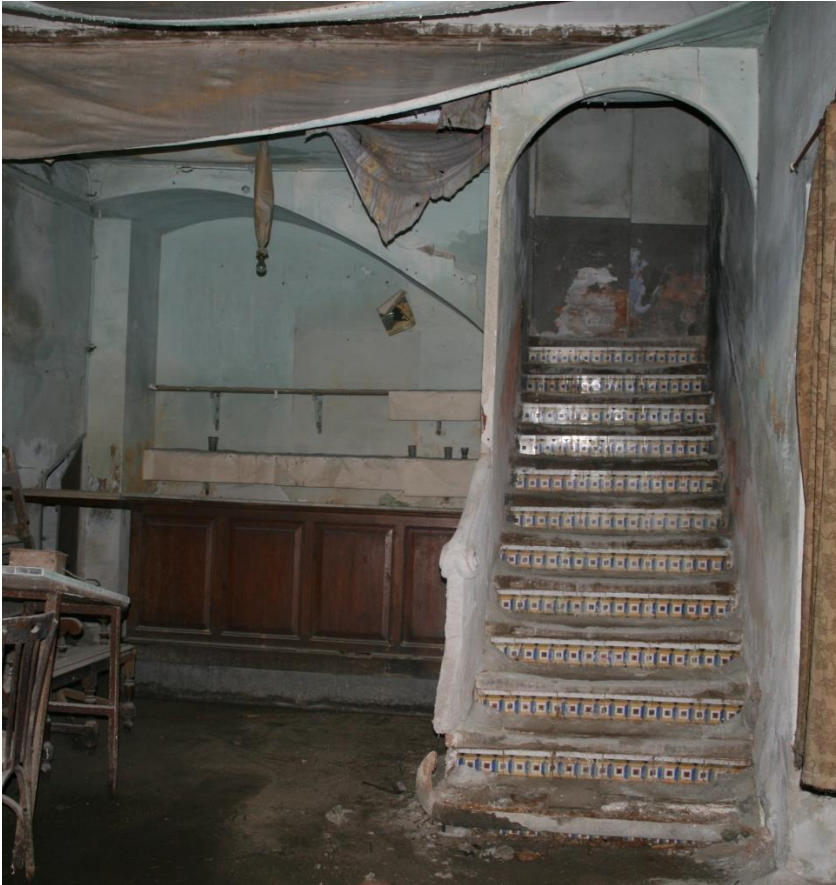
Fig. 41. Escalera de la zona del vestíbulo | Ayuntamiento de Carlet. 2011
