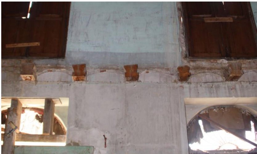
Fig. 34. Antigua localización de los forjados de revoltón | Imagen propia. 2018
