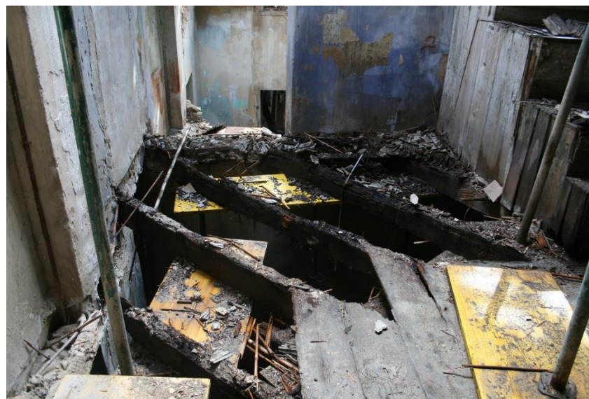
Fig. 36. Forjado de madera | Ayuntamiento de Carlet. 2011
