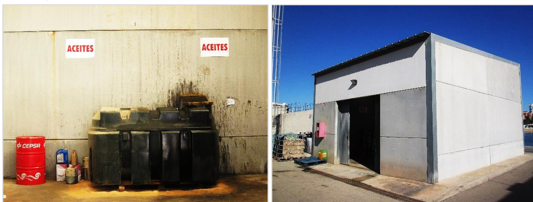
Fotografía 2. Área de depósito de residuos peligrosos para los usuarios del puerto de pescadores
