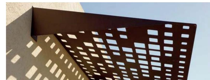
Además, debido a que hay gran cantidad de zonas acristaladas se colocan brise-soleil superiores para que protejan de esa radiación solar directa a los espacios interiores. Estos se consiguen, o bien gracias a los voladizos de los forjados superiores que acaban en losa maciza o con unos *brise-soleil de chapa de acero corten* similares a los de la imagen mostrada superiormente.
