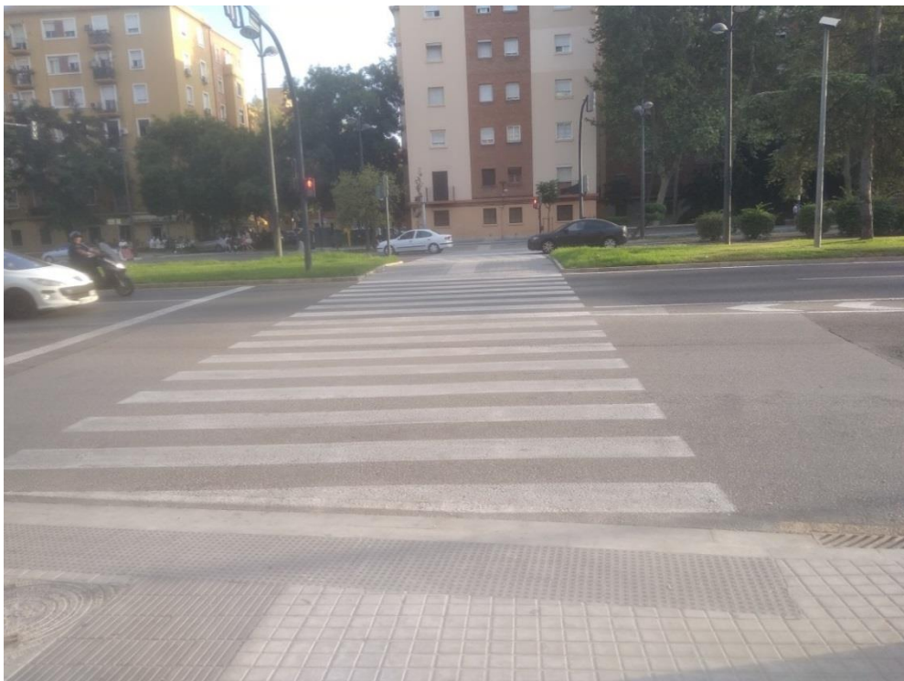
Imagen 13: Nuevo paso de peatones en Av. del Cid, 106
