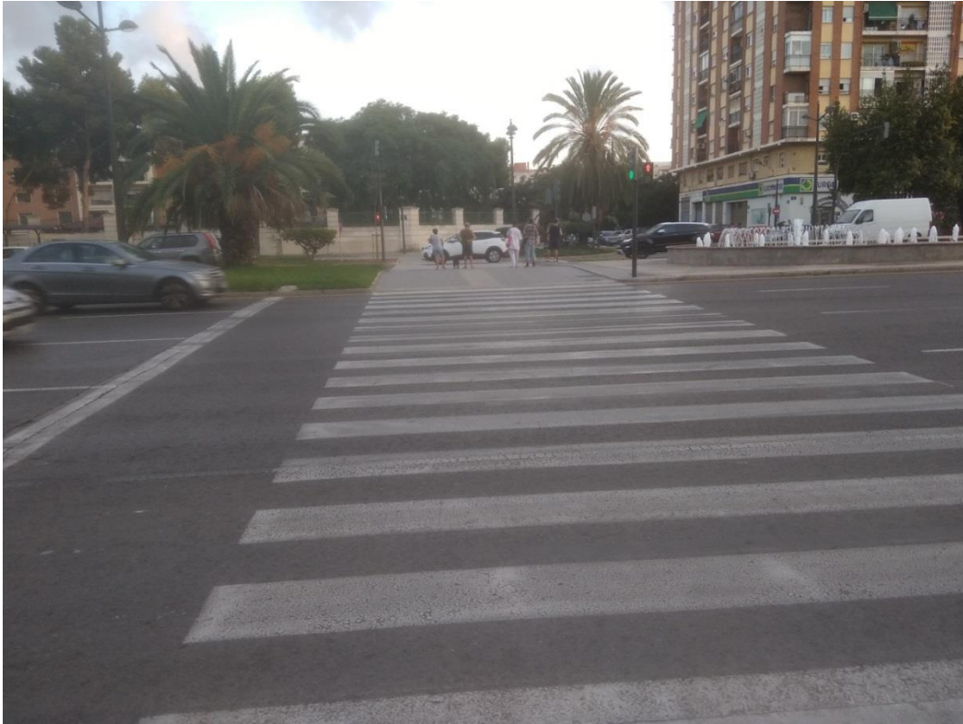
Imagen 12: Nuevo paso de peatones en Av. del Cid, 146
