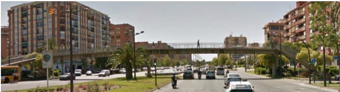
Imagen 6: Imagen de la pasarela nº4
