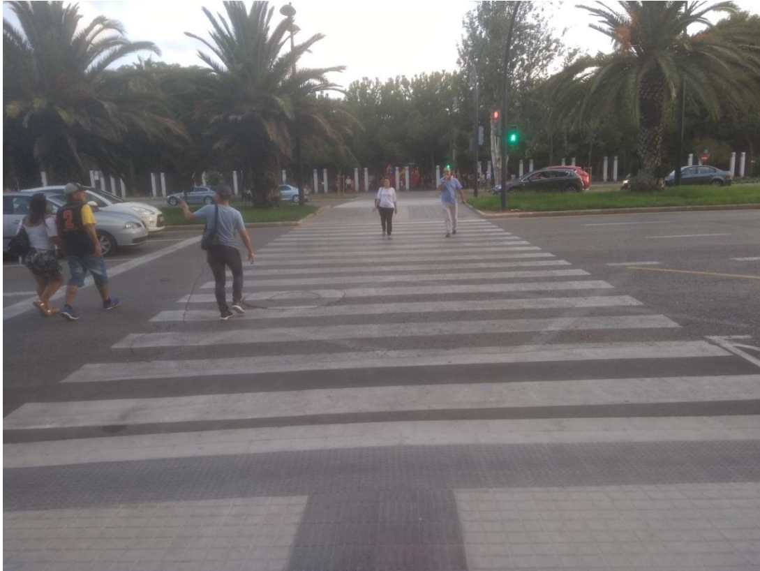
Imagen 14: Nuevo paso de peatones en Av. del Cid, 50
