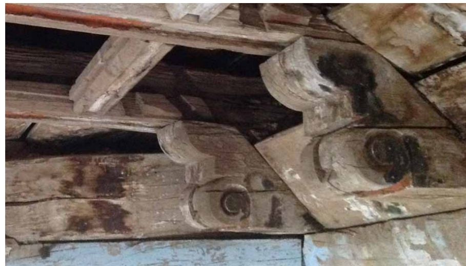
Figura 6:43. Vista de las ménsulas lobuladas del entablado. Su función es decorativa y no estructural. (Foto: A. Pizarro, 2015).
