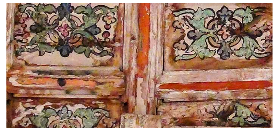
Figura 6:76. Detalle del alfarje. Es posible ver la línea roja sobre el hendidura de los pinazos y las viguetas, así como el ornamento decorativo de las tabletas centrales. (Foto: Isaac Rangel, 2016).
