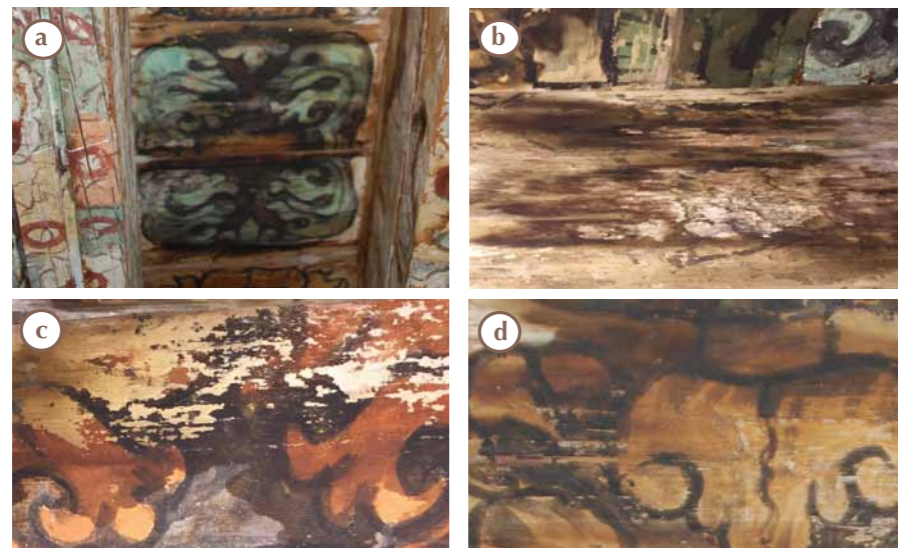
Figura 6:103. Detalles de la policromía del forjado policromado del baptisterio. Se observan las manchas de humedad en las tabletas (a) (d), vigas (b) y lagunas de la capa pictórica (c). (Fotos: K. Muñoz Alcocer & A. Pizarro, 2015).
