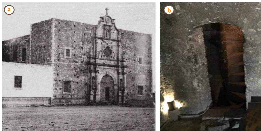
Figura 4:32. Fotografía estereoscópica del antiguo colegio jesuita de Nuestra Señora de Loreto. Es reconocido como el primer centro educativo en la ciudad de Chihuahua (a). Escaleras del cuerpo de la torre norte, siendo el único elemento arquitectónico que sobrevivió de la destrucción del colegio a mediados del S.XIX (b). (Imagen: Lazcano Sahagun, C. & Vázquez Loya, D., 2013:155 (a); Foto: K. Muñoz Alcocer, 2017)
