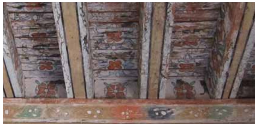
Figura 6:72. Detalle de la techumbre de viguería de la sacristía. Es posible observar la policromía presente en las latillas, vigas, muro y cornisa de la viga de arrastre con la técnica de marmoleado. (Foto: K. Muñoz Alcocer, 2016).
