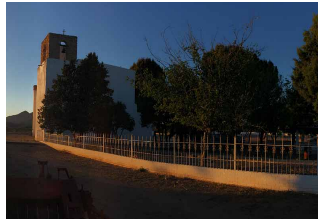
Figura 6:13. Vista de la antigua Misión de Santa Ana de la Joya. (Foto: K. Muñoz Alcocer, 2011).
