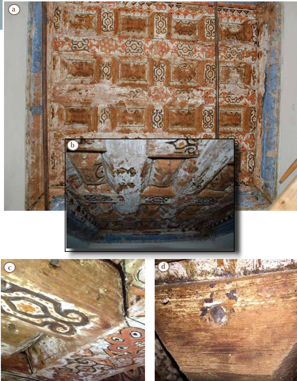
Figura 6:47. Vista frontal del alfarje del baptisterio (a) y vista con luz rasante, la cual permite ver el almohadillado logrado por cuarterones piramidales (b); detalle de la unión de los cuarterones a las vigas sobre ángulos oblicuos (c); detalle de un clavo forjado utilizados para sujetar los cuarterones piramidal y tronco-piramidales a una tabla que corre de manera paralela a las vigas (d). (Fotos: K. Muñoz Alcocer (a),(c) y (d); J. R. Ruiz Checa, 2015 (b).
