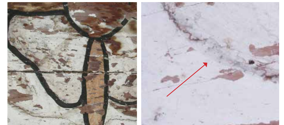
Figura 6:74. Detalles de la flor que decora el sotocoro. Nótese los puntos negros en secuencia, pudiéndose tratar de la aplicación de patrón para realizar el dibujo. (Fotos: K. Muñoz Alcocer 2002).
