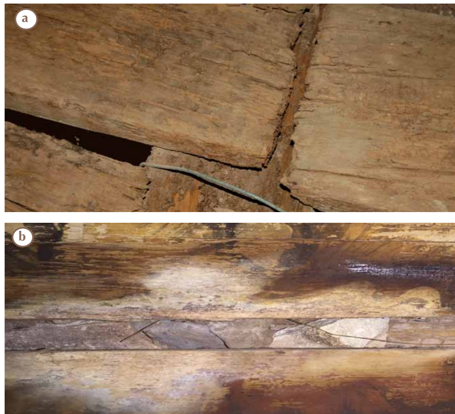
Figura 6:101. Detalle del estado de degradación de las tabletas del coro antes de su restauración en el 2005 a); Piedras y tierra del entrepiso se observan entre la separación de dos tabletas del forjado del baptisterio b). (Fotos: Mark Minnor, 2005 (a); K. Muñoz Alcocer, 2015 (b)).
