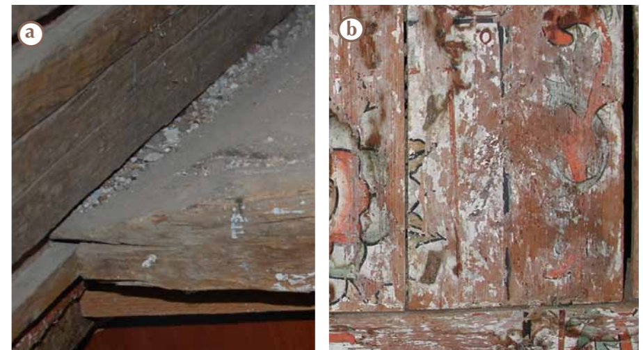
Figura 6:37. Detalle de una tableta del coro. Tableta vista del reverso, se observa el sistema de unión lengüeta y ranura (a); vista del anverso. a unión entre las tabletas queda a la vista, no habiendo presencia de listones o largueros como en la nave (b). (Fotos: J.R. Ruiz Checa, 2015).
