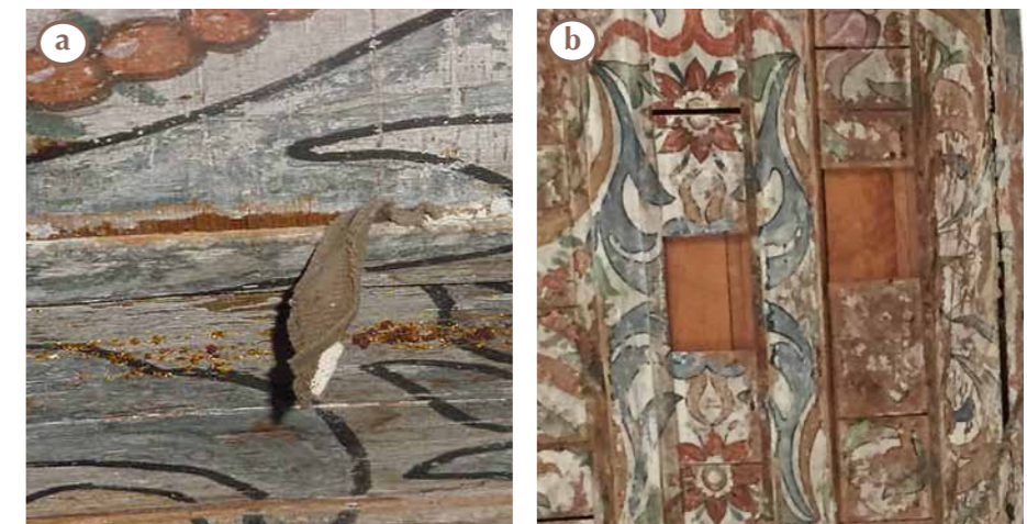
Figura 6:35. Detalles del entablado: Detalle de tela encontrada en el hueco de la unión entre una tableta y la viga 19 (a); vista de los tablones colocados sobre las vigas del presbiterio desde el exterior (b). (Fotos: K. Muñoz Alcocer, 2003).
