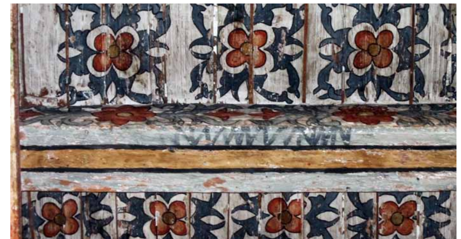
Figura 6:73. Forjado del baptisterio. Detalle que muestra la disposición del módulo decorativo de las latillas. Nótese la variedad de distancias que hay entre una hilera y otra, así como las marcas de azul en la viga. (Foto: K. Muñoz Alcocer, 2002)
