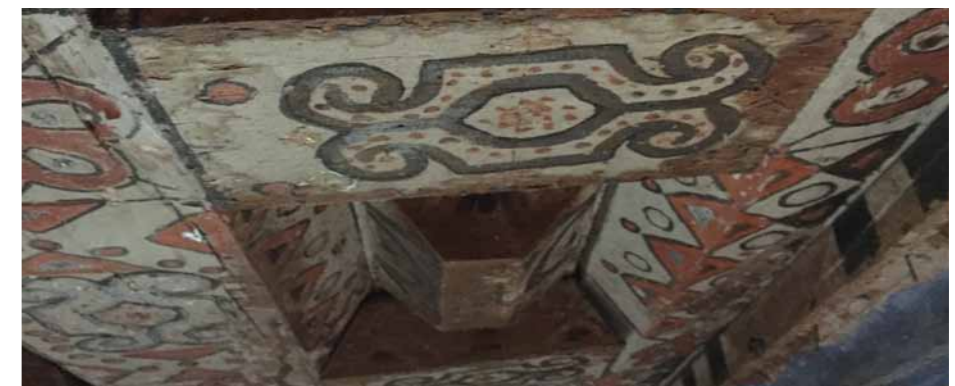
Figura 6:46. Vista rasante del alfarje. Se observan los cuarterones que forma las vigas simuladas y los cuarterones tronco piramidales. (Foto: K. Muñoz Alcocer, 2015).
