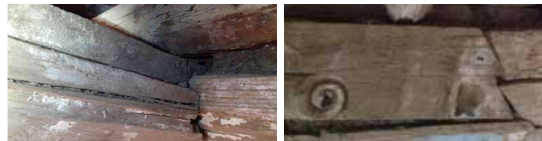
Figura 6:42. Vista general del alfarje (a); vista rasante del alfarje mostrando la estructura realizada por viguetas y peinazos que forman casetones (b); vista general y detalle del sistema de unión de los peinazos a medio leño. Nótese la unión de las ménsulas, las cuales no tienen función estructural(c); detalle del anclaje de la vigueta a la viga de arrastre (d). (Fotos: A. Pizarro, 2015).
