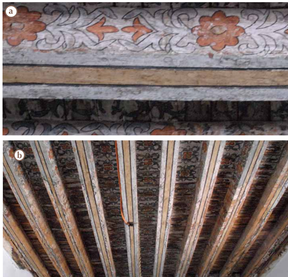
Figura 6:36. Forjado del baptisterio. Detalle (a) y vista general de la techumbre. (Fotos: K. Muñoz Alcocer, 2017).
