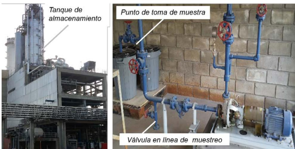
Figura 52. Fotografías del desorber y punto de toma de muestras en la planta piloto.
