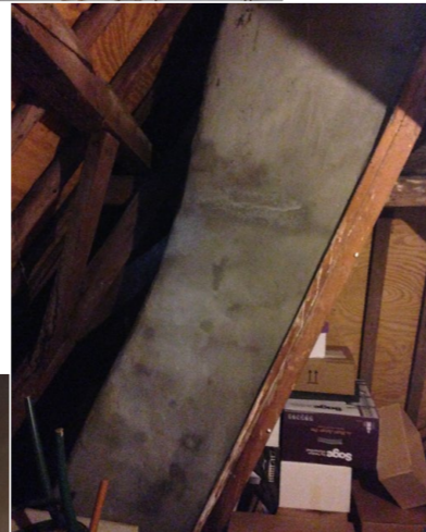
13. Chimenea a través
