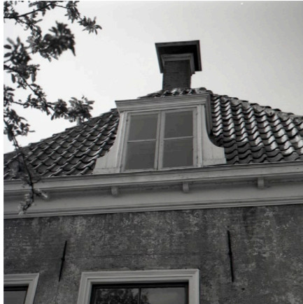
20. Ventana en planta primera
