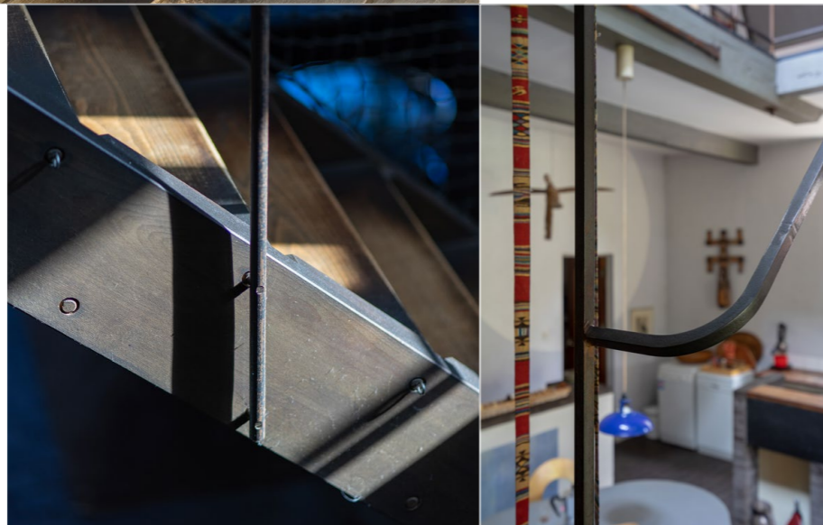
14. Barandilla, detalle anclaje escalera
