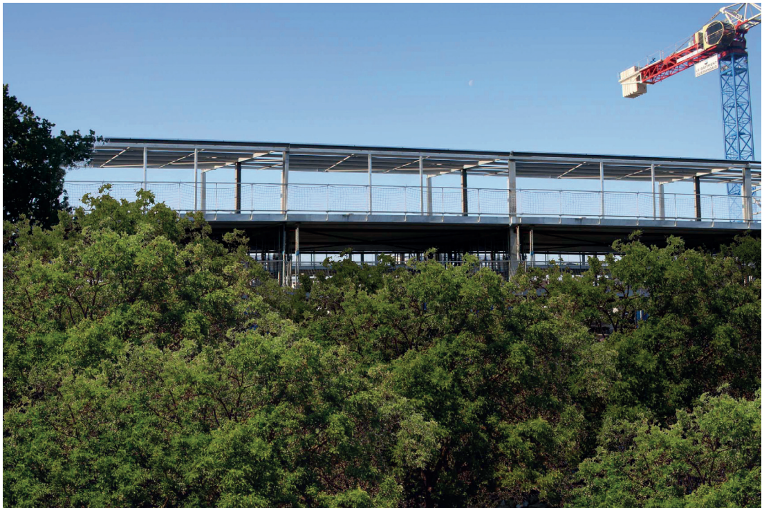
Figure 8. Procédé constructif mis en œuvre au même moment pour l'opération Innova, située à Saint-Nazaire à quelques centaines de mètres à vol d'oiseau de la Vecquerie, pour le même maître d'ouvrage, Silène.
