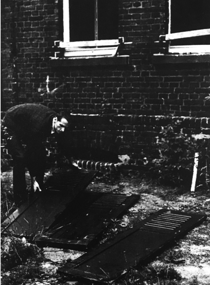
Hermann Pitz. Desmontaje de contraventanas y puertas en la propiedad de Essen, Alemania, 1987. ↑ Fig. 078.
