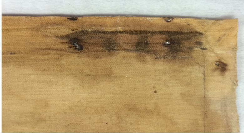
Fig. 7. Ejemplo de oxidación y tinción del soporte textil provocado por la herrumbre de los clavos de tensión. (Soporte textil algodón siglo XIX)
