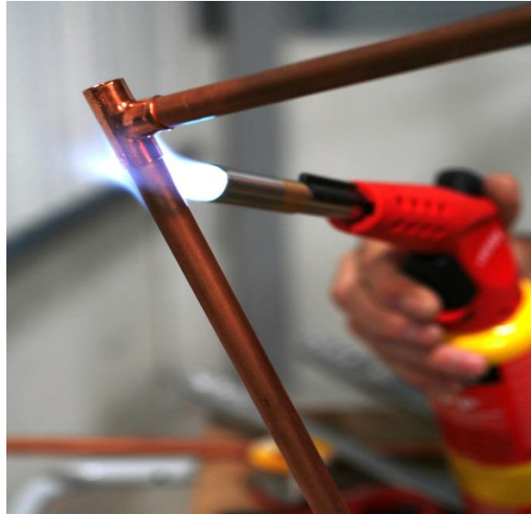
Figura 19. Soldadura por soplete.
