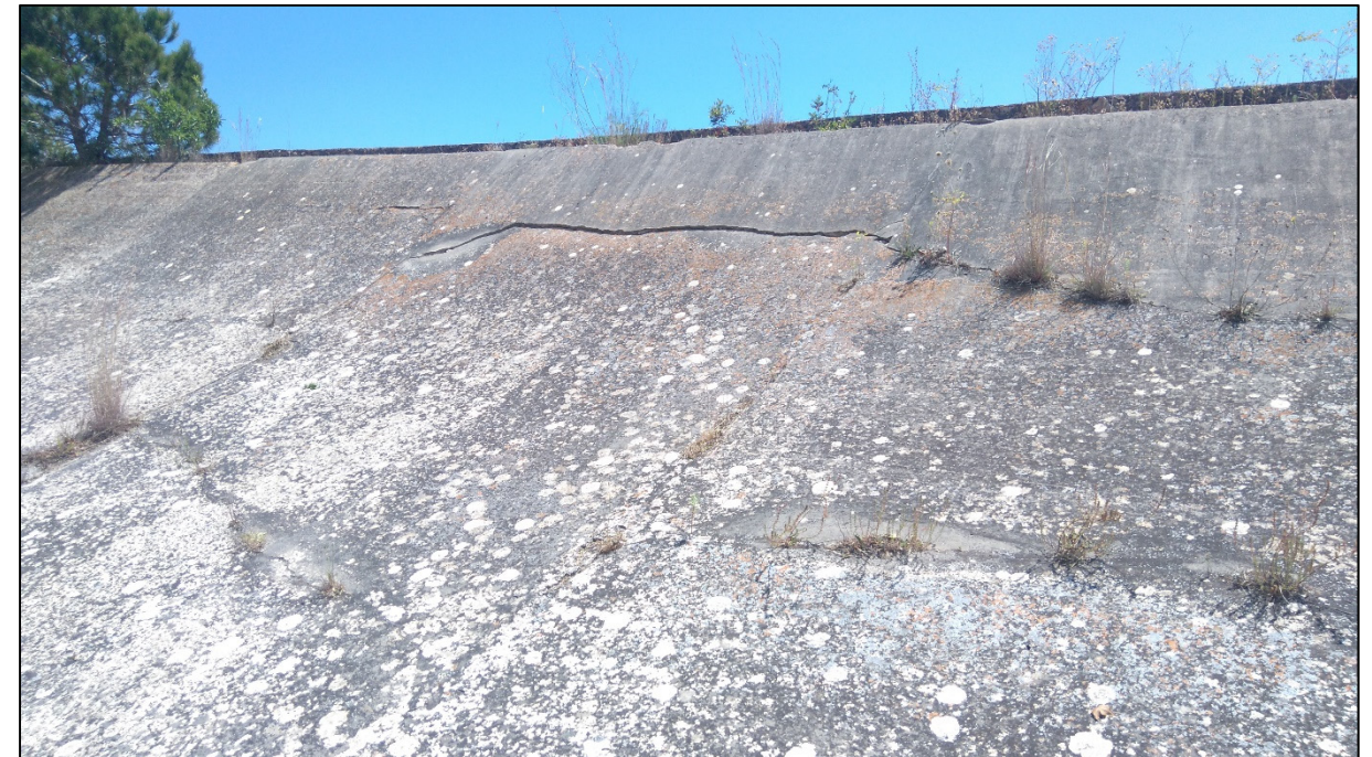
5- Hundimientos de losa de hormigón por pérdida de material de apoyo.
