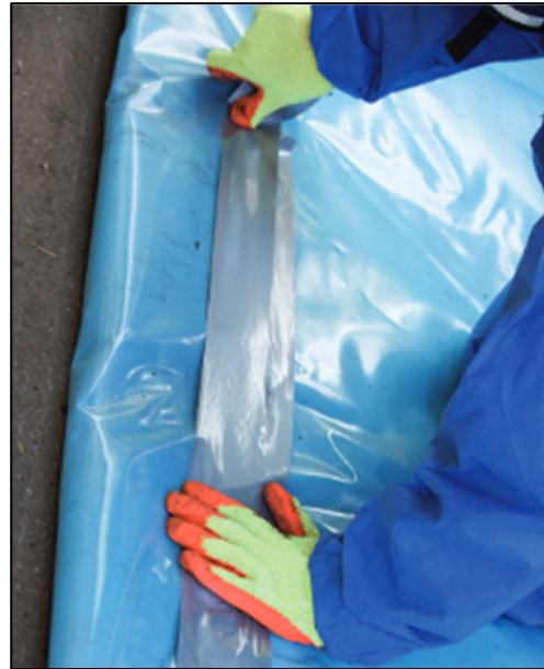
Ilustración 21 - Empaquetado residuos materiales con amianto.
