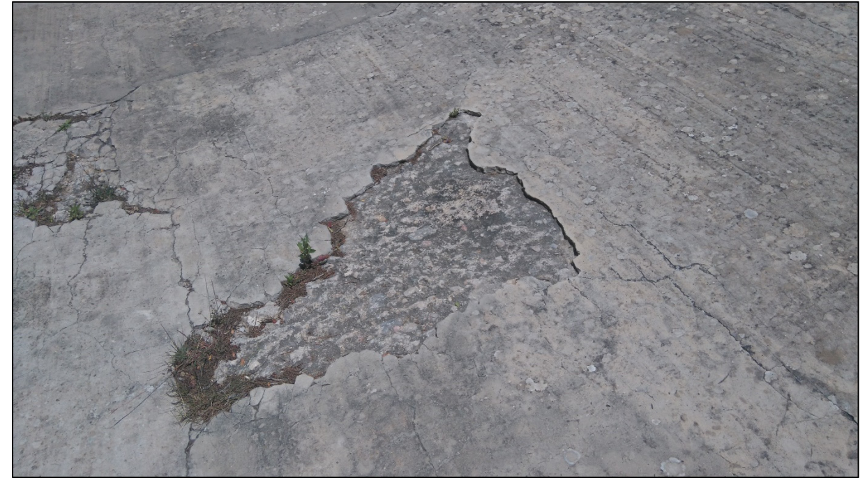
5- Hundimientos de losa de hormigón por pérdida de material de apoyo.
