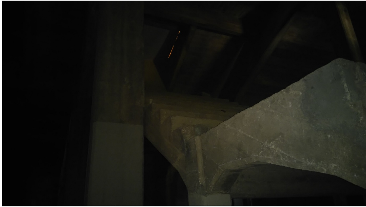
Ilustración 16 - Escalera que daba acceso a la zona de gradas.
