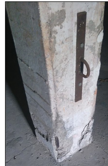
Ilustración 15 - Pilares con las armaduras al aire.
