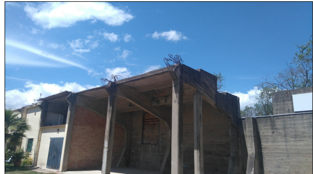
Ilustración 11 - Esqueleto de la grada bajo la que se ha edificado.
