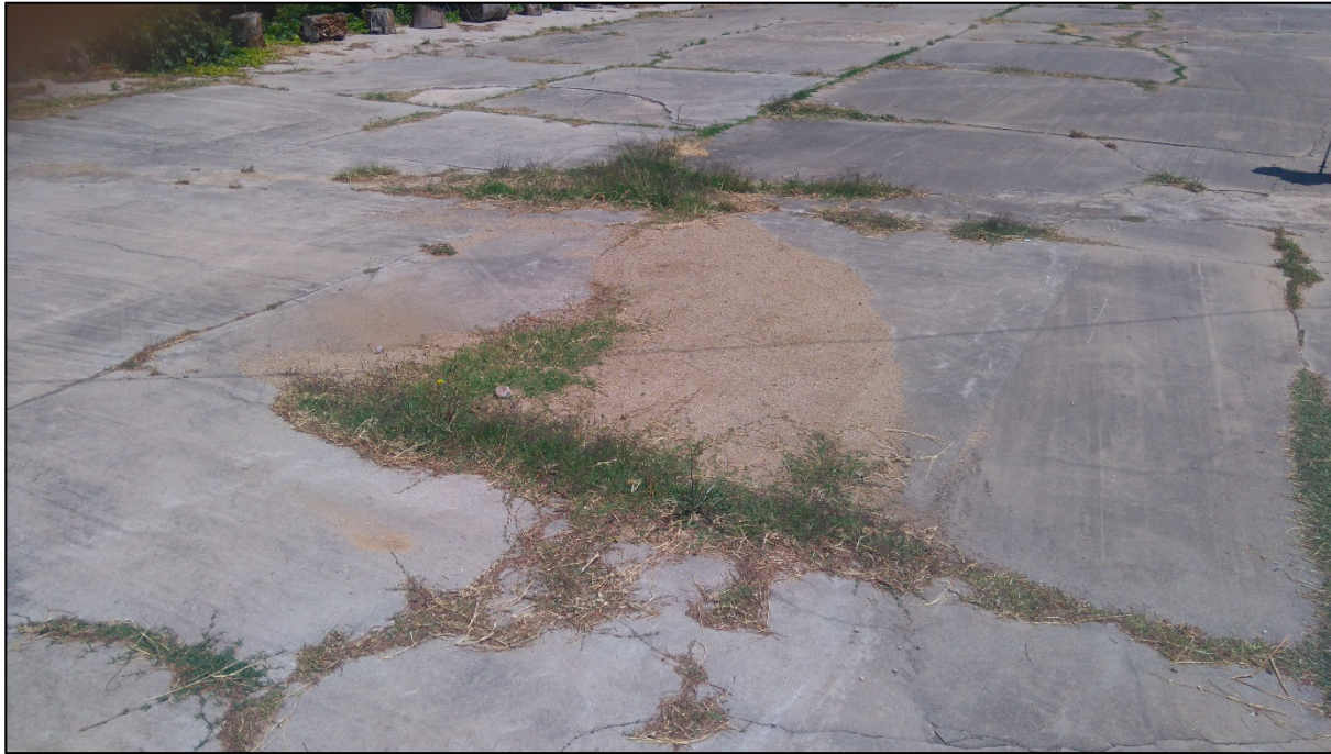
3- Rotura de losas por pérdida del material de apoyo en los peraltes.
