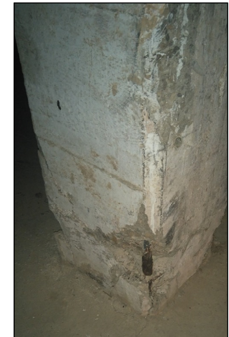
Ilustración 15 - Pilares con las armaduras al aire.
