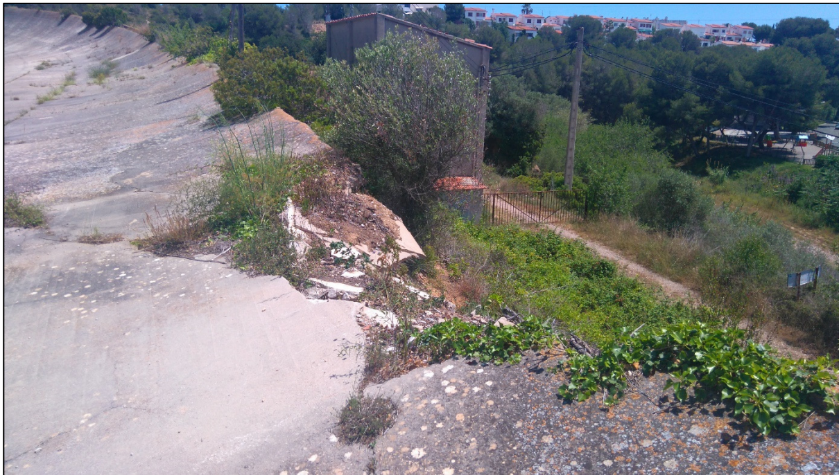
3- Rotura de losas por pérdida del material de apoyo en los peraltes.
