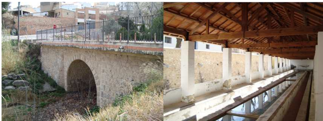
Il·lustració 8 - Imatge del pont de la Travessia del Portal de València i imatge de l'interior del Llavaner Municipal (FONT: elaboració pròpia)
