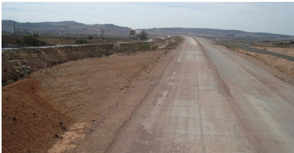
II-lustració 17 - Imatge de les obres de l'autovia A-33 (FONT: elaboració pròpia)
