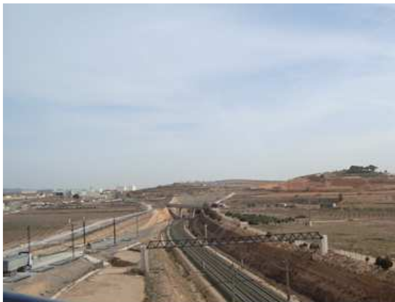
Il·lustració 20 - Imatge de la trinxera i l'entrada del túnel de la AVL (FONT: elaboració pròpia)
