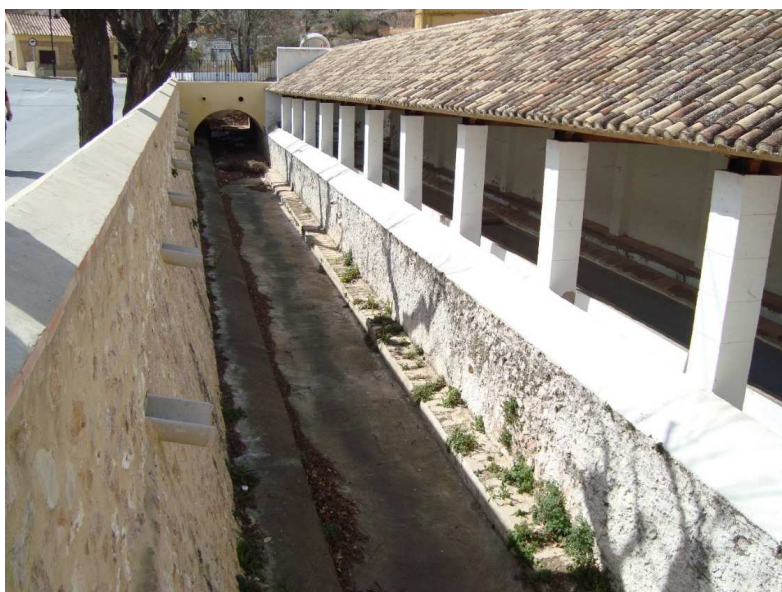
Il·lustració 24 - Imatge del Llavaner Municipal i la canalització actual del Barranc dels Molins (FONT: elaboració pròpia)
