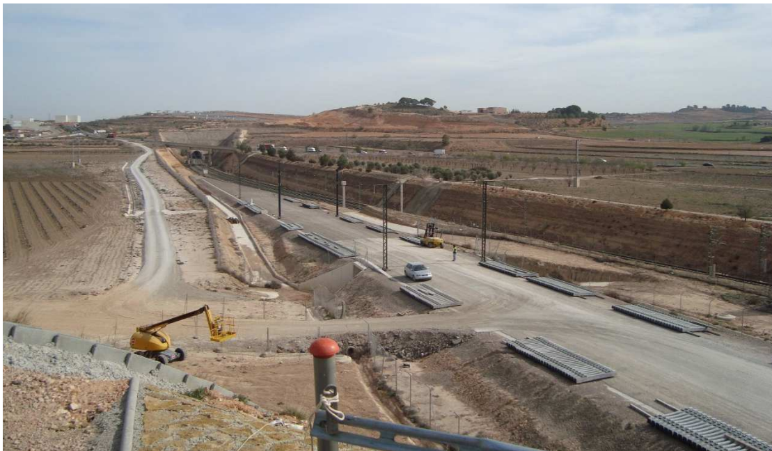
Il·lustració 18 - Imatge durant la construcció de la línia ferroviària de la AVL (FONT: elaboració pròpia)
