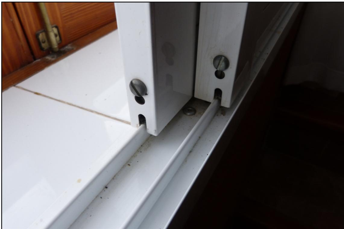
*Ilustración 17. Detalle sistema corredera*
