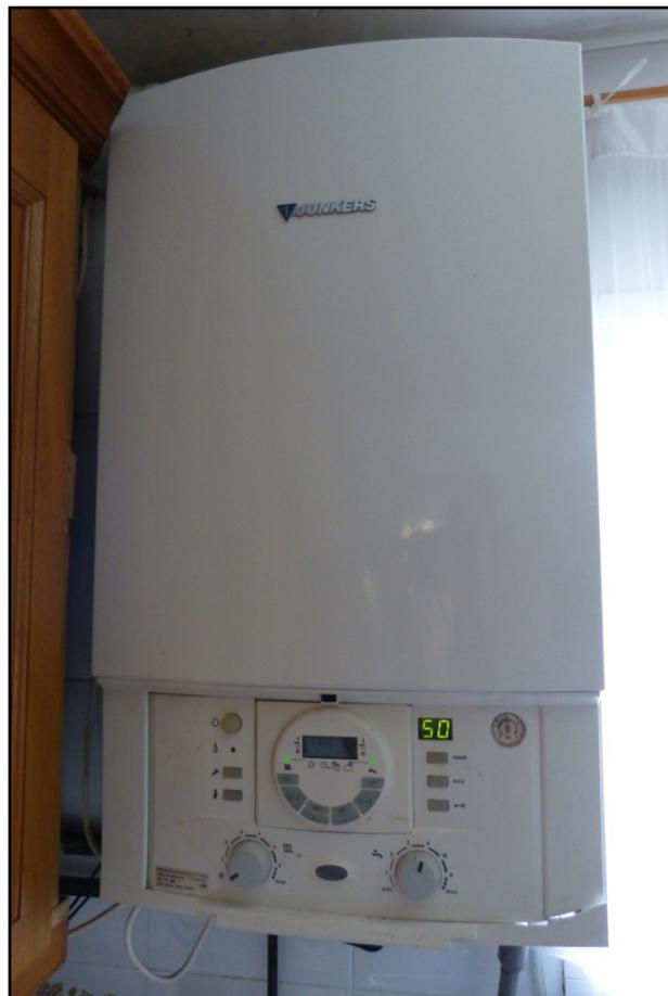
*Ilustración 14. Caldera de condensación de propano*
