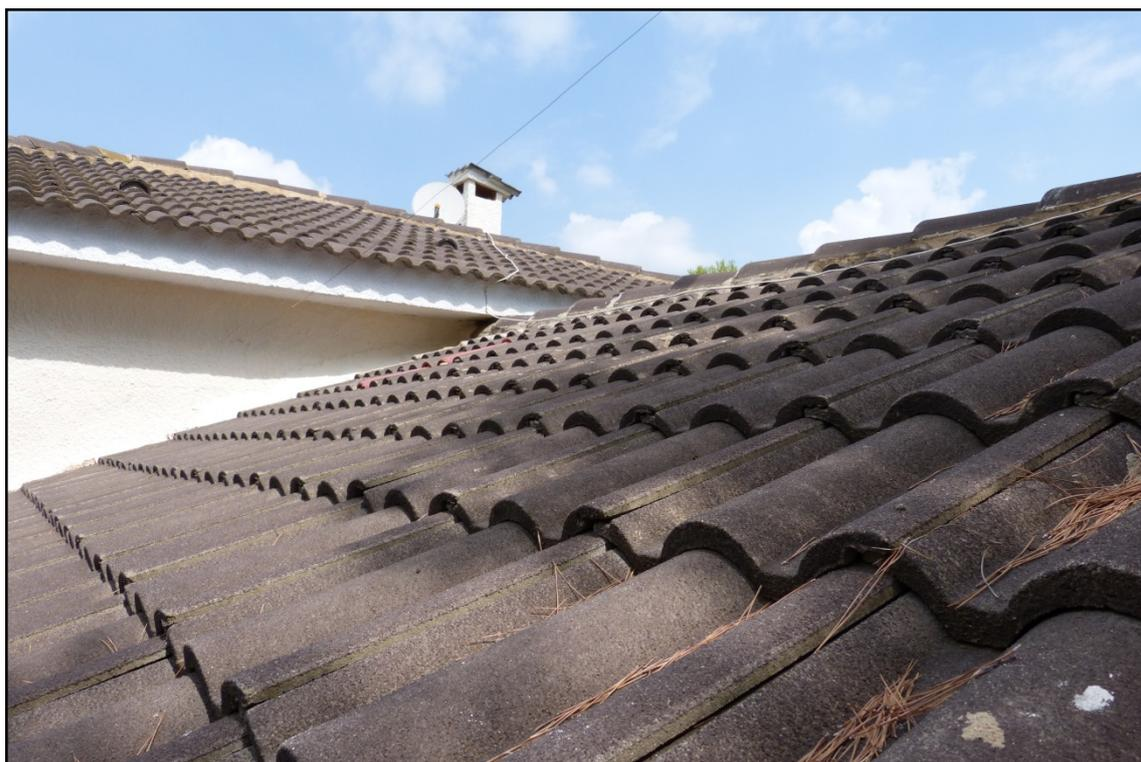
*Ilustración 27. Cubiertas con tejas de hormigón*
