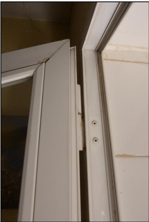
*Ilustración 25. Detalle estanqueidad puerta buhardilla*
