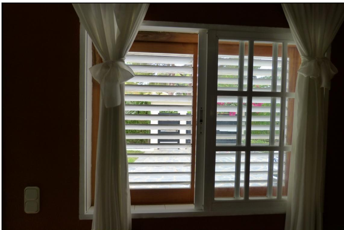
*Ilustración 15. Ventana corredera, perfil de aluminio y vidrio simple*
