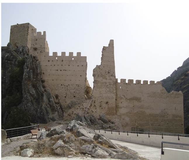
C. Estado actual de la muralla oeste del Castillo de la Iruela tras la intervención de 2006.
