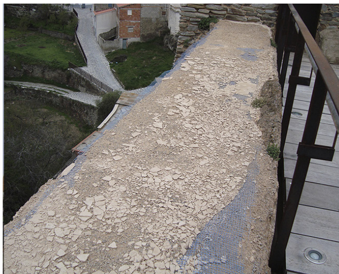
B. Imagen actual de las coronaciones del Castillo de Bacares, en la que se aprecia la degradación de la misma que ha dejado vista la malla de unión.
