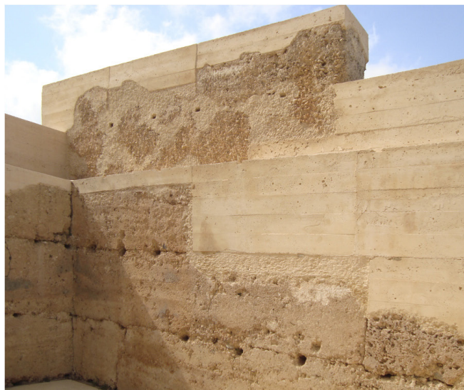
D. Estado actual del Castillo de Carrícola en la que se aprecia la intervención de 2008.
