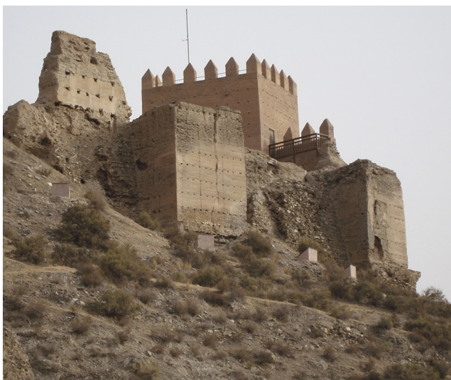
A. Estado actual del Castillo de Tabernas en la que se aprecia la intervención de 1980.
