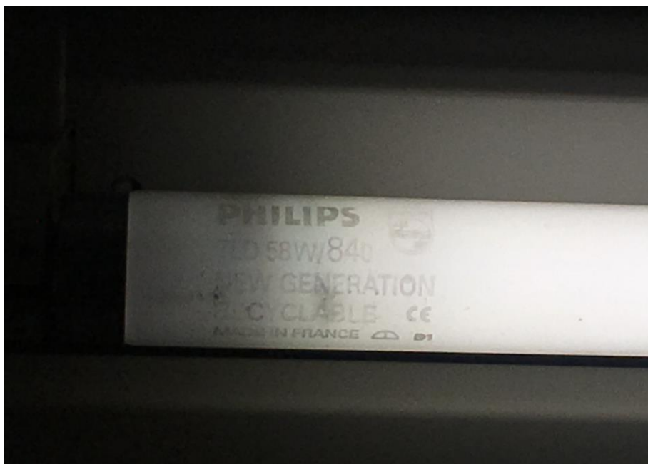
Ilustración 13: fotografía de lámpara Philips TLD 58W/840. (Elaboración propia)
