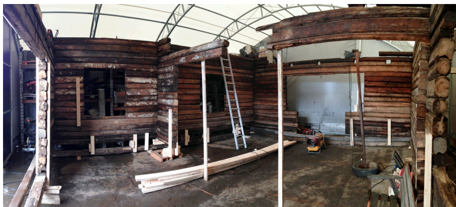
FIGURA 253. Casa de la que proviene la madera usada
