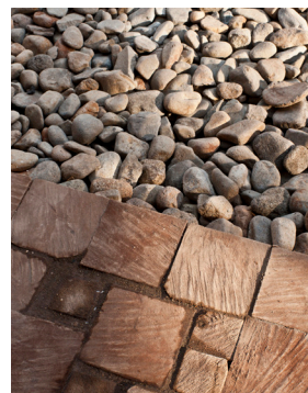
FIGURA 203. Mezcla de texturas y materiales locales
