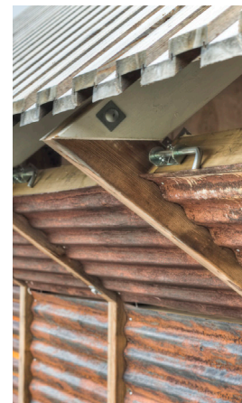
FIGURA 168. Detalle paneles abatibles
