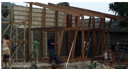
FIGURA 97. Ejecución de la estructura
