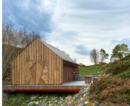
FIGURA 156. Imagen fachada hacia el mar
