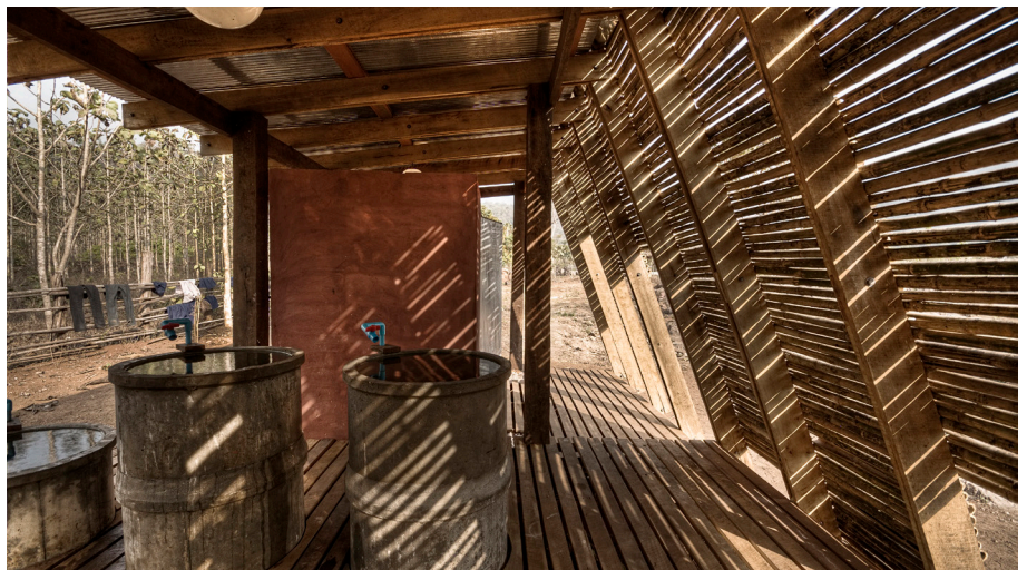
FIGURA 109. Sombras creadas por la fachada de bambú permitiendo la ventilación
