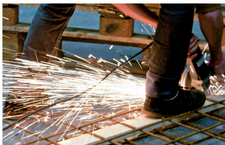
FIGURA 139. Instalación malla metálica
