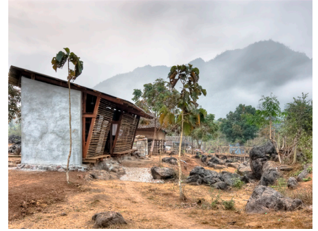
FIGURA 19. Imagen exterior Save Haven Library. 2009
