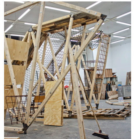
FIGURA 136. Montaje de módulos
