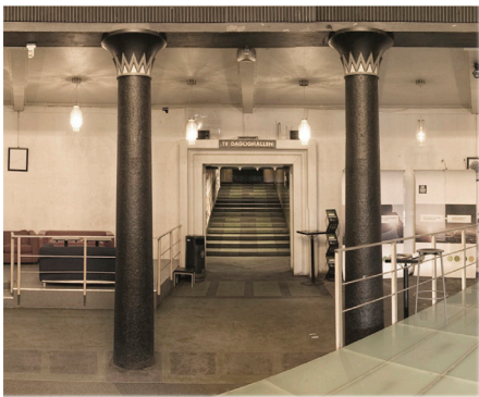
FIGURA 51. Interior antes de la intervención.
