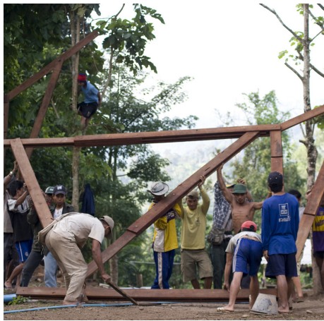
FIGURA 82. Ejecución de la estructura
