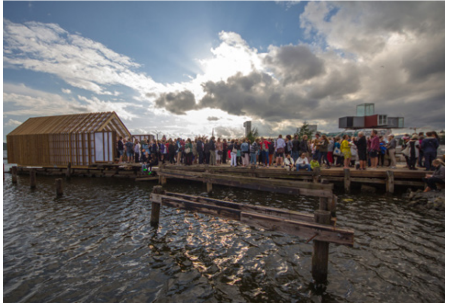
FIGURA 210. Plataforma de acceso al edificio
