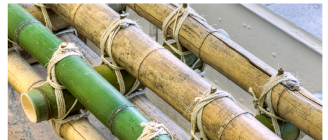
FIGURA 142. Detalle unión bambú con cuerda
