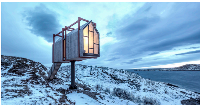
FIGURA 302. Caseta elevada con estructura exterior
