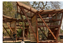
FIGURA 80. Cubierta metálica y estructura de madera
