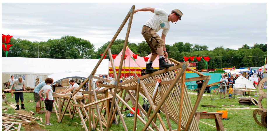
FIGURA 152. Construcción base triangulada del escenario
