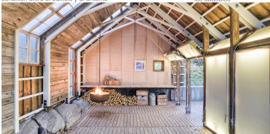
FIGURA 169. Elementos auxiliares (banco de trabajo almacenamiento y caldero) incorporados en la estructura vista. Revestimientos y ventanas reciclados instalados de suelo a techo.
