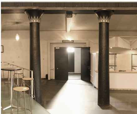
FIGURA 49. Interior antes de la intervención.
