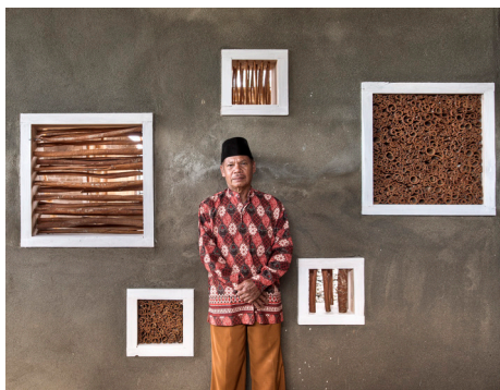
FIGURA 205. Uso de ramas de canela en las ventanas
