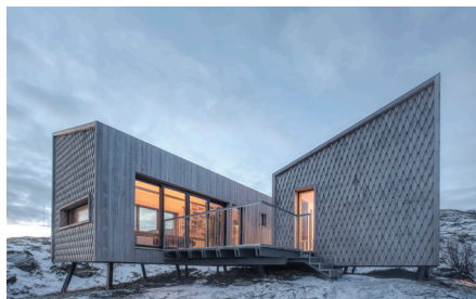
FIGURA 305. Detalle revestimiento exterior
