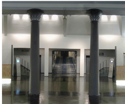
FIGURA 52. Interior después intervención.
