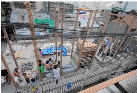
FIGURA 181. Ejecución de la estructura
