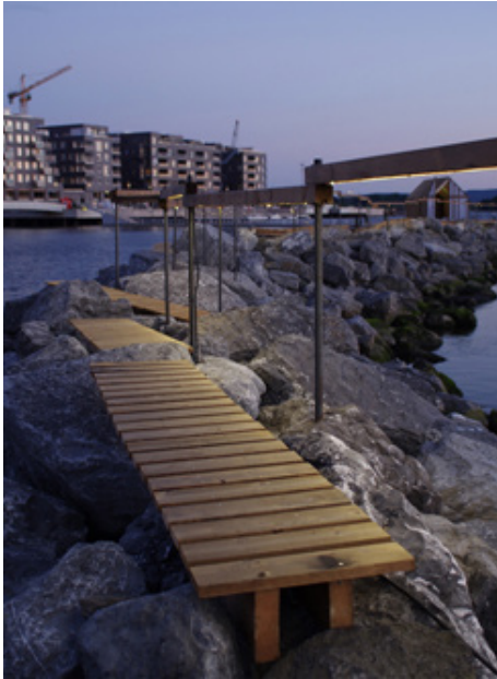
FIGURA 211. Paseo de acceso sobre el dique
