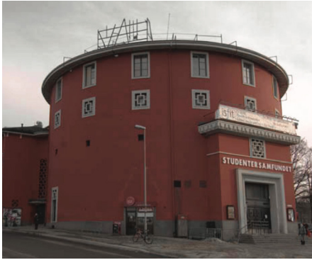
FIGURA 43. Fachada antes de la reforma.
