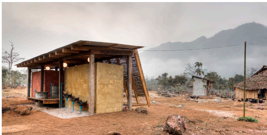
FIGURA 105. Imagen exterior núcleos macizos
