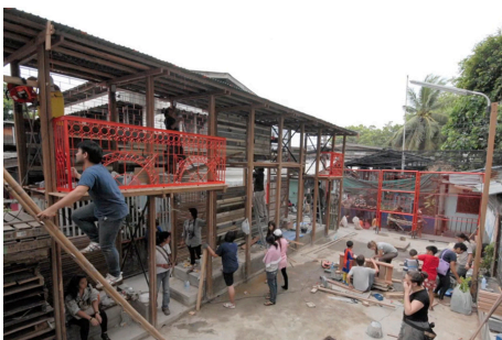
FIGURA 184. Instalación barandillas de hierro
