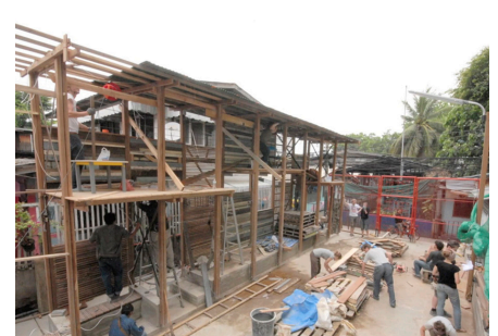
FIGURA 183. Instalación de la cubierta
