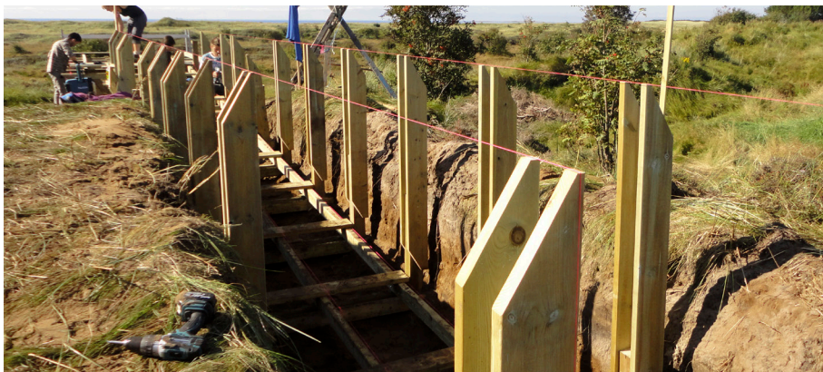
FIGURA 246. Detalle ejecución de cimentación
