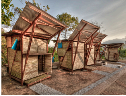
FIGURA 18. Imagen exterior Soe Ker Tie House. 2008
