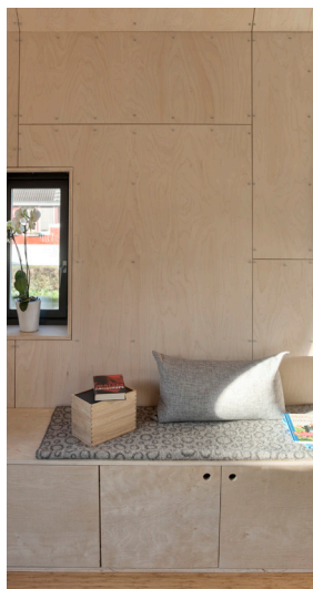
FIGURA 265. Estanterías integradas en el revestimiento
