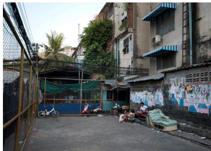
FIGURA 179. Estado anterior a la intervención
