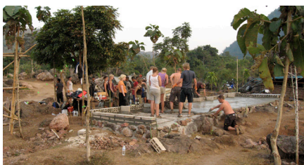
FIGURA 95. Ejecución de solera
