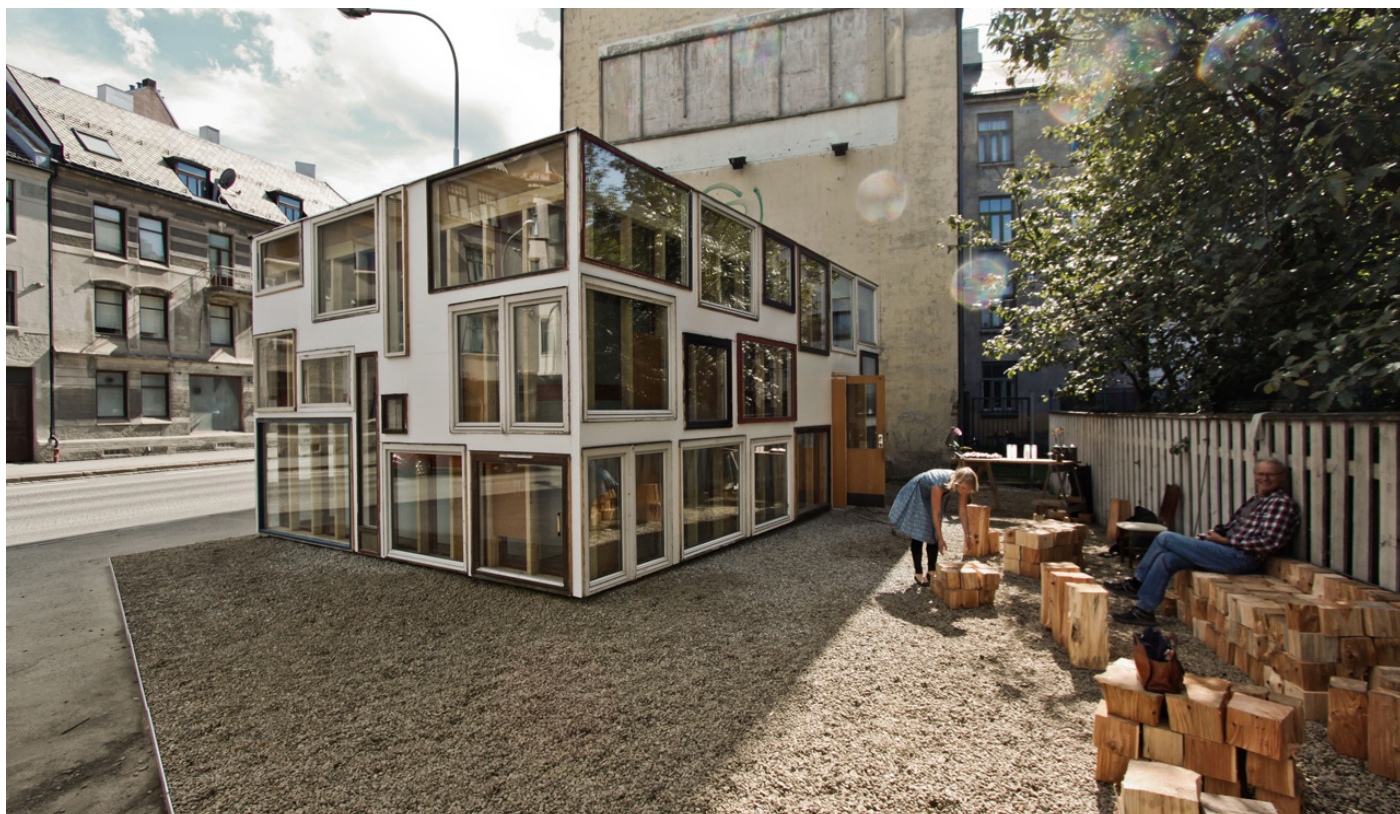
FIGURA 192. Imagen exterior del edificio
