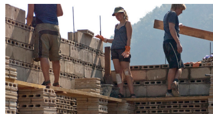
FIGURA 96. Ejecución fachada de bloques
