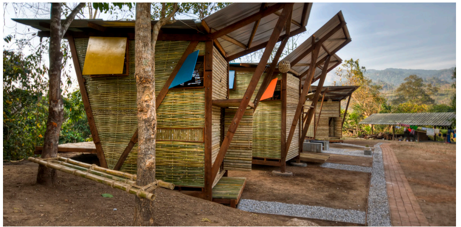
FIGURA 81. Vía de drenaje frente a las unidades y paneles pintados que dan aspecto lúdico
