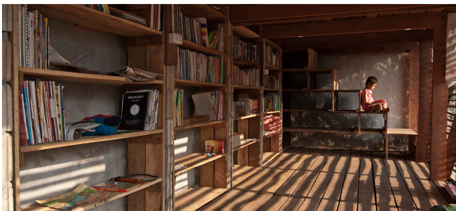
FIGURA 100. Estanterías integradas en la estructura
