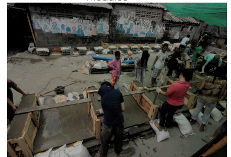
FIGURA 180. Solera de hormigón
