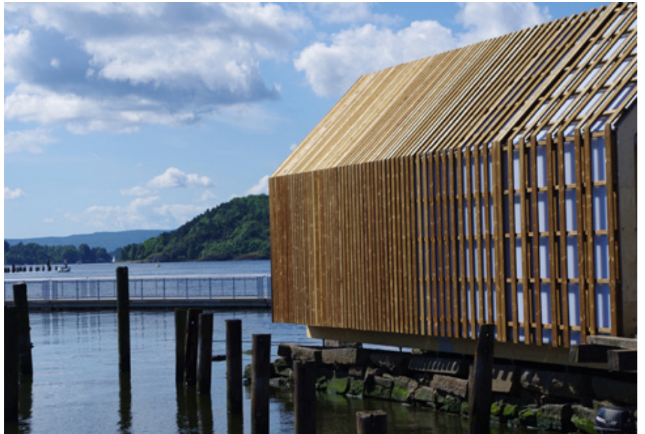
FIGURA 212. Los listones de madera se va espaciando dejando ver el revestimiento plástico
