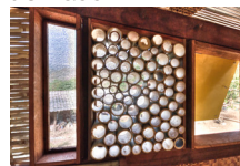
FIGURA 79. Bambú en ventanas
