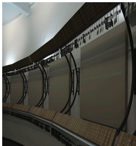
FIGURA 69. Paneles acústicos tapizados
