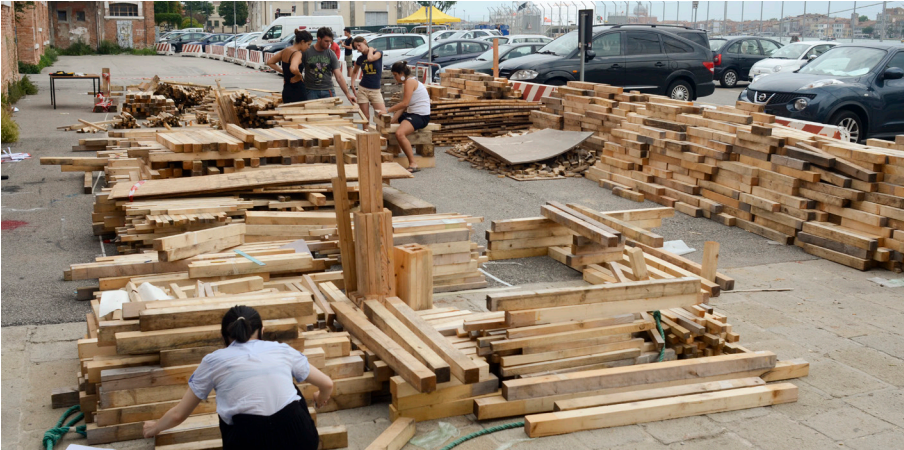
FIGURA 233. Preparación del material para la construcción
