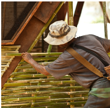
FIGURA 84. Trenzado del bambú
