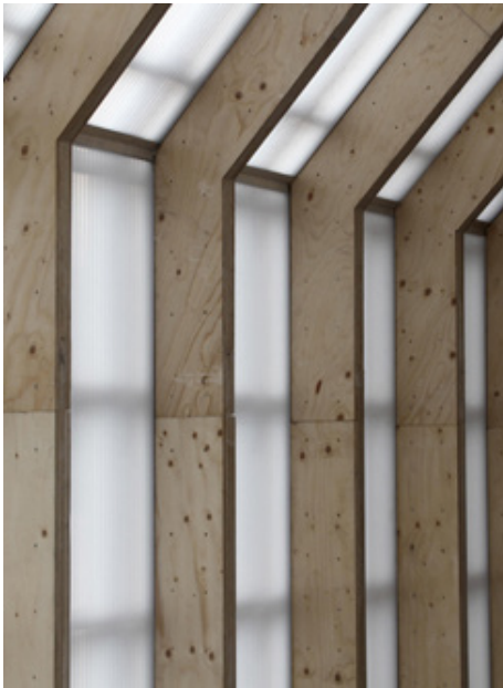
FIGURA 213. Detalle estructura de madera
