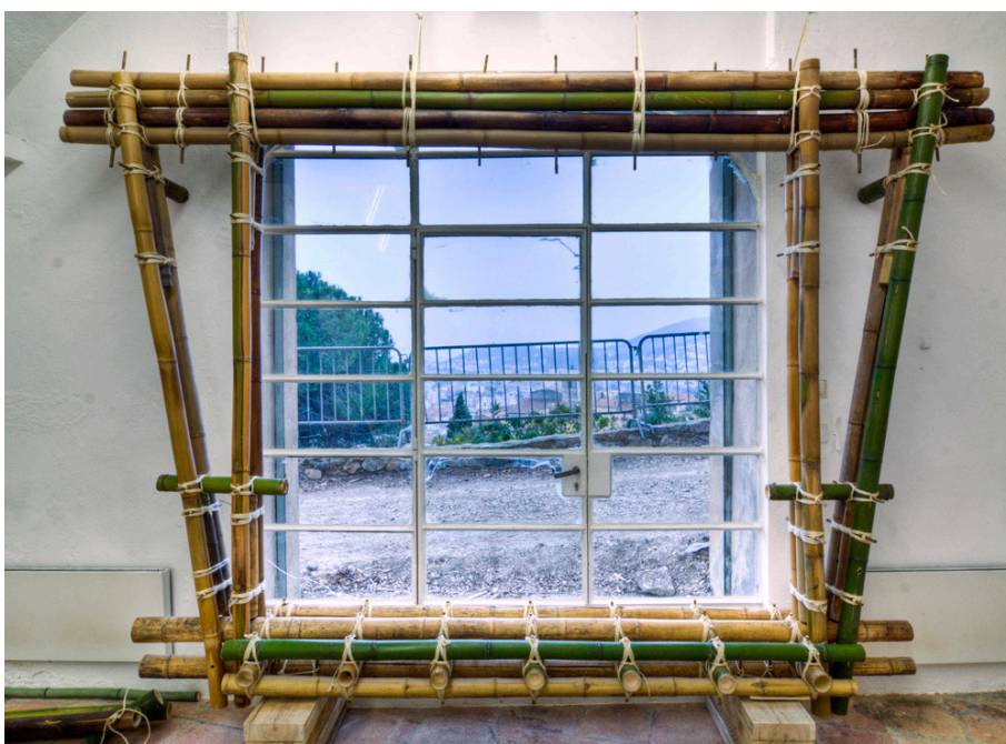
FIGURA 147. Estructura de bambú unida con cuerda
