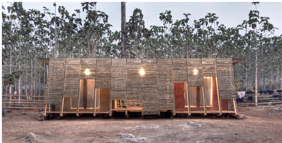
FIGURA 104. Imagen exterior, fachada realizada con cañas de bambú
