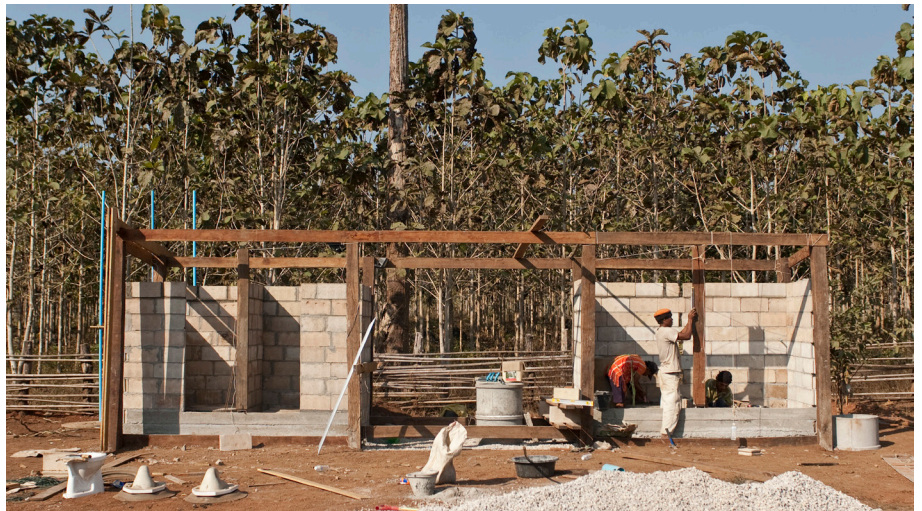
FIGURA 108. Construcción del edificio
