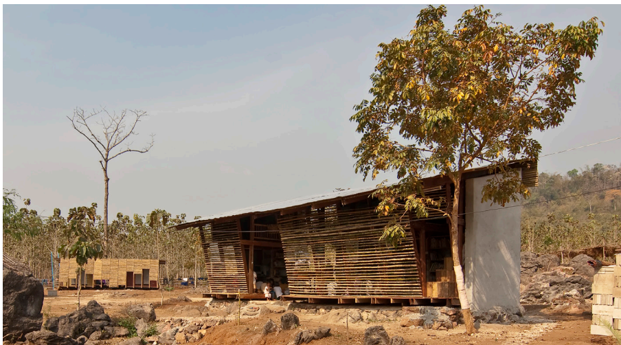
FIGURA 94. Fachada realizada con bambú
