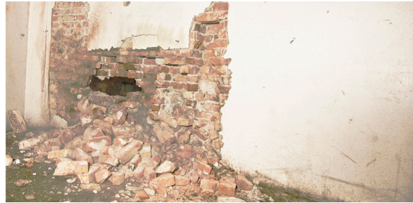
FIGURA 55. Demolición de muros
