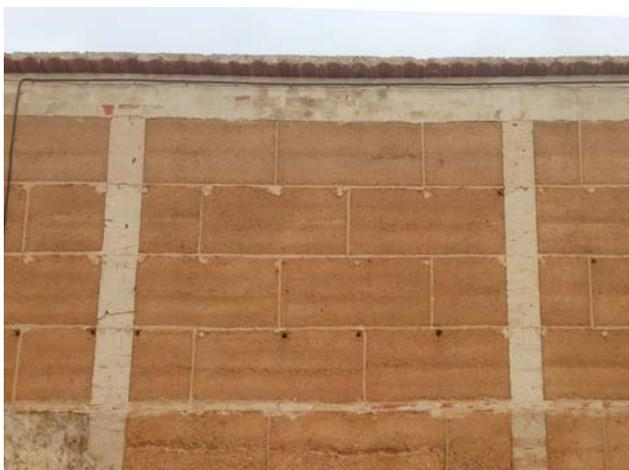
Figura 4.39. Tapia con juntas de yeso en Villaspesa, Teruel.
