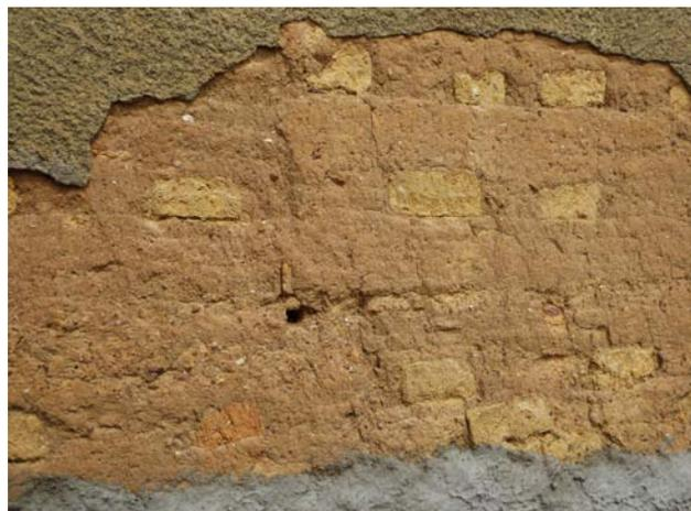
Figura 4.36. Detalle de un muro de tapia careada con adobe en Molezuelas de la Carballeda, Zamora.
