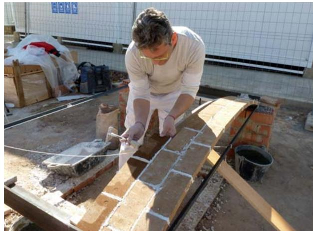
Figura 3.19. Construcción de una bóveda tabicada de BTC en la Universitat Politècnica de València.
