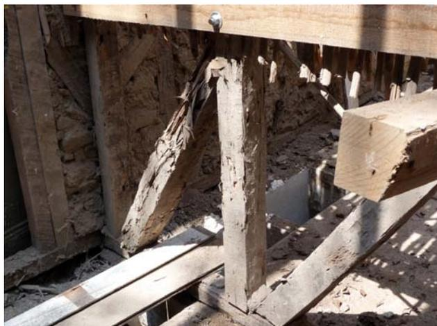
Figura 6.4. Intervención de la madera dañada de un panel de quincha en una construcción en Barranco, Lima.
