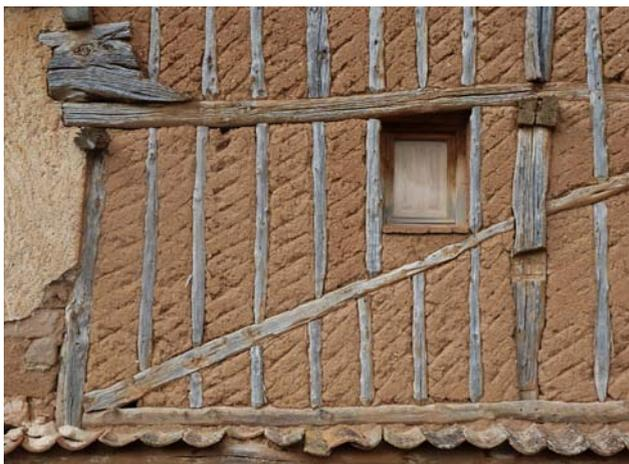
Figura 6.19. Muro entramado relleno de adobes inclinados en un edificio en Navapalos, Soria.
