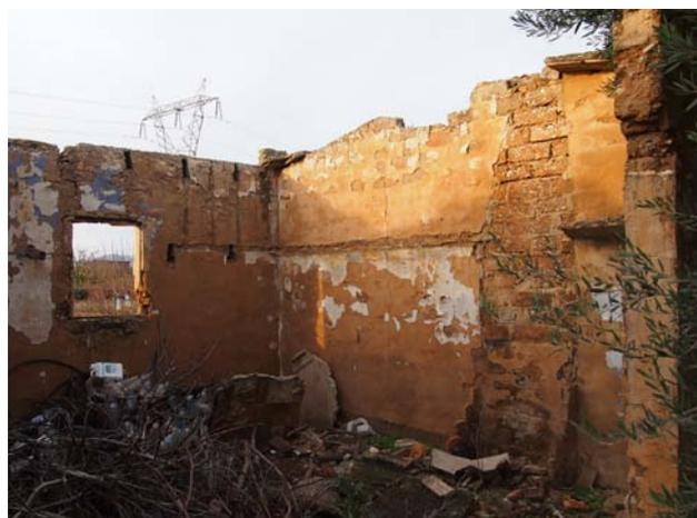
Figura 3.12. Construcción de fábrica de bloques de tierra y cemento en l'Alcúdia, Valencia.
