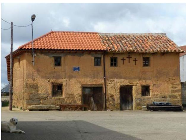
Figura 9.27. Sustitución parcial de la cubierta en un edificio en Molezuelas de la Carballeda, Zamora.
