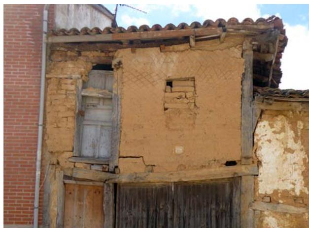
Figura 7.56. Paño de adobe dañado por la excesiva deformación del dintel inferior en una construcción en Roscales de la Peña, Palencia.
