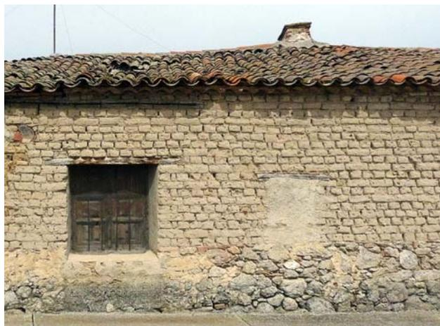
Figura 5.29. Fábrica de adobe a soga y tizón en una construcción en Santiago de la Puebla, Salamanca.
