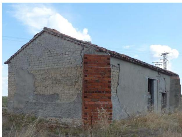
Figura 9.16. Estabilización con machones de ladrillo de un edificio de adobe en Arroyo de Cuéllar, Segovia
