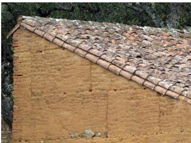
Figura 4.38. Esquinas careadas con ladrillo en una tapia en Santa Ana la Real, Huelva.
