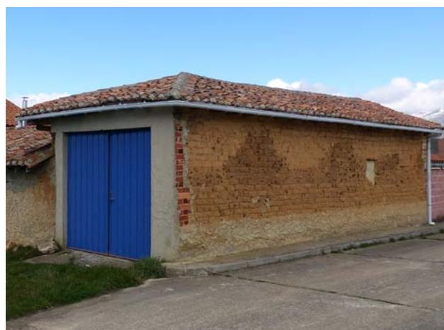
Figura 9.5. Adaptación de un vano para el paso de vehículos en Roscales de la Peña, Palencia.
