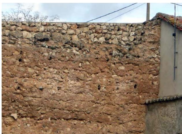
Figura 4.25. Muro de mampostería encofrada en Ci-fuentes, Guadalajara.
