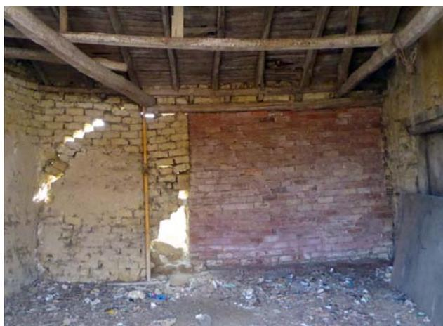
Figura 7.57. Colapso de un muro inducido por la degradación de las jambas del acceso en una construcción en Lagunilla de la Vega, Palencia.
