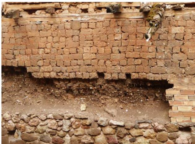
Figura 7.7. Pérdida de sección en un muro de adobe provisto de zócalo en Poza de la Sal, Burgos.
