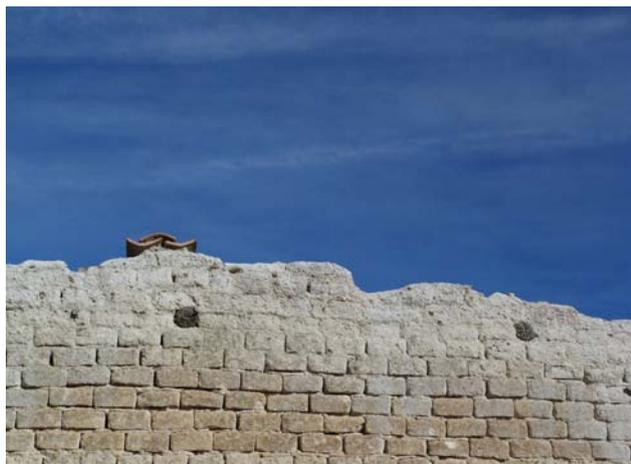
Figura 7.9. Lavado de la coronación de un muro de adobe en Hérmedes de Cerrato, Palencia.
