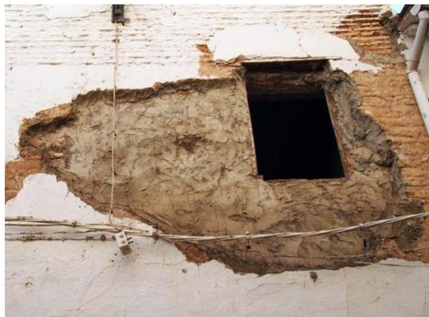
Figura 1.3. Muro de tapia valenciana reparado con mortero de cemento en L'Alcúdia, Valencia.
