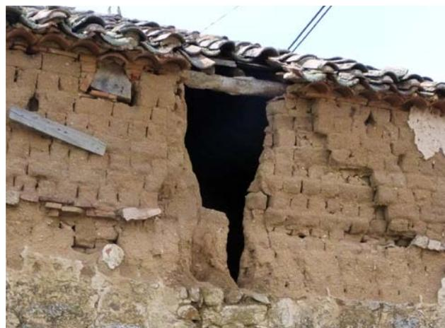
Figura 7.40. Erosión de un muro por efecto de la degradación del alero en un edificio en Muñana, Ávila.
