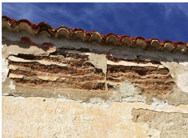
Figura 4.33. Tapia calicostrada con pérdida parcial de la costra en una construcción en Tarazona de la Mancha, Albacete.
