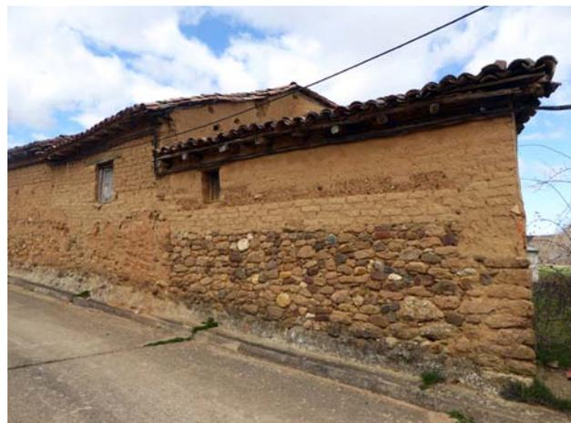
Figura 5.27. Fábrica simple de adobe a soga en una construcción en Santana de la Peña, Palencia.
