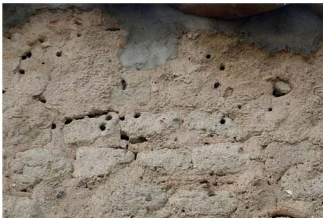
Figura 7.33. Muro de adobe perforado por insectos en Ledesma, Salamanca.
