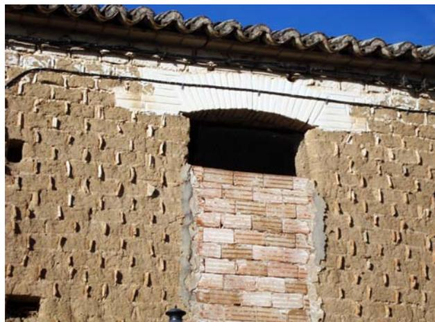
Figura 5.37. Fábrica de adobe con inserciones cerámicas en las juntas en un edificio en el Puente del Arzobispo, Toledo.
