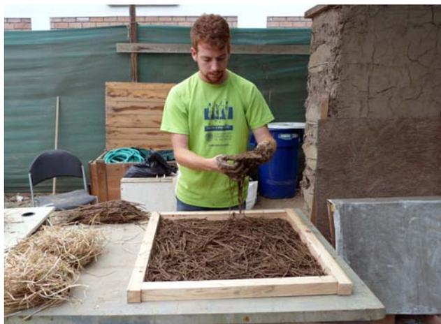
Figura 2.17. Fabricación de paneles de aislamiento de tierra aligerada durante la colaboración en el proyecto de mejora de la vivienda altoandina desarrollado por el Centro Tierra de la PUCP.
