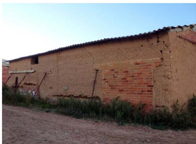
Figura 7.69. Inestabilidad por la pérdida de sección sufrida en la base de un edificio en Valderas, León.
