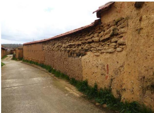
Figura 5.69. Cerca construida con tapia y tepes a tizón en Molezuelas de la Carballeda, Zamora.
