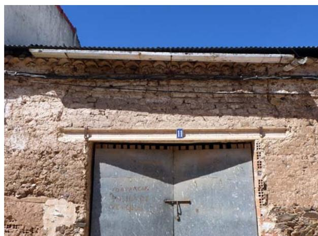
Figura 7.63. Formación de un arco de descarga sobre un hueco. Horcajo de los Montes, Ciudad Real.
