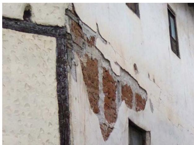
Figura 7.43. Reparación inadecuada de un edificio de entramado en Covarrubias, Burgos.
