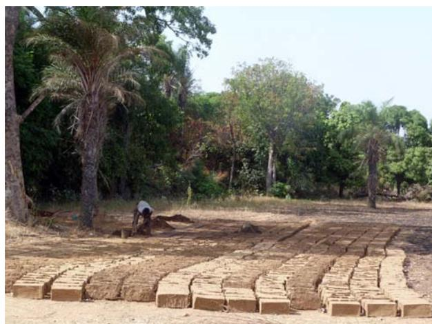
Figura 5.11. Moldeado de los adobes formando una retícula para optimizar la superficie de la adobería.
