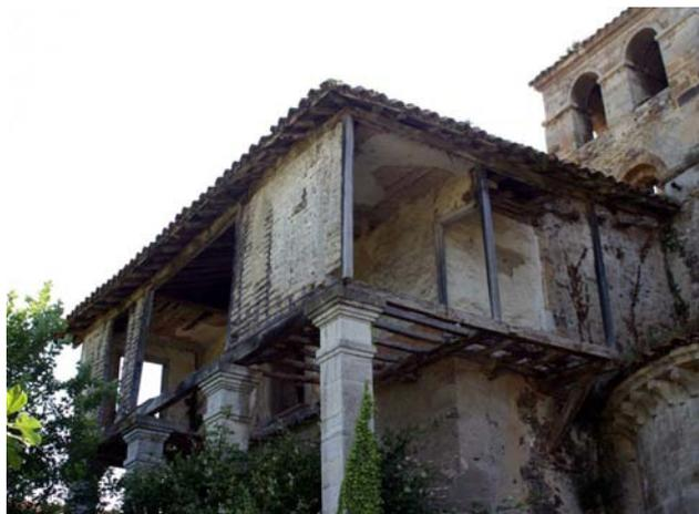
Figura 6.39. Pared de listón en un edificio en Cornellana, Asturias (MECD, 2017).
