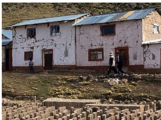
Figura 7.70. Construcciones de adobe dañadas por un sismo en la región de Puna, Perú.
