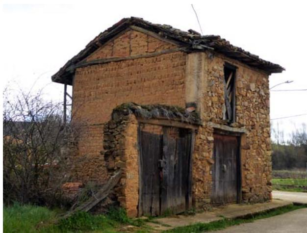
Figura 5.15. Construcción con fachada de piedra y medianeras de terrones en Cubo de Benavente, Zamora.
