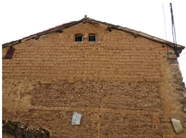
Figura 5.78. Tapia de tierra vertida con verdugadas de terrones en Cubo de Benavente, Zamora.
