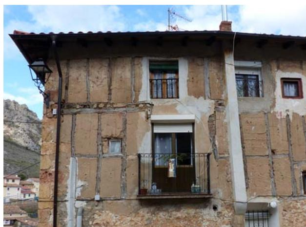
Figura 6.34. Edificio de muros entramados con relleno de tapialete en Poza de la Sal, Burgos.
