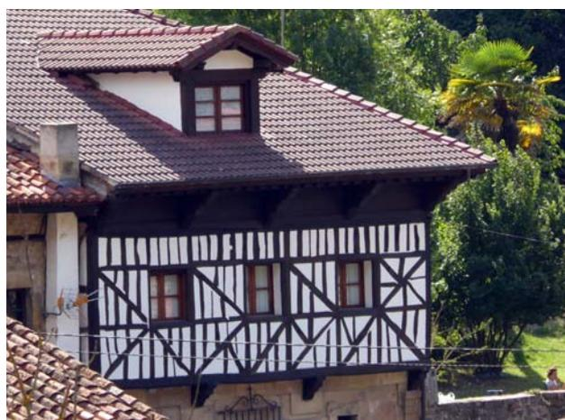
Figura 9.24. Edificio de entramado rehabilitado en Frama, Cantabria.
