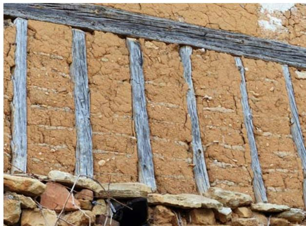
Figura 6.18. Muro entramado relleno de adobes apilados en horizontal en un edificio en Calatañazor, Soria.
