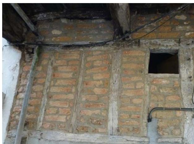
Figura 9.11. Adobes rejuntados con cemento en un entramado en Garganta la Olla, Cáceres.
