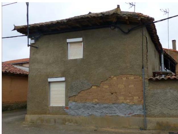
Figura 7.42. Problemas de adherencia en una construcción revestida con cemento en Molezuelas de la Carballeda, Zamora.
