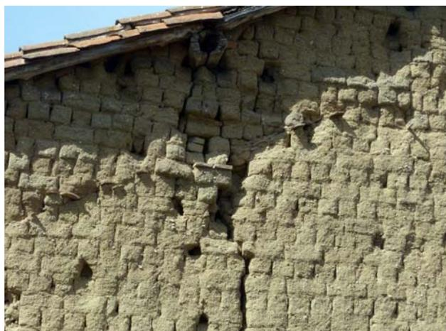
Figura 7.54. Fisuración de un muro de adobe en el apoyo de un viga. Muñana, Ávila.
