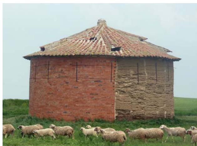
Figura 9.13. Reconstrucción parcial con ladrillo de un edificio en Tierra de Campos, Palencia.
