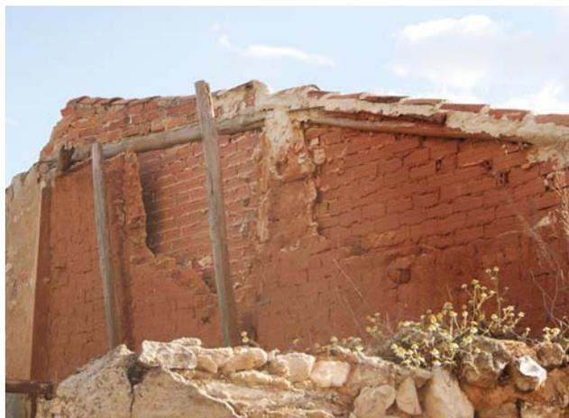
Figura 7.66. Problemas de compatibilidad entre un muro de tierra y un trasdosado de ladrillo en una construcción en Godos, Teruel.
