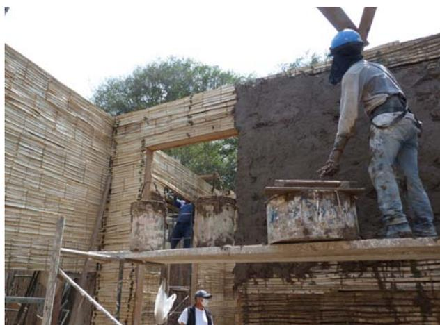
Figura 2.15. Aplicación de torta de barro sobre nuevos paneles de quincha en una obra de rehabilitación
