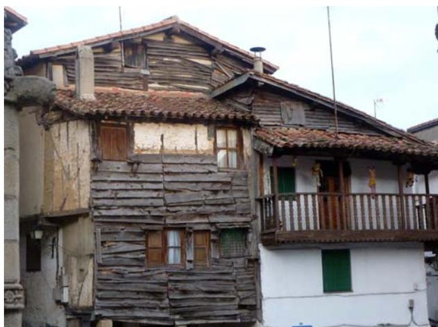
Figura 6.49. Revestimiento de madera sobre muros entramados en Valverde de la Vera, Cáceres.
