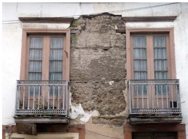
Figura 4.53. Tapia con verdugadas de tablas en Monforte de Lemos, Lugo.
