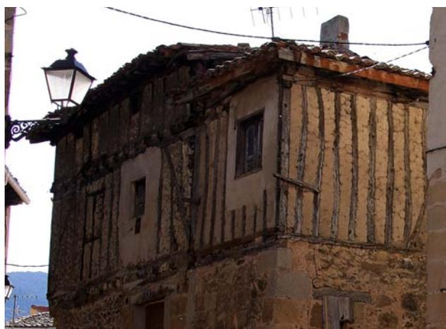
Figura 6.33. Edificio de muros entramados con relleno de pared de pellas en Cantabrana, Burgos.
