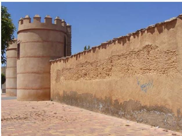
Figura 7.44. Alteración del carácter de una cerca de tapia por la construcción de un nuevo acceso en forma de torreón. Minaya, Albacete.
