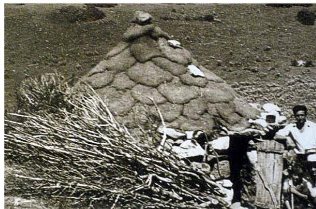
Figura 5.19. Cubierta de tapines en los Puertos de Agüeria, Quirós, Asturias (Paredes y García Martínez, 2006).
