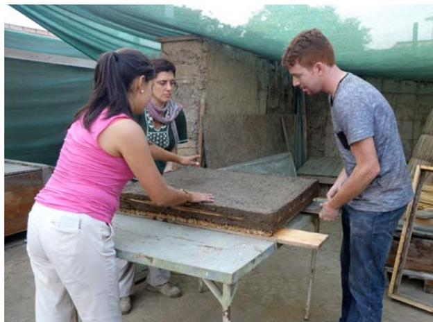
Figura 2.18 Construcción de un panel autoportante de tierra aligerada y totora durante la colaboración en el proyecto de mejora de la vivienda altoandina desarrollado por el Centro Tierra de la PUCP.
