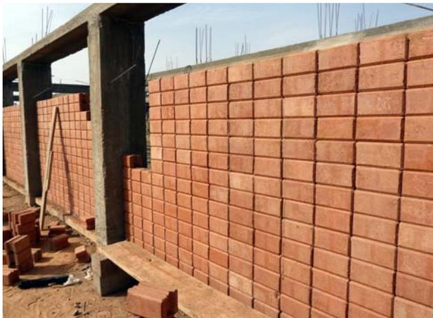
Figura 3.18. Construcción de un edificio con estructura de hormigón armado y cerramiento no estructural de BTC en Uagadugú, Burkina Faso.
