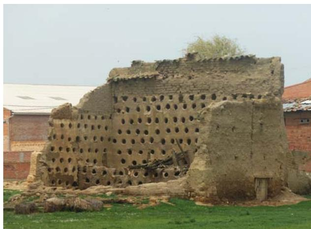
Figura 7.3. Manchas de humedad en la base de un muro de tapia en Tierra de Campos, Palencia.
