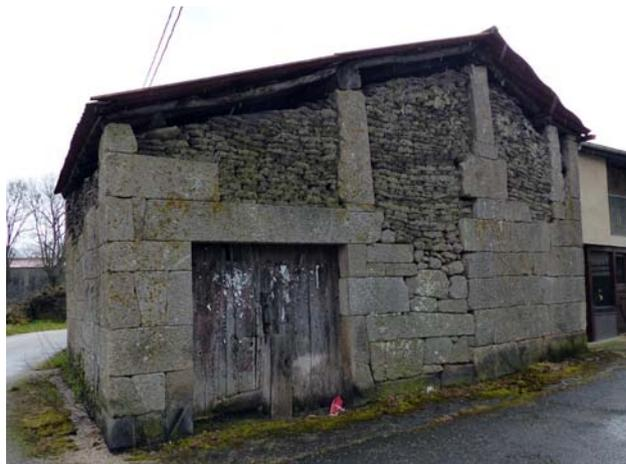
Figura 5.70. Edificio con estructura de sillería y cerramiento de tepes en Lavandeira, Ourense.
