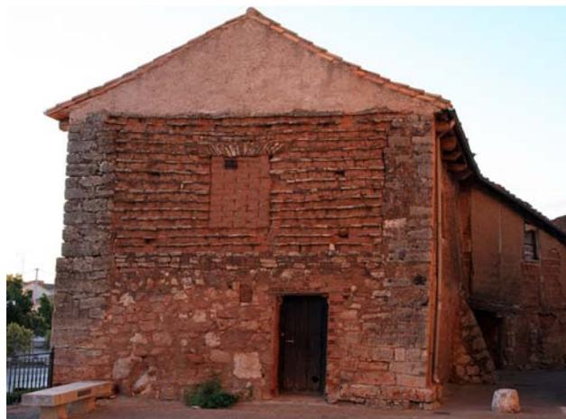
Figura 5.61. Fábrica con hiladas alternas de adobe y lajas de piedra y machones de piedra en una construcción en Mahamud, Burgos.
