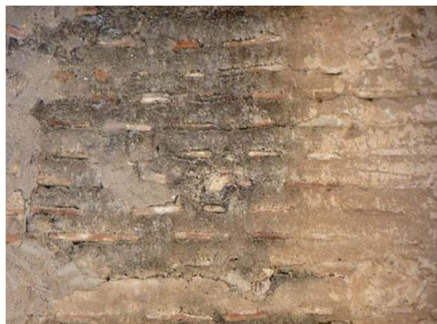
Figura 4.34. Detalle de un muro de tapia calicostrada y careada con ladrillo en Avinyonet del Penedés, Barcelona.
