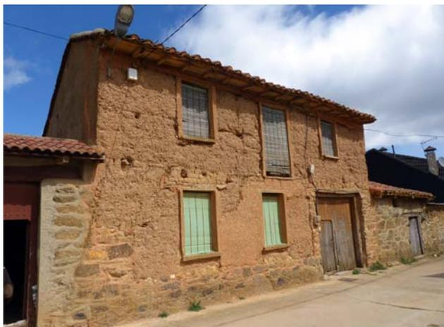
Figura 4.6. Construcción de tapia con zócalo de piedra y alero pronunciado en Molezuelas de la Carballeda, Zamora.
