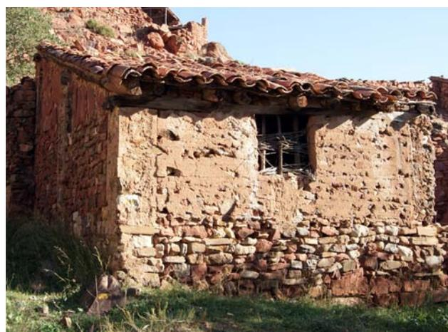
Figura 4.26. Tapia de yeso y mampuestos en una construcción en Peñarroyas, Teruel.
