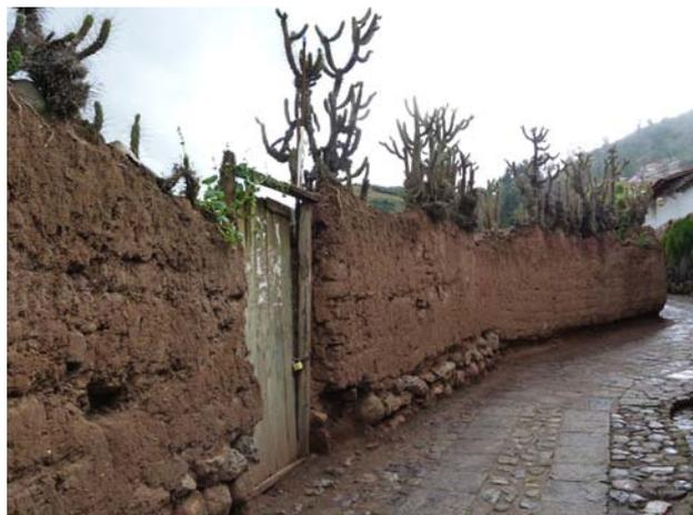
Figura 2.14. Empleo de cactus para consolidar la coronación de un muro de adobe en Cusco.
