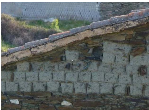
Figura 5.44. Fábrica de adobe con juntas enripiadas con lajas de piedra en una construcción en La Estrella, Toledo.
