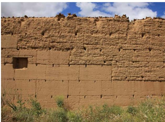
Figura 3.9. Construcción de tapia de tierra en Barcial de la Loma, Valladolid.
