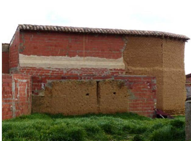
Figura 7.2. Construcción de adobe reparada con ladrillo y cemento en Grajal de Campos, León.
