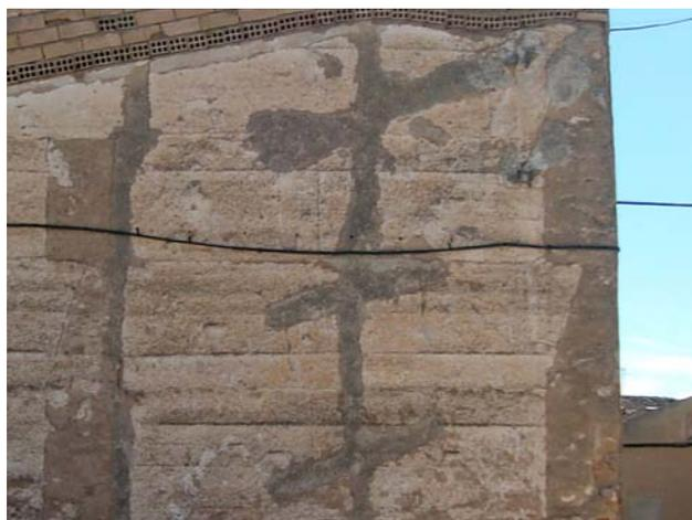
Figura 9.15. Grieta sellada con cemento en un muro de tapia en Barrax, Albacete.
