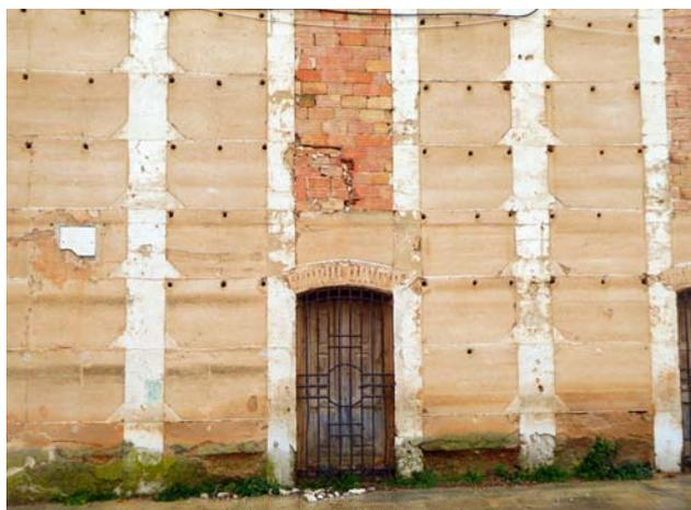
Figura 7.5. Proliferación de moho en la base de un edificio de tapia en Monreal del Campo, Teruel.
