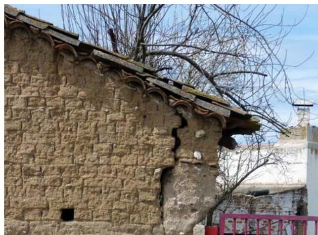
Figura 7.58. Giro de la fachada por empuje de la cubierta en un edificio en Santiago de la Puebla, Salamanca.
