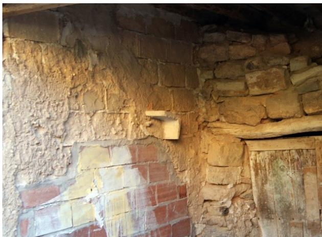
Figura 5.28. Fábrica de adobe a panderete en una construcción en Montalbán, Teruel.
