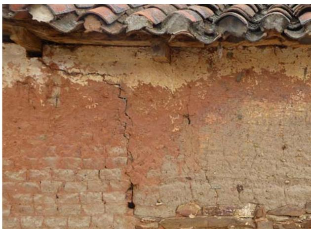
Figura 7.55. Fisuración en el apoyo de una viga se desvía hacia una junta constructiva. Construcción en San Pedro de la Viña, Zamora.
