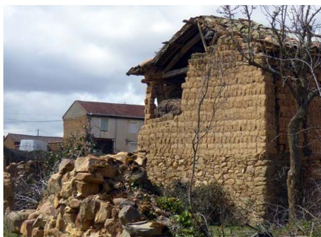
Figura 5.77. Fábrica de terrones con pies derechos de madera en Cubo de Benavente, Zamora.
