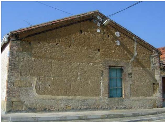
Figura 4.23. Construcción de tapia simple en Arce-diano, Salamanca.
