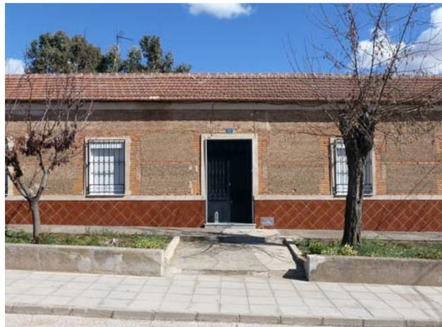
Figura 4.24. Tapia de hormigón en Fuente del Fresno, Ciudad Real.
