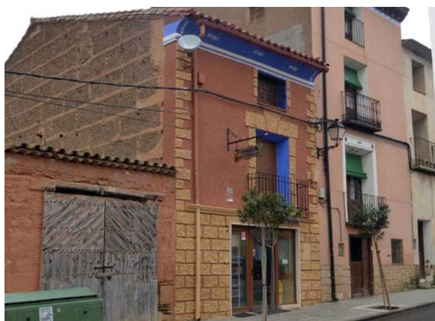
Figura 9.23. Edificio de tapia con fachada revestida con mortero monocapa en Báguena, Teruel.
