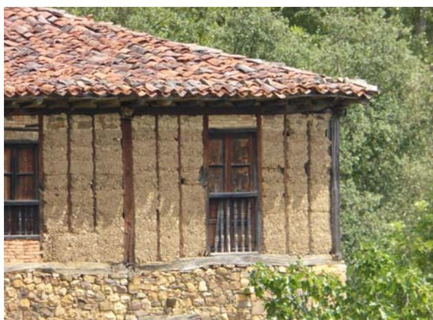
Figura 6.35. Edificio de muros entramados con relleno de hormigón de cal en Cambarco, Cantabria.
