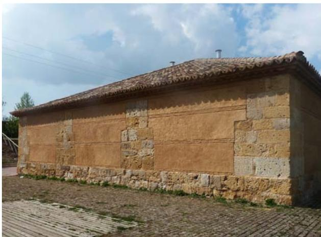
Figura 5.62. Edificio de adobe con machones de sillería y verdugadas de ladrillo en Medina de Rioseco, Valladolid.
