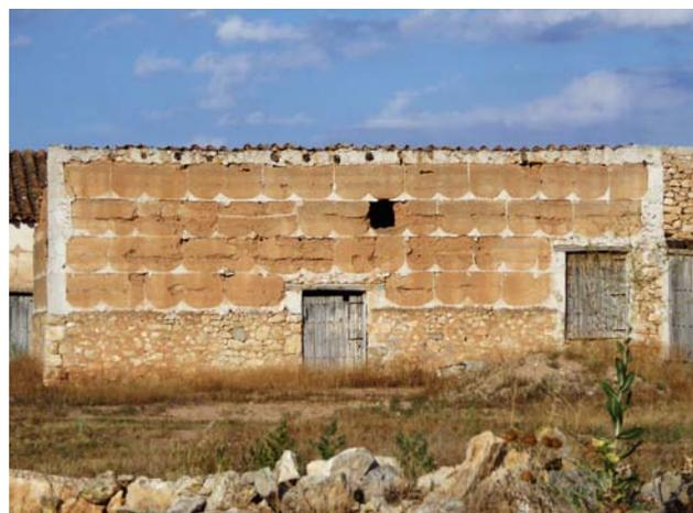
Figura 3.10. Construcción de tapia con brecas de yeso en Villarquemado, Teruel.
