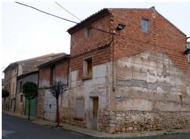
Figura 9.8. Sobreelevación de un edificio de tapia en Villarquemado, Teruel.
