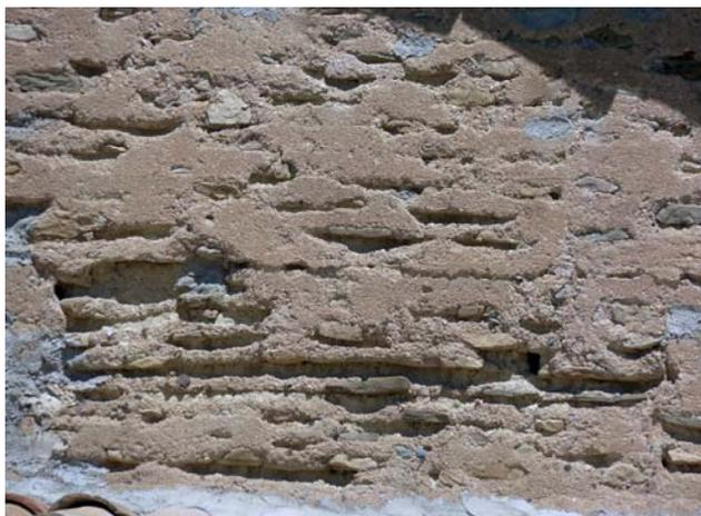
Figura 4.35. Detalle de un muro de tapia calicostrada y careada con piedra en San Vicenç de Malla, Barcelona.
