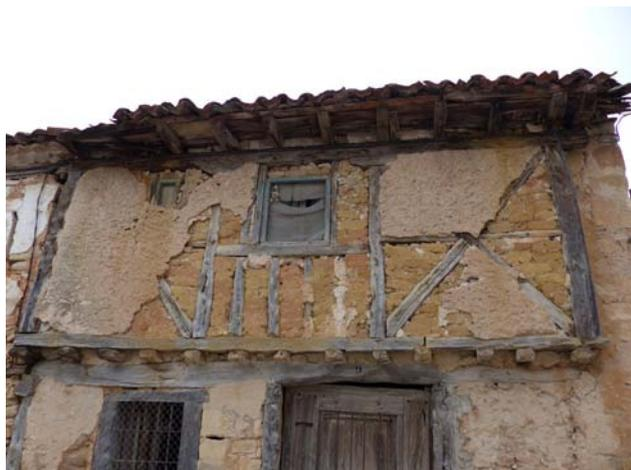
Figura 6.47. Revestimiento de cal sobre un muro entramado en Santo Domingo de Silos, Burgos.
