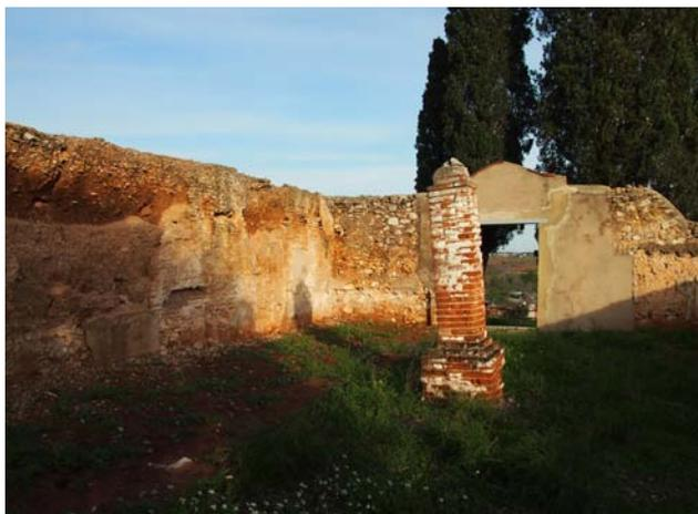
Figura 1.2. Cerca de tapia calicostrada en el cementerio abandonado de Montortal, Valencia.
