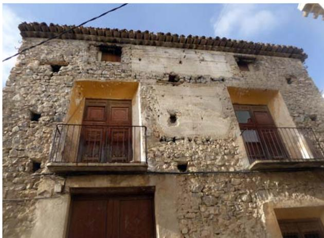
Figura 4.64. Tapia encajonada entre machones y verdugadas de piedra en Mortatalla, Murcia.
