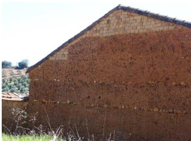
Figura 5.67. Formación de pendientes con adobe en un muro piñón de tapia en Navalpino, Ciudad Real.
