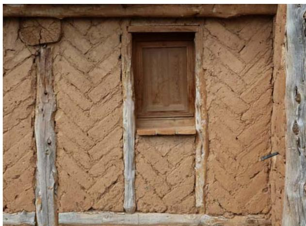
Figura 6.15. Muro entramado relleno de adobe en una construcción en Navapalos, Soria.
