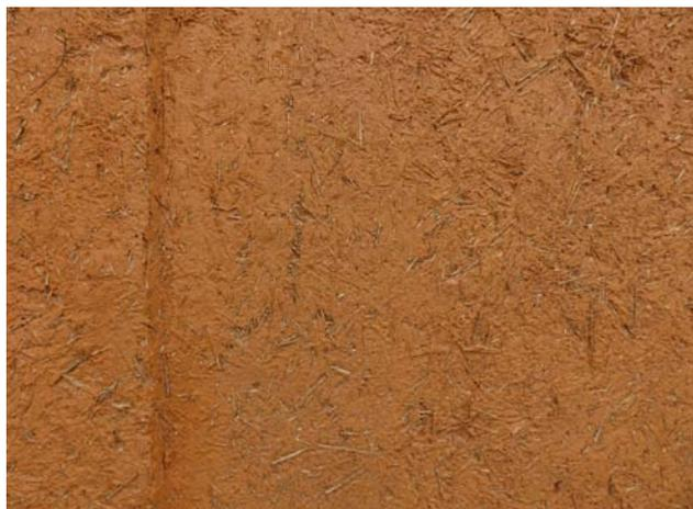
Figura 5.3. Detalle de un revoco de tierra en Molezuelas de la Carballeda, Zamora.
