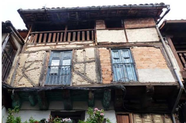
Figura 9.12. Sustitución de adobes por ladrillos en un entramado en Garganta la Olla, Cáceres.
