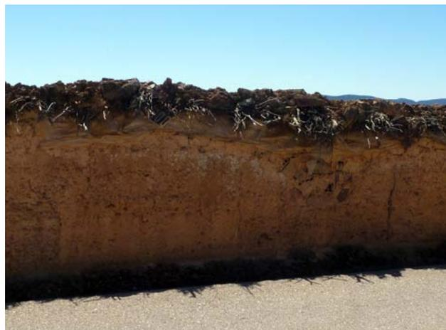
Figura 4.7. Muro de cercado sin zócalo y con barda de ramas y cespedones en Navalpino, Ciudad Real.
