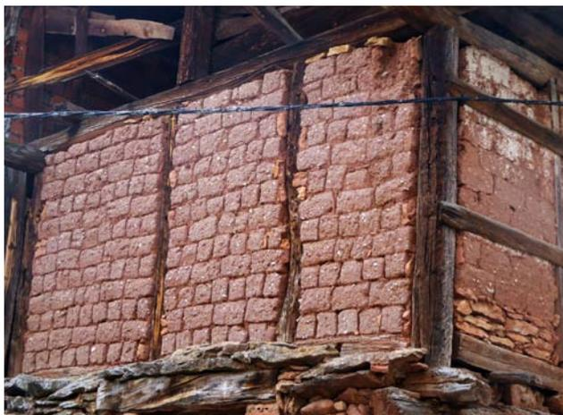
Figura 6.17. Muro entramado relleno de adobes aparejados en horizontal en una construcción en Talveila, Soria.
