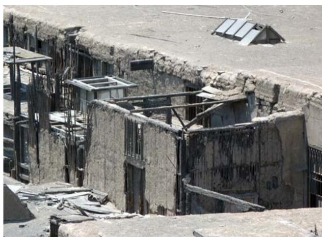
Figura 6.2. Restos de una construcción de quincha en el centro de Lima.
