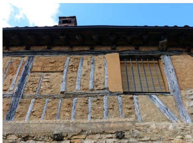
Figura 6.36. Edificio de muros entramados con relleno de mampostería encofrada en Calatañazor, Soria.
