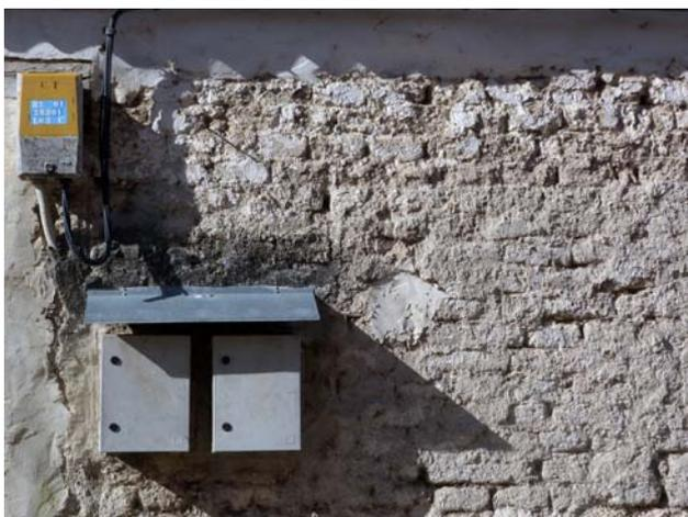
Figura 7.45. Elementos impropios instalados en una construcción de adobe en Cevico Navero, Palencia.
