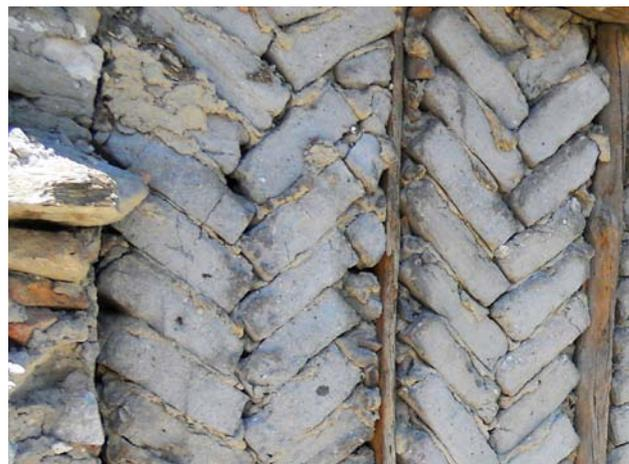
Figura 6.20. Muro entramado relleno de adobes en espiga en una construcción en Coca, Segovia.
