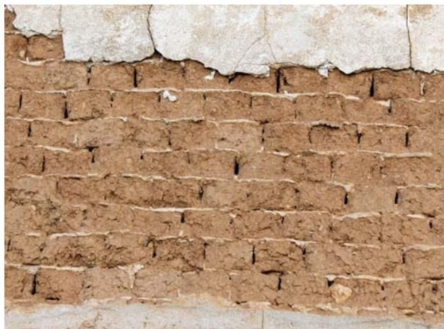
Figura 5.4. Detalle de un muro de adobe con revoco de cal en Lécerca, Zaragoza.
