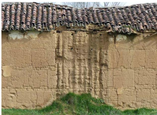
Figura 7.39. Lavado con acanaladuras por la degradación del alero en un edificio en Valderas, León.
