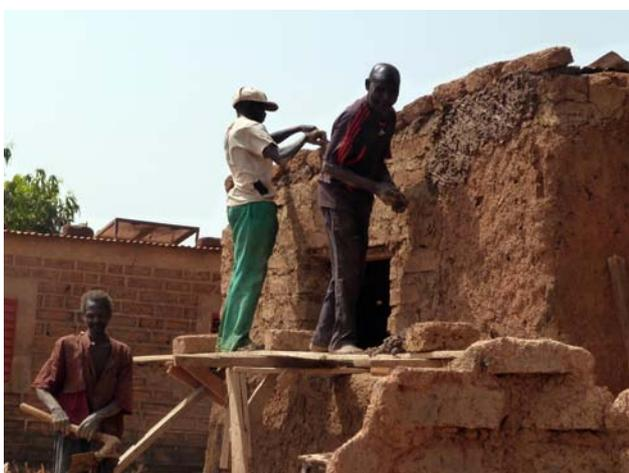
Figura 2.23. Ejecución de un revoco de torta de barro sobre una construcción de adobe.
