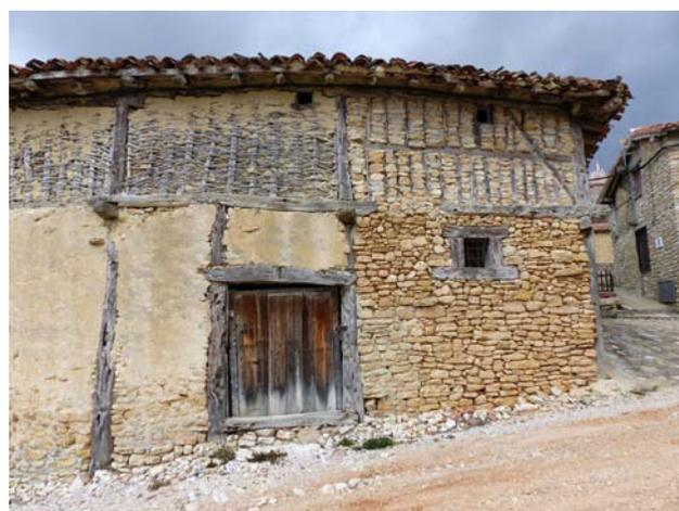
Figura 1.5. Zarzo y muro entramado en un edificio en La Cuenca, Soria.
