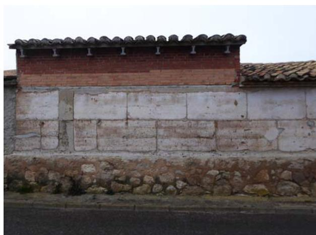
Figura 7.65. Sobreelevación de una parte de una construcción en Villarquemado, Teruel.
