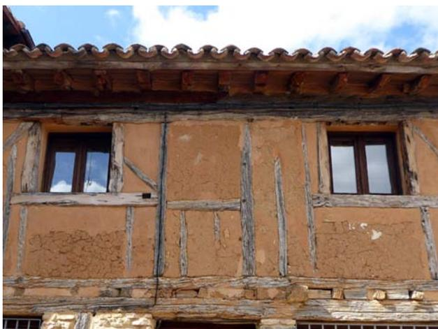
Figura 9.26. Edificio de entramado con nuevas carpinterías en Calatañazor, Soria.
