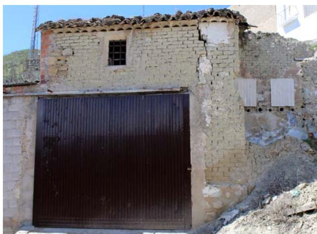
Figura 7.62. Fisuración del muro de adobe por la ampliación de un vano. Villanueva del Arzobispo, Jaén.
