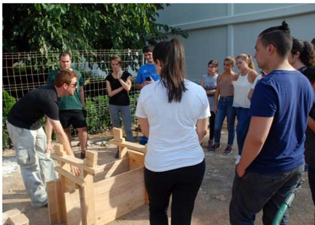
Figura 1.6. Explicación del montaje de un tapial en un curso de arquitectura tradicional de tierra impartido en la Universitat Politècnica de València en septiembre de 2017.
