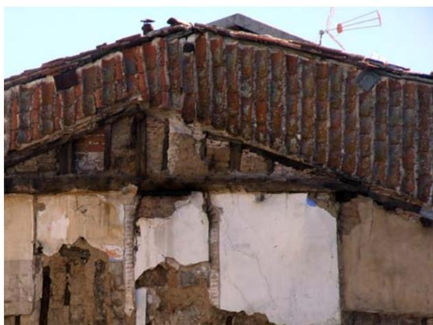
Figura 6.48. Revestimiento de tejas sobre un muro entramado en Béjar, Salamanca.
