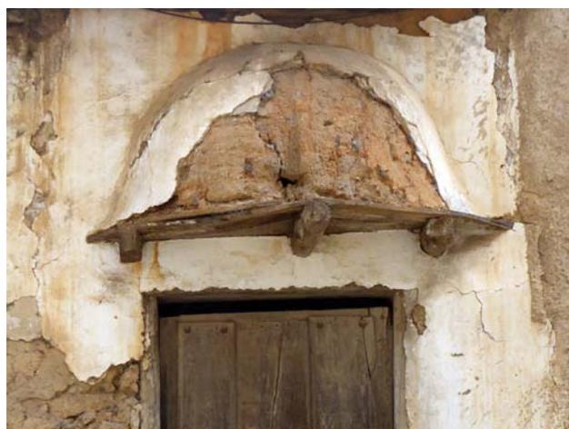
Fig. 5.66. Bóveda de horno sobre el acceso a una construcción en Miranda del Castañar, Salamanca.
