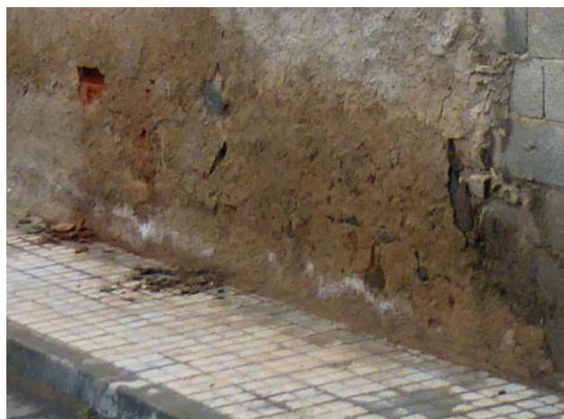
Figura 7.4. Eflorescencias en el arranque de un muro en Luco de Jiloca, Teruel.
