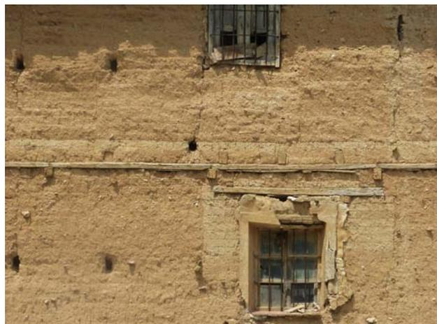
Figura 4.65. Tapia con durmientes de madera en Villada, Palencia.
