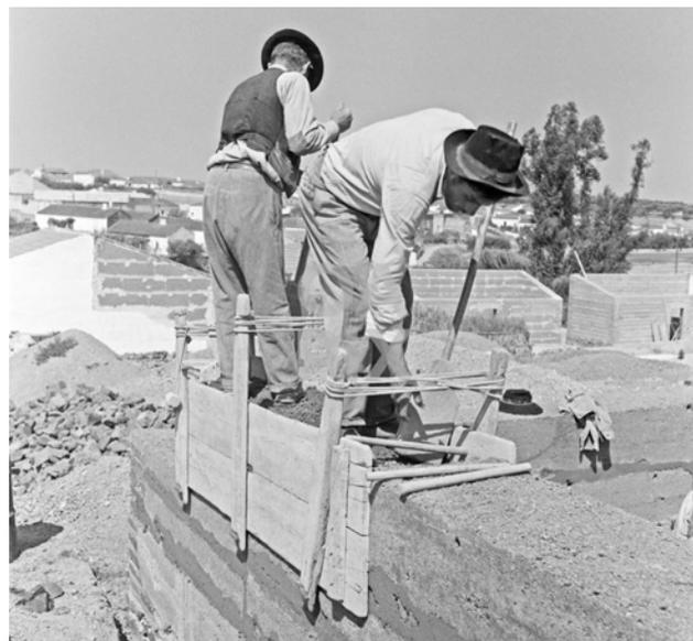
Figura 4.8. Fabricación de una tapia de tierra con pastón de yeso en los tendeles.
