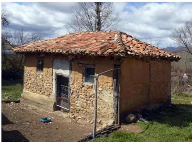
Figura 5.60. Construcción de adobe con pies derechos de madera en Roscales de la Peña, Palencia.
