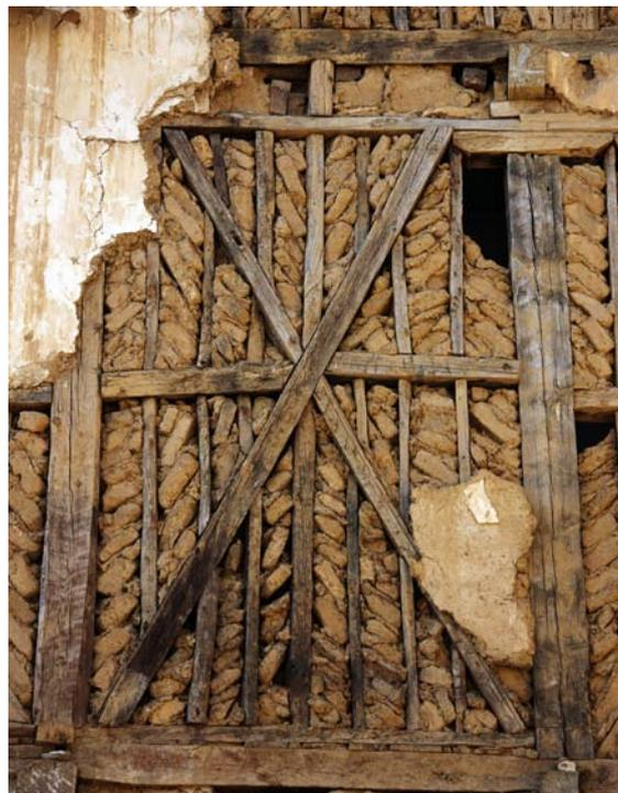
Figura 6.8. Entramado estrellado en Medina de Rioseco, Valladolid.
