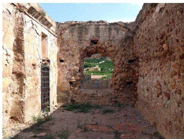
Figura 4.10. Tapia de hormigón ciclópeo en el Castillo de los Aguiló en Petrés, Valencia.
