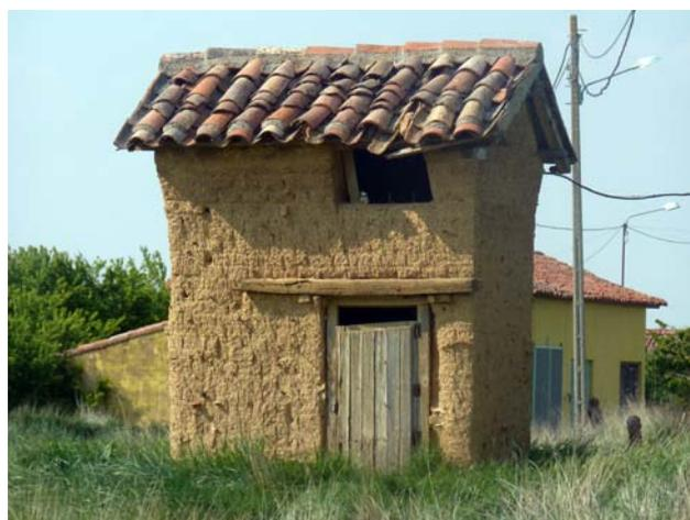
Figura 7.23. Erosión de las esquinas de una construcción en Villada, Palencia, por acción del viento.
