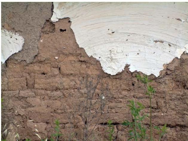
Figura 5.79. Encalado sobre un revoco de tierra en un muro de adobe en Catarroja, Valencia.
