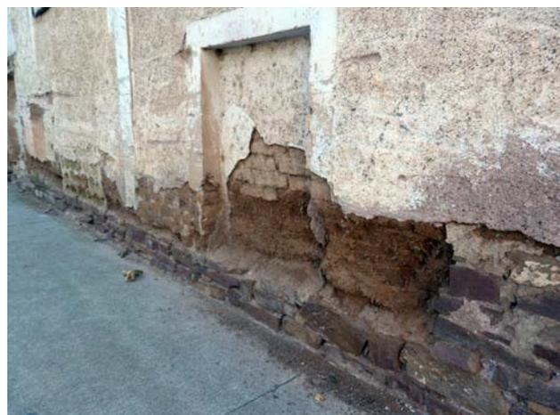
Figura 7.6. Pérdida de sección por humedad capilar en la base de un muro en Jarque, Zaragoza.
