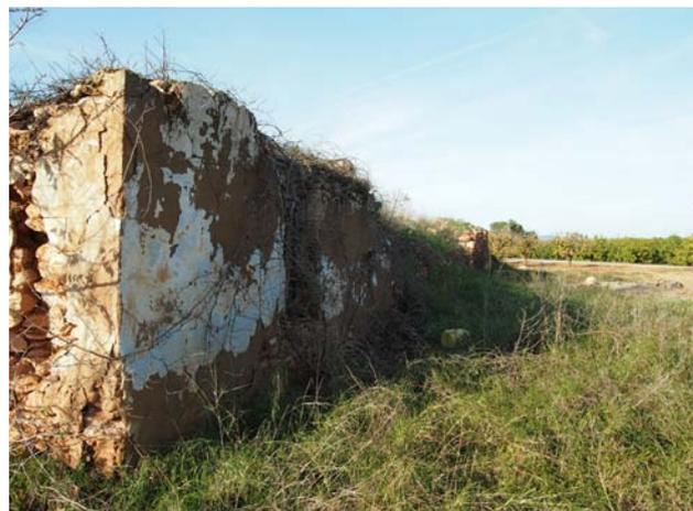
Figura 9.9. Construcción demolida hasta el primer metro de muro para evitar su colapso descontrolado. L'Alcúdia, Valencia.
