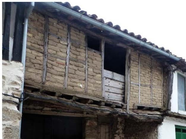
Figura 7.41. Desprendimiento del relleno en un edificio de muros entramados en La Calzada de Béjar, Salamanca.
