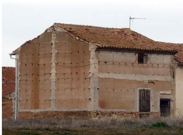
Figura 4.52. Tapia con pastón de yeso en una construcción en Monreal del Campo, Teruel.
