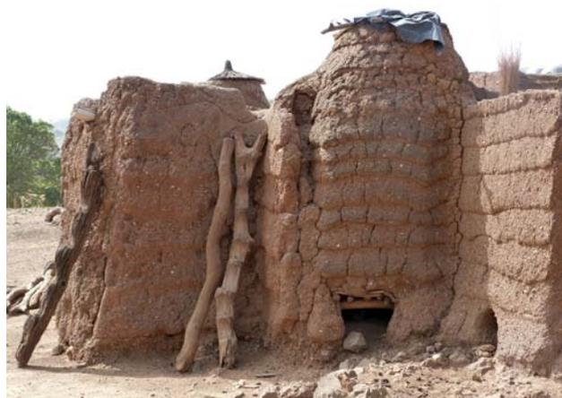
Figura 4.3. Construcciones de pared de montón en el poblado de Sansana, Burkina Faso.
