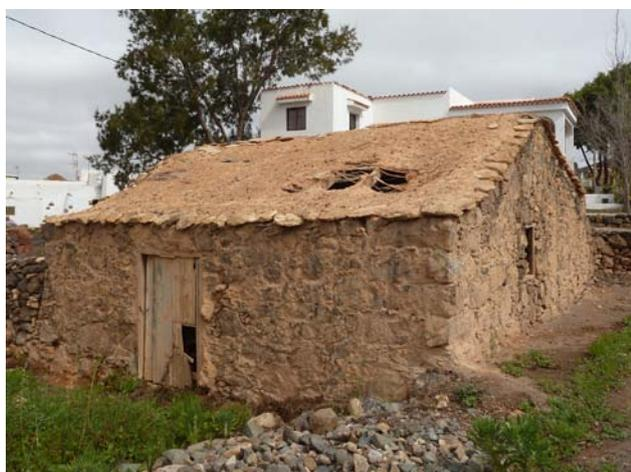
Figura 3.15. Cubierta de tierra en una construcción en Las Palmas de Gran Canaria.
