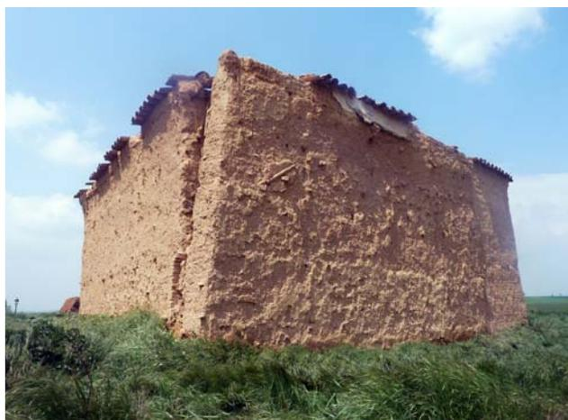
Figura 7.53. Desplome de un muro en un palomar de tapia en Palacios de Campos, Valladolid.
