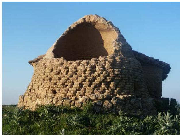
Figura 5.64. Chozo abovedado en Urueña, Valladolid. La construcción arranca como una falsa bóveda y, a partir de media altura, se desarrolla como una bóveda de horno.
