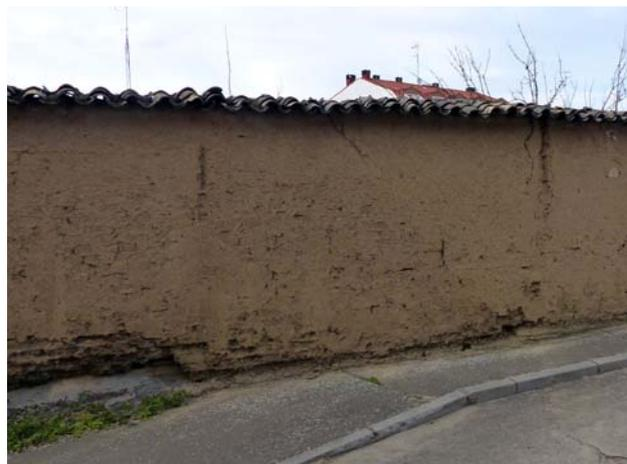
Figura 7.8. Pérdida de sección en un muro por un asfaltado inadecuado. Villalón de Campos, Valladolid.
