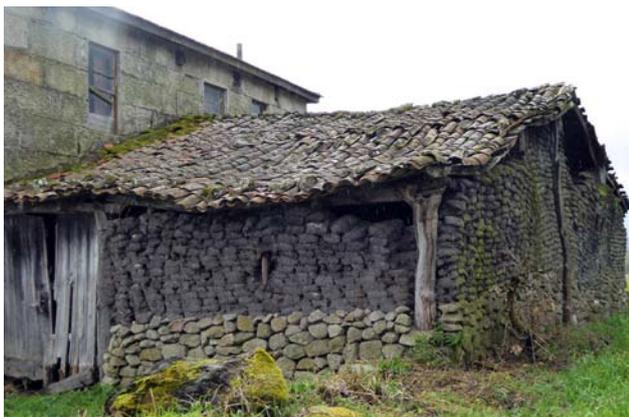
Figura 5.18. Edificio construido con pies derechos de madera y cerramiento de tepes sobre un zócalo de piedra. Lavandeira, Ourense.
