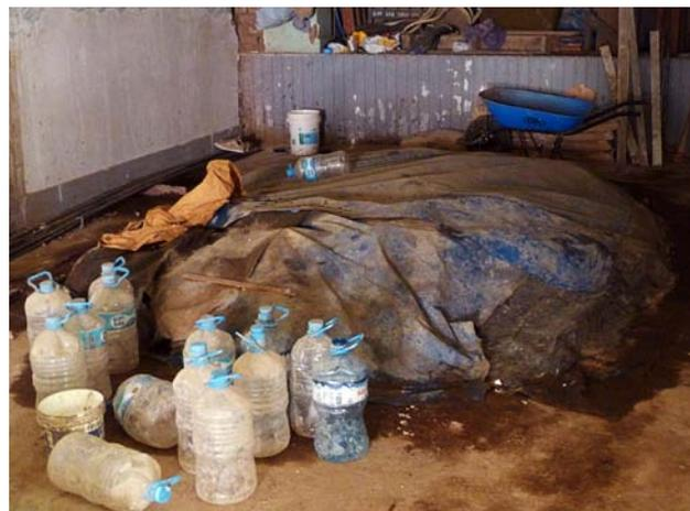
Figura 5.8. Mezcla de paja y barro cubierta con una lona para evitar la evaporación de la humedad durante el proceso de dormido.
