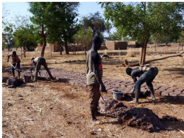
Figura 5.9. Fabricación de adobes sobre una superficie plana sobre la que se ha espolvoreado paja para evitar que, al secar, se queden pegados al suelo.
