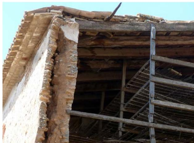
Figura 7.10. Lavado del núcleo de tierra en un muro de tapia valenciana en un edificio en Valencia.
