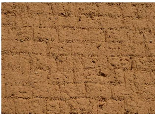
Figura 7.20. Erosión de un muro de adobe recibido con mortero de barro en Monreal de Ariza, Zaragoza.
