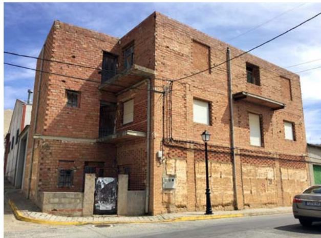
Figura 7.60. Construcción de pilares de ladrillo para evitar el aplastamiento del muro en la sobreelevación de un edificio en Villalgordo del Júcar, Albacete.
