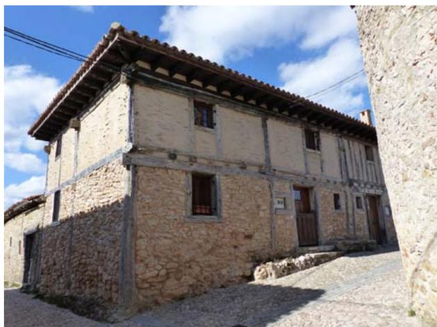
Figura 6.5. Muro tejido con planta baja de piedra en una construcción en Calatañazor, Soria.
