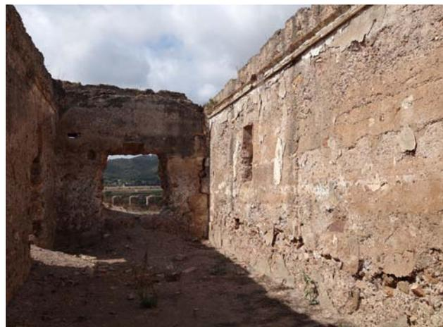
Figura 2.26. Muros de tapia de hormigón de cal en el Castillo de los Aguiló en Petrés, Valencia.
