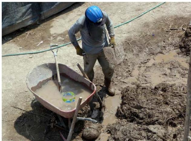
Figura 5.7. Mezclado manual del barro y la paja mediante el empleo de azada y pala.
