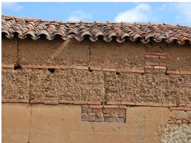
Figura 4.37. Tapia con juntas careadas con ladrillo en una construcción en Manchita, Badajoz.
