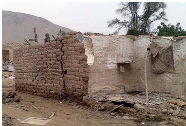
Figura 2.11. Vivienda de adobe dañada durante una riada provocada por el fenómeno de el Niño.
