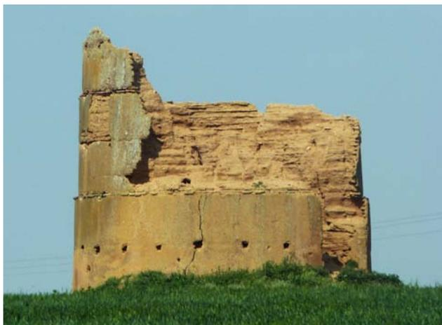
Figura 1.11. Construcción de tapia en Villada, Palencia.
