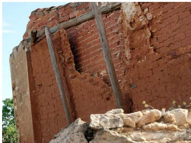
Figura 9.14. Trasdoso con fábrica de ladrillo de un muro de adobe degradado en Godos, Teruel.
