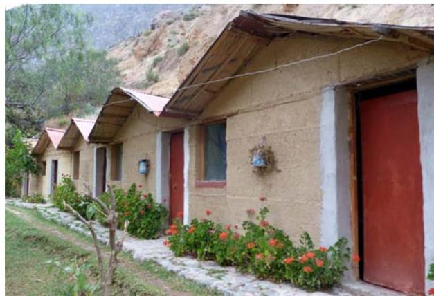
Figura 2.12. Alojamiento turístico construido con adobe y tapia en el cañón del Colca, Arequipa.
