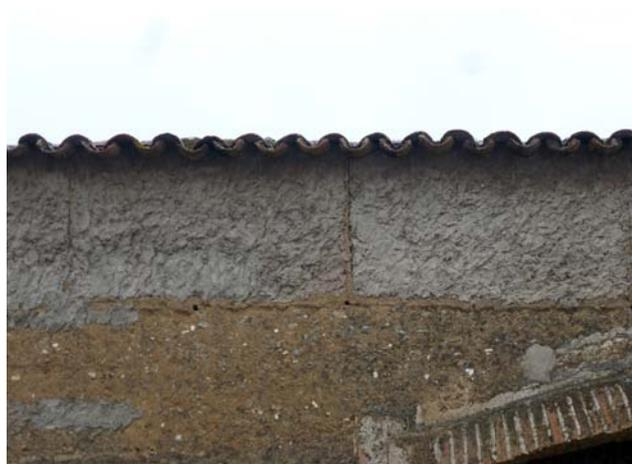
Figura 9.10. Reintegración con cemento de los paramentos de un muro de tapia en Hinojal, Cáceres.
