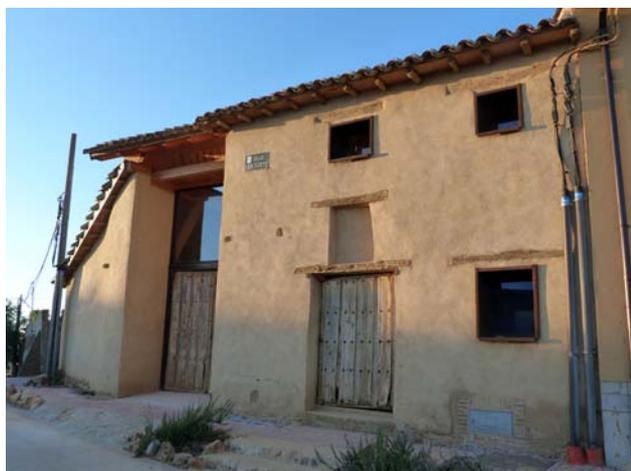
Figura 3.14. Revestimiento de tierra en una construcción de adobe en Cuenca de Campos, Valladolid.
