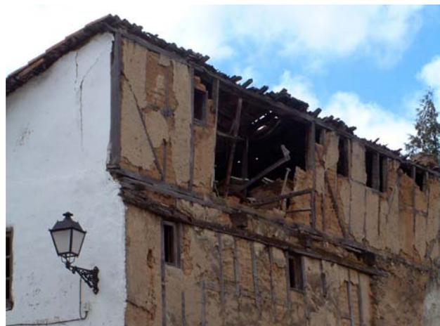
Figura 7.67. Degradación de la subestructura de madera de un entramado en Béjar, Salamanca.
