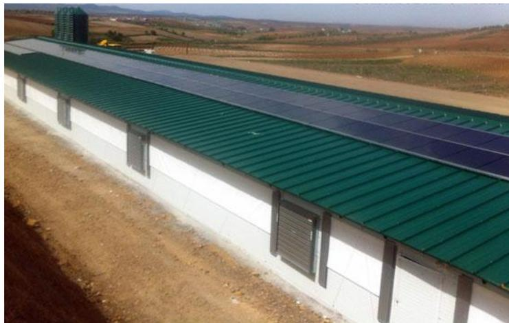
Figura 16. Placas coplanares en el tejado.
