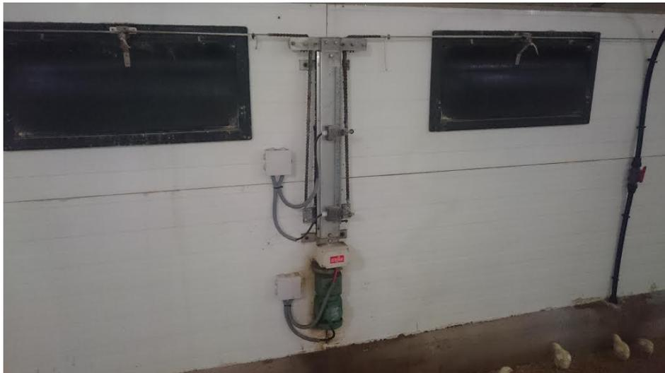
Figura 8. Motor de las ventanas
