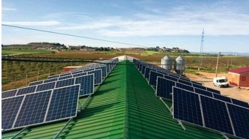
Figura 17: Placas hacia el sur en el tejado.
